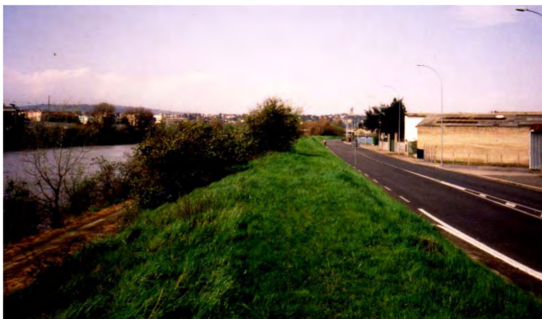
Photo 33. Le tronçon exhaussé de la digue de halage
