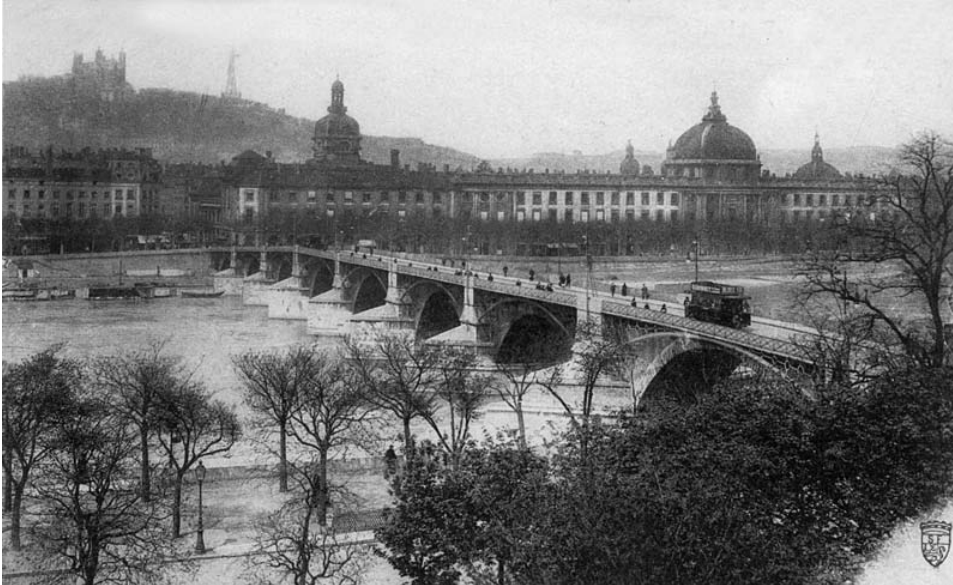
Photo 25. Le vieux pont de la Guillotière (XIe s.) et ses piles imposantes
