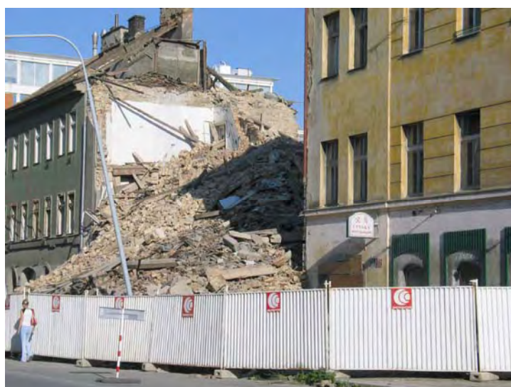
Photo 2. Dégâts dans le quartier pragois de Karlin
