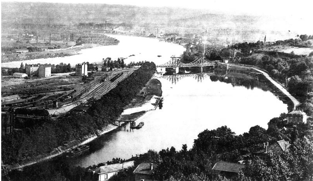
Photo 20. Le confluent au début du XXe siècle
