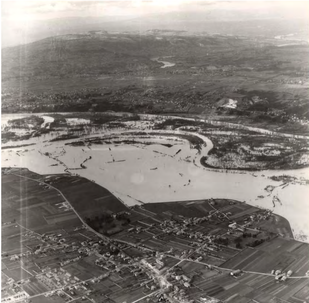
Photo 35. La digue de Vaulx-en-Velin lors de la crue de février 1957.
