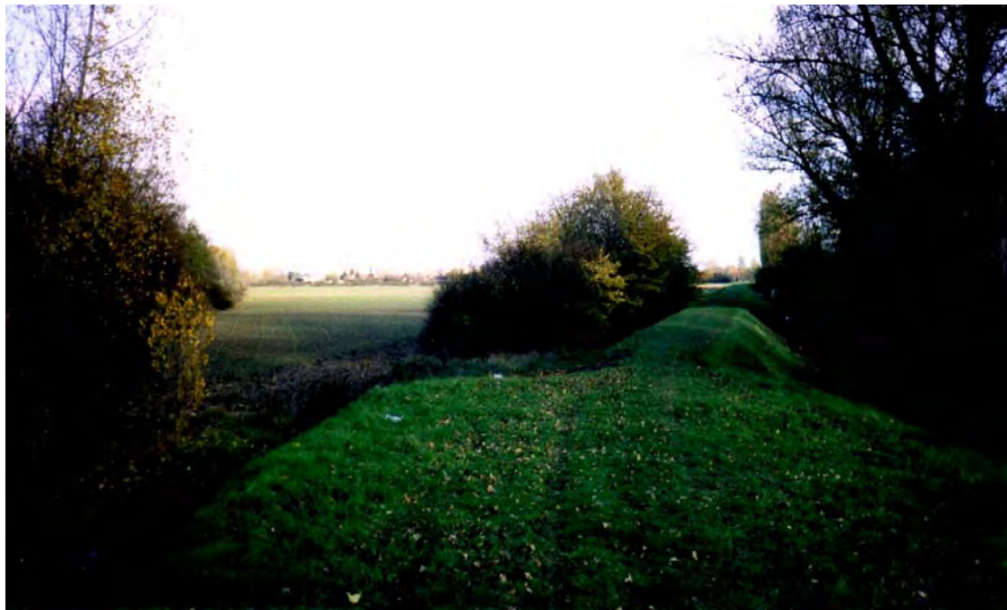
Photo. 34. Le tronçon reculé vers le nord de la digue de Vaulx-en-Velin.
