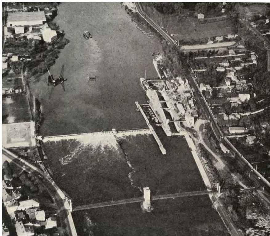
Photo 30. Le chantier de reconstruction du barrage de Couzon en 1965
