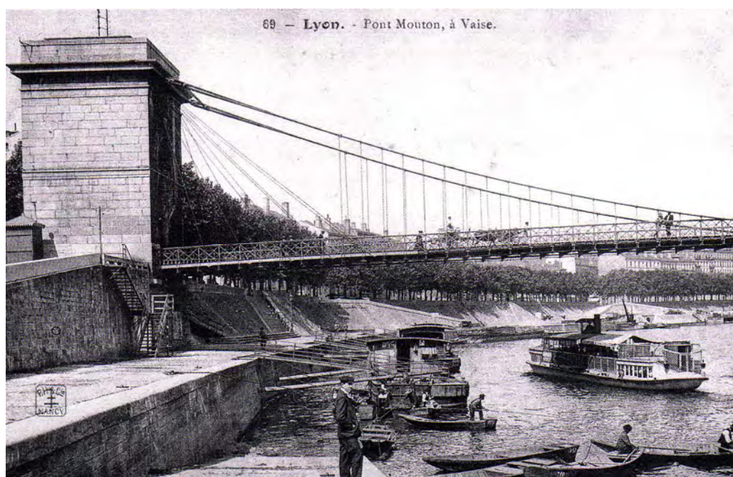
Photo 13. Les quais de Vaise au droit du pont Mouton
