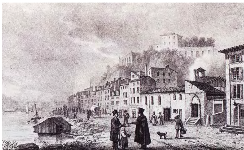
Fig. 17. Le quartier de Bourgneuf en rive droite de la Saône après la destruction des maisons et avant la construction du quai.
