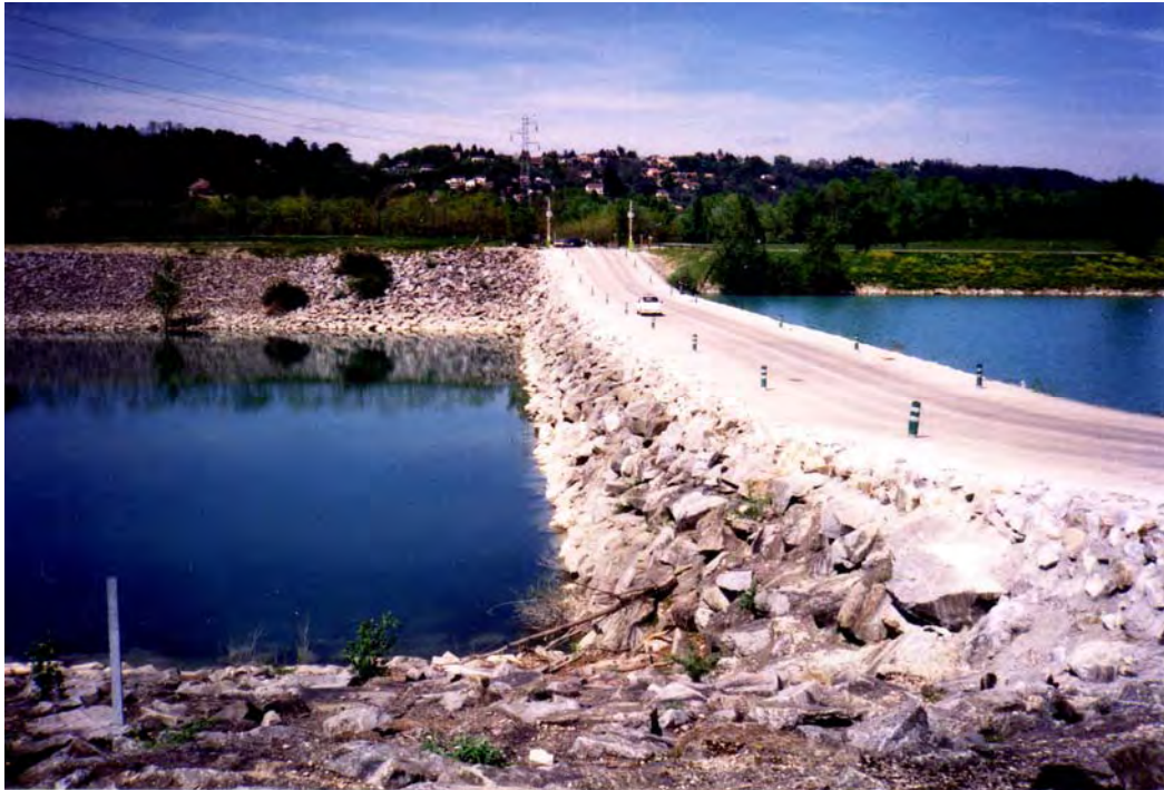
Photo 38. Le seuil fixe situé à l'exutoire du lac principal de Miribel-Jonage.
