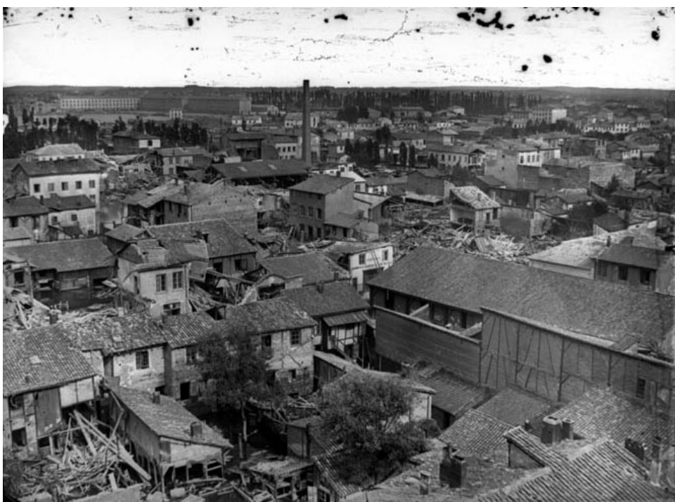
Photo 10. La rive gauche du Rhône après le passage de la crue.
