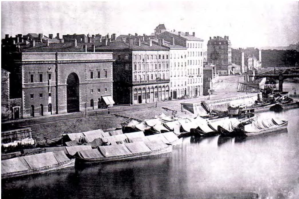
Photo 16. Emmarchement au niveau du quai Tilsitt avant la reconstruction des quais
