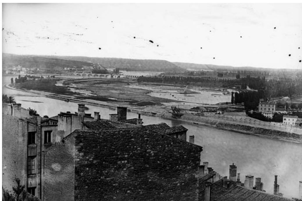
Photo. 12. La partie amont de la rive gauche avant la construction du quai de la Tête d'Or et de la digue des Brotteaux
