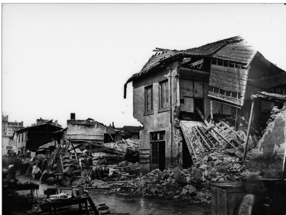
Photo 11. Détail de l'endommagement au bâti
