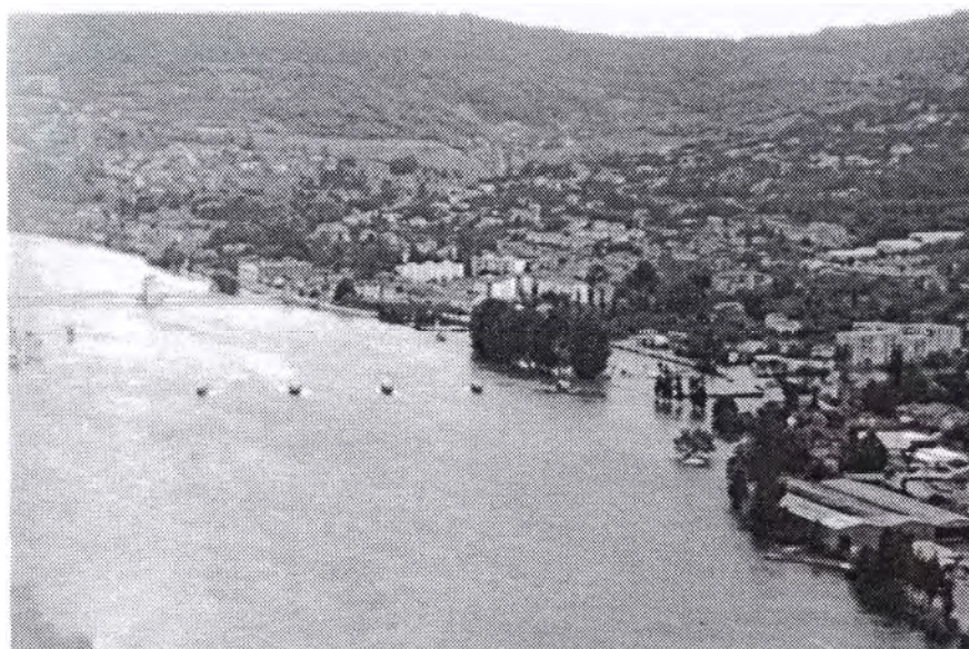
Photo 31 . Le barrage de Couzon couché en temps de crue
