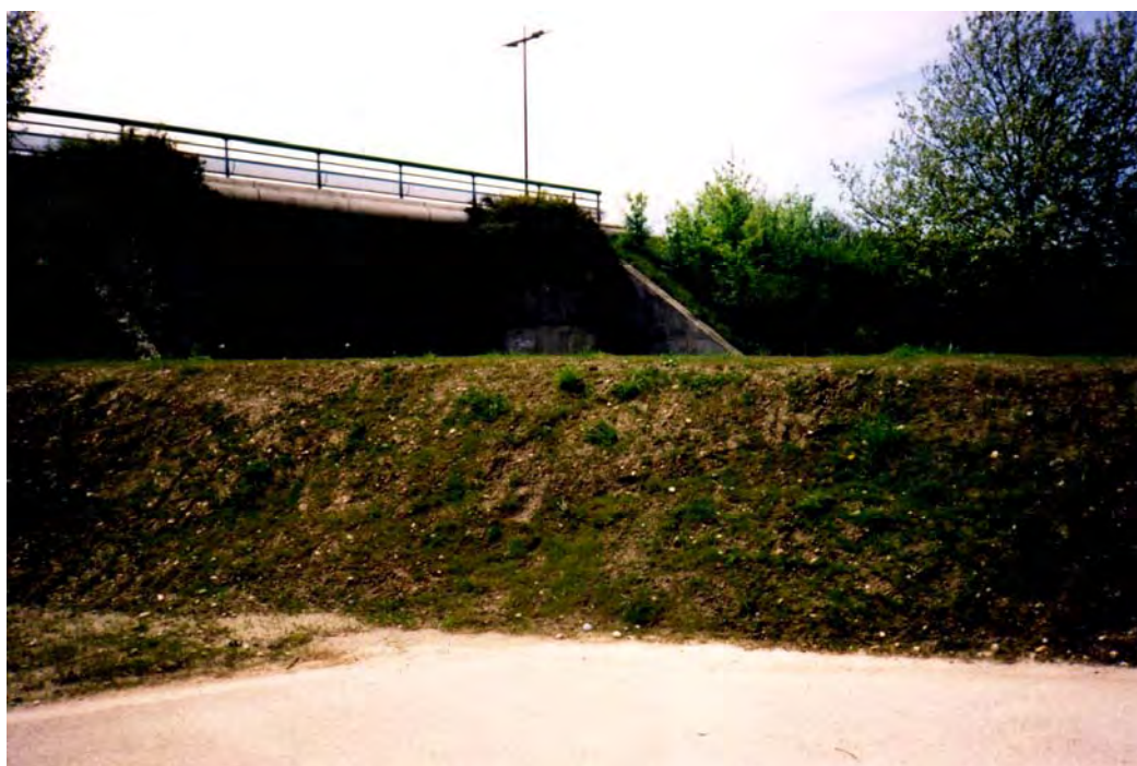
Photo 36. Le passage inférieur n°5 sous le remblai de la Rocade-Est et la contre-digue construite en avant de la digue
