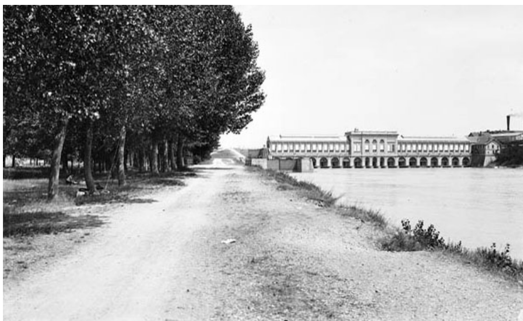
Photo 32. La digue de halage en rive droite du canal de Jonage
