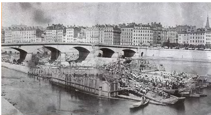
Photo 15. Le dérochement au droit du pont de Nemours au milieu du XIXe s.
