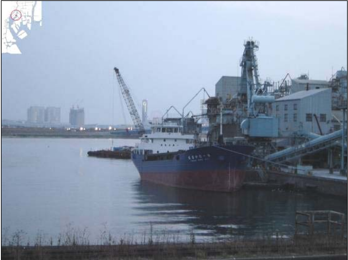
Photo 13 : Cimenteries Onoda 小野田 (liées au groupe Mitsui) sur la partie sud-est du terre-plein Harumi. © Scoccimarro 2007.
