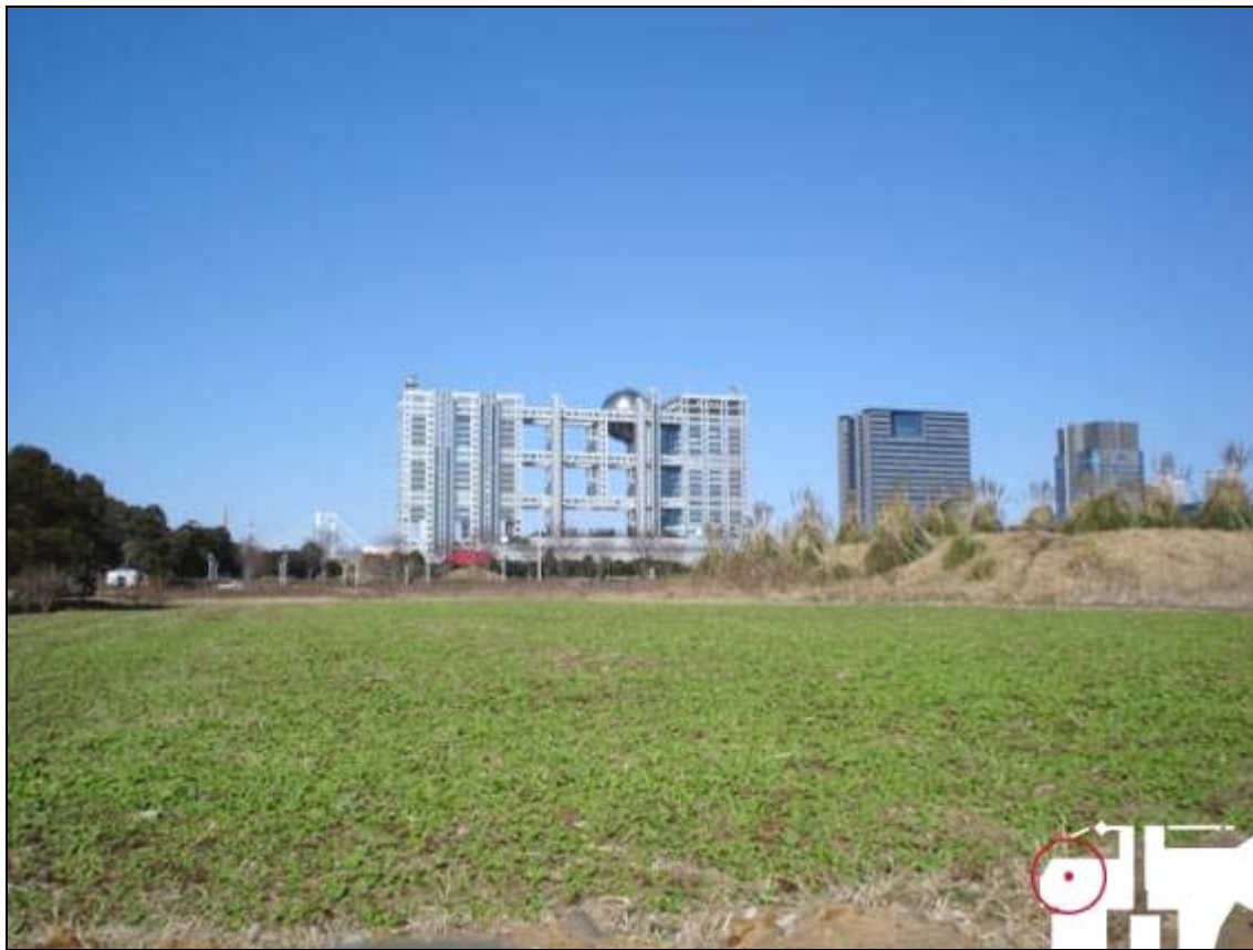
Photo 6 : Immeuble Fuji terebi, vu de l'arrière, Daiba RFT. © Scoccimarro 2004.
