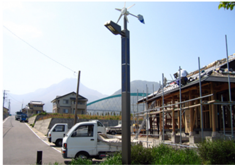
Photo 1-2 – Constructions en cours sur le triangle d'Annaka
