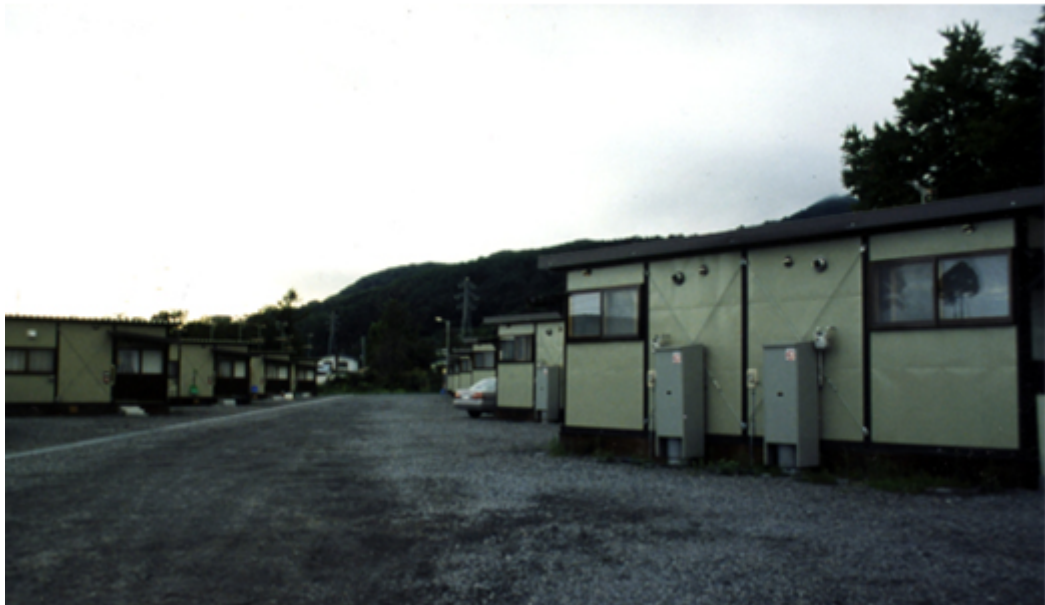
Photo 1-6 – Logements préfabriqués pour évacués à Abuta
