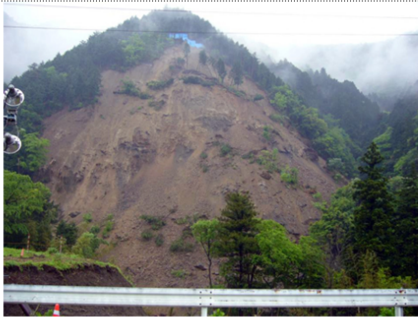
Photo 6-1 – Glissement de terrain de Higashi Yokoyama (Gifu), le 17 mai 2006.
