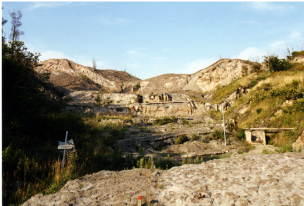
Photo 7-11 – La route nationale 230 à Abuta : « graben road », à l'aplomb du dôme soulevé en 2000
