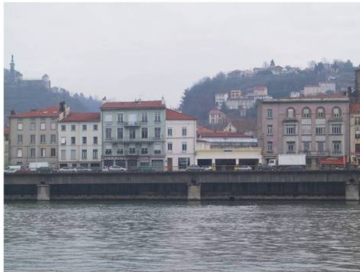
Rocade et parkings à Avignon
