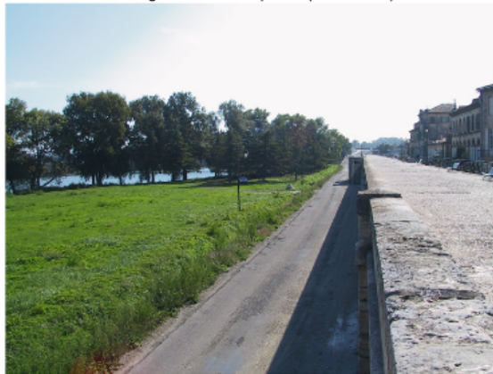
Le sommet de la Banquette, espace de promenade doté de bancs
