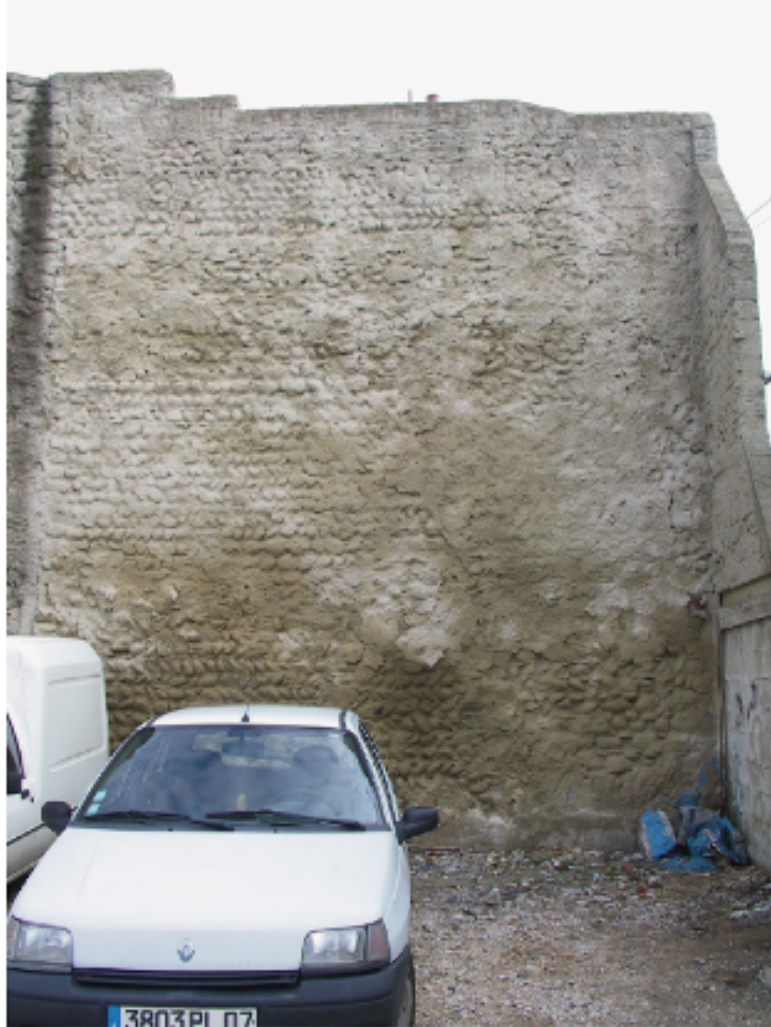
Figure 24. Les galets du Rhône dans le bâti
