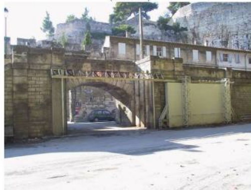
porte métallique d'une habitation (Beaucaire)
