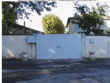
Figure 25. L'influence des crues sur le bâti rhodanien
