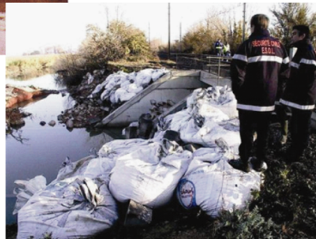
Figure 70. Les trémies : point d'entrée des eaux de l'inondation du Trébon
