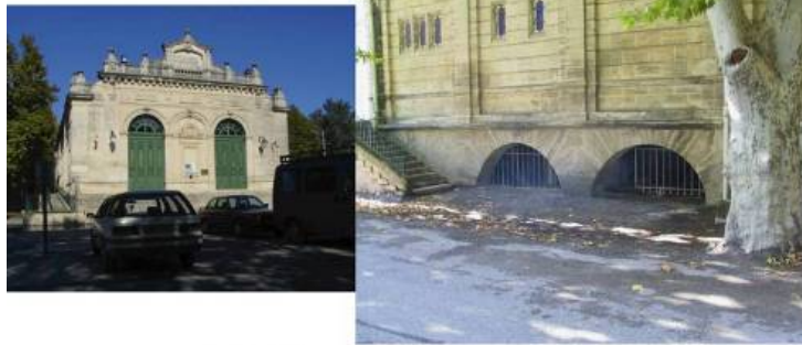
porte métallique devant la digue de la Banquette (Beaucaire)
