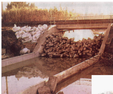
LE COLMATAGE DES TREMIES
