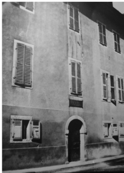
L'entrée du collège de Thônes rue des Clefs.
