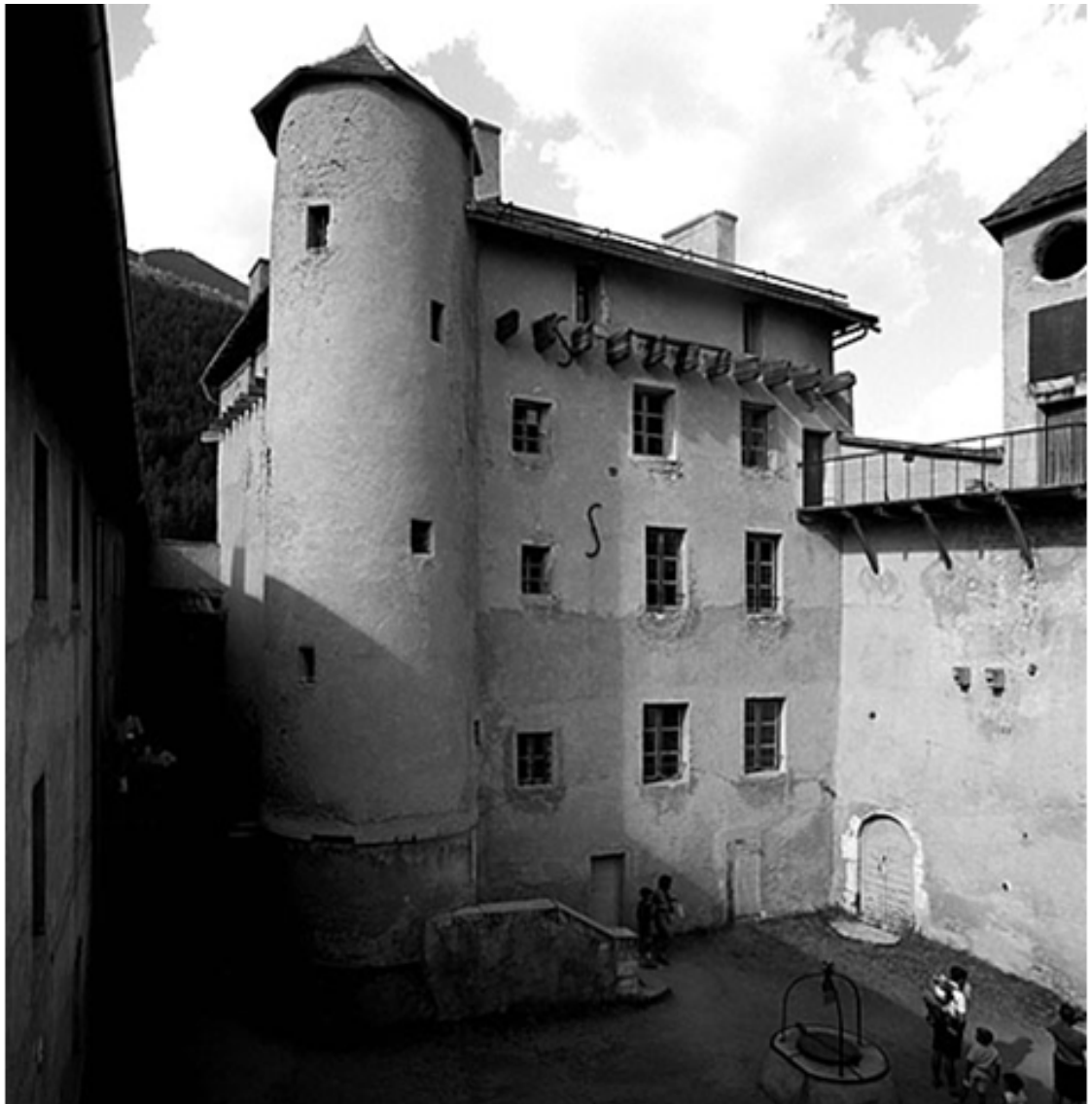
Doc. 143. Façade sud du donjon de Château-Queyras © Inventaire général
