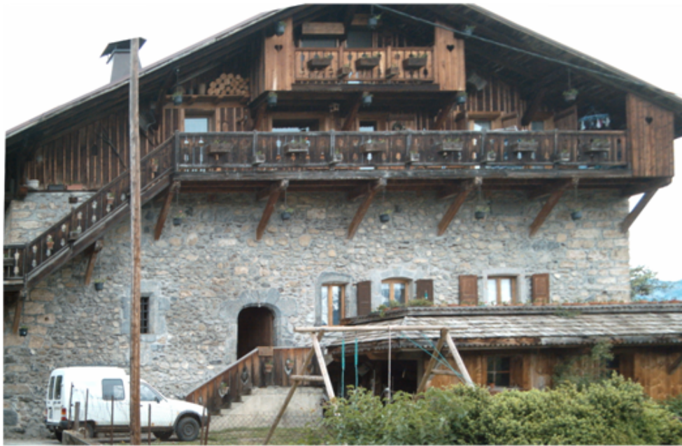
Doc. 104. Façade sud-est du logis du château de Sallanches
