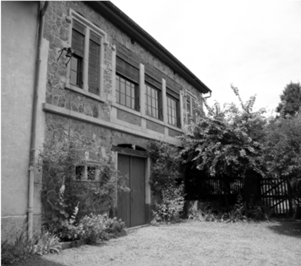
Fig.15-2 : La maison de Villerest aujourd'hui. (Photographie de l'auteur).
