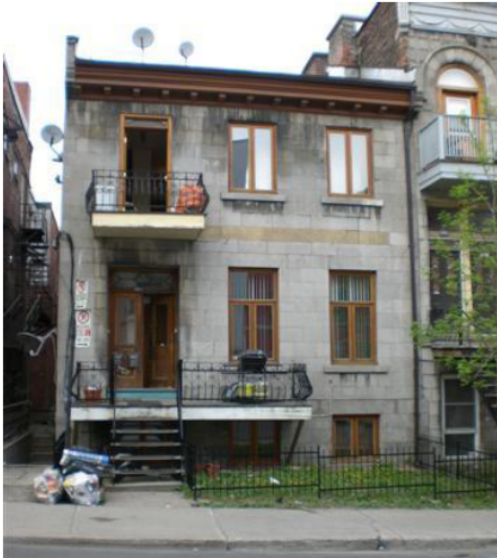
Un exemple du bâti vétuste de la rue Alexandre de Sève, Village.
