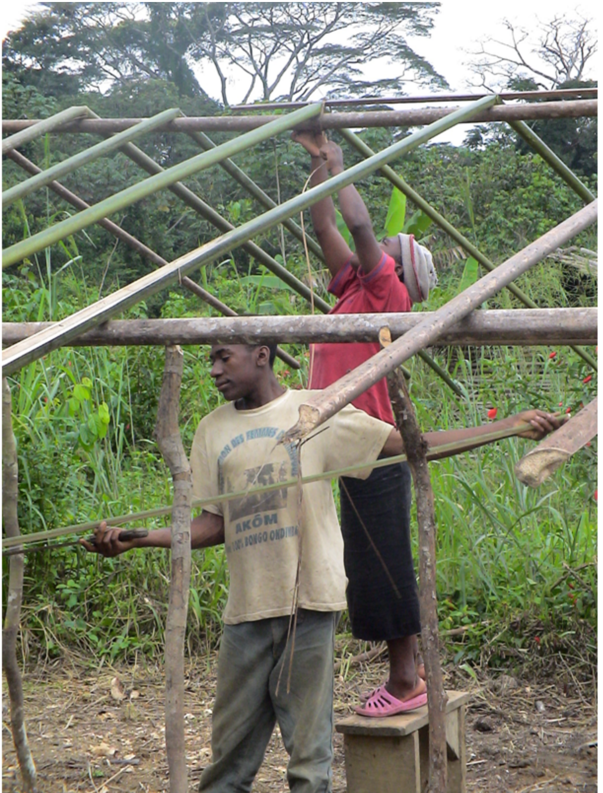
Photo 34 : Fabrication de la structure d'une maison.
