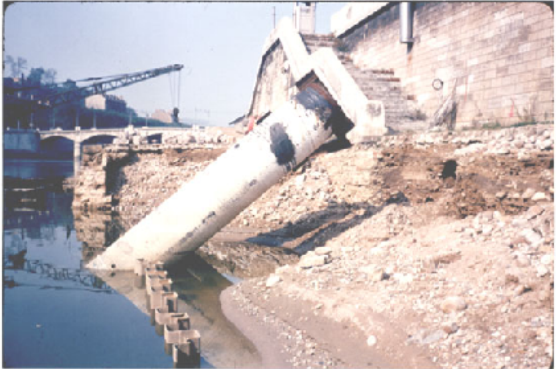
Figure. 28 - Le bas-port du quai St-Vincent éventré par les conduites, vu de l'est, sur la droite la stratigraphie de remblais étudiée par A. Grange.
