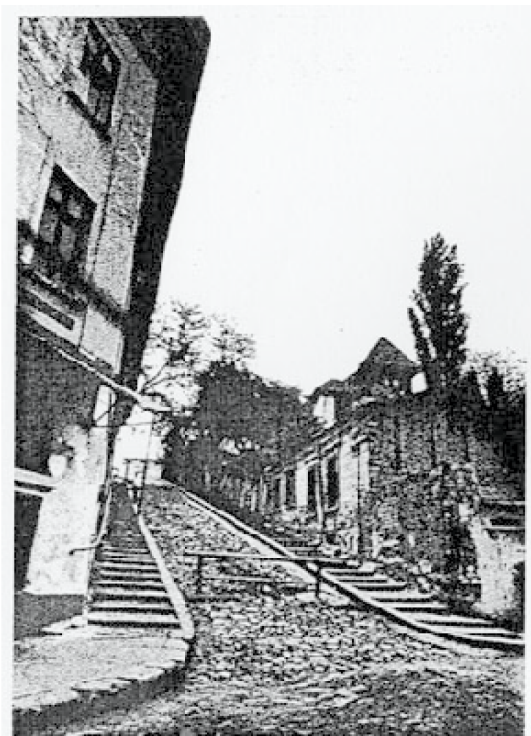
Fig. 19 — Zona Puțului cu Apă Rece — Pelerinilor.
