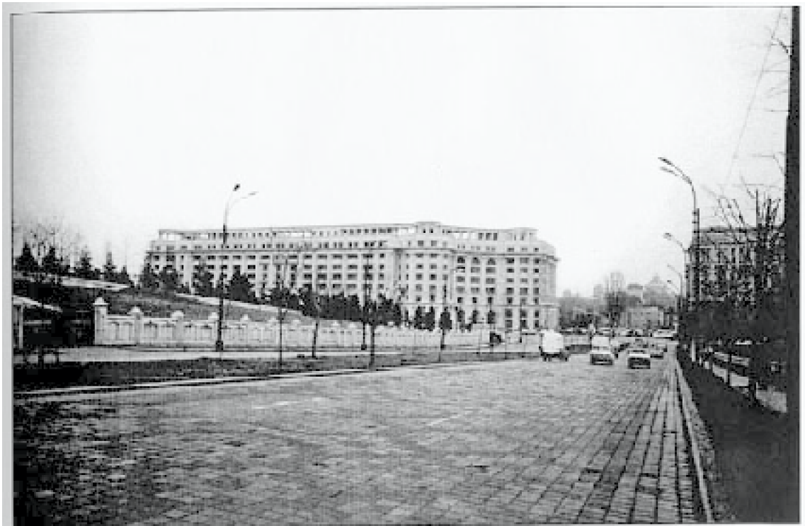
Redescente vers le boulevard Liberté. Ethnographie d'un monument. Récits d'une fondation contemporaine - le Centre Civique de Bucarest.
