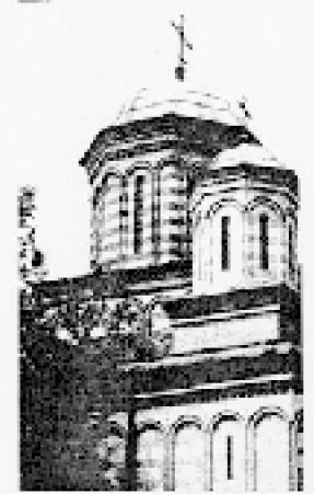
Fig. 5 — Exterior Mănăstirea Mihail Vodă.
