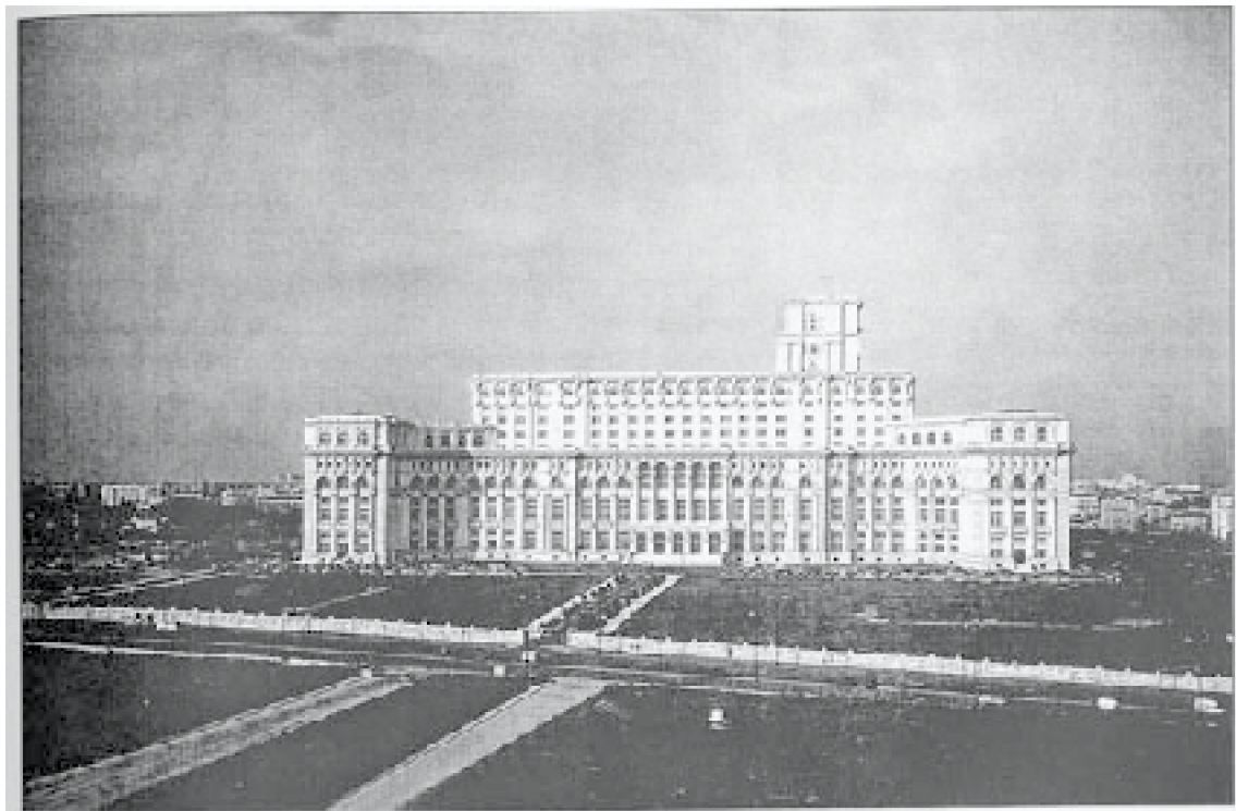
Palais du Peuple, façade sud.
