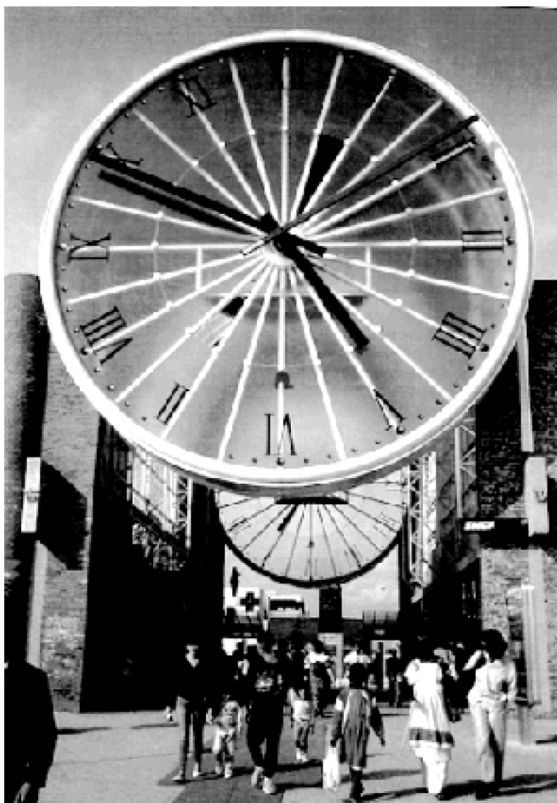
Figure 54 - La Gare de Cergy-St Christophe (photo Conseil Général Val d'Oise)
