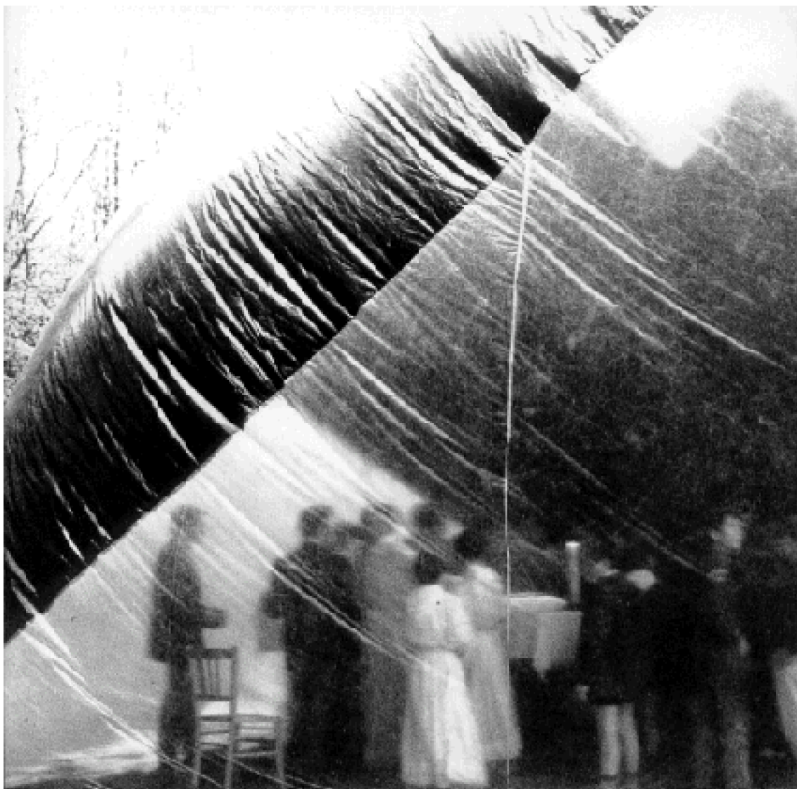
Fig. 206 : L'église gonflable de Montigny-lès-Cormeilles en 1970. Vue de l'autel depuis l'extérieur.
