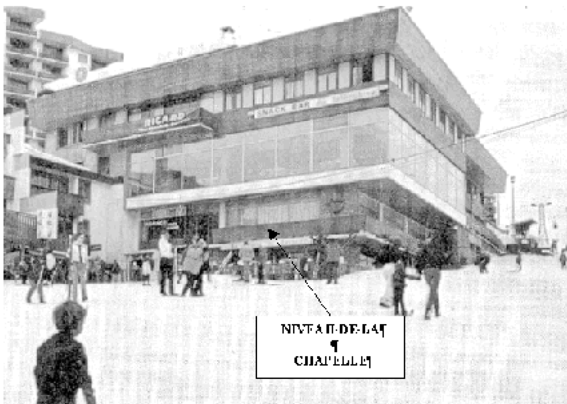
Fig. 95 : Vue du Centre d'accueil de Merlette-Orcières, 1973. Geneviève Lions-Colboc architecte. Aménagements : Père Mathonnet.
