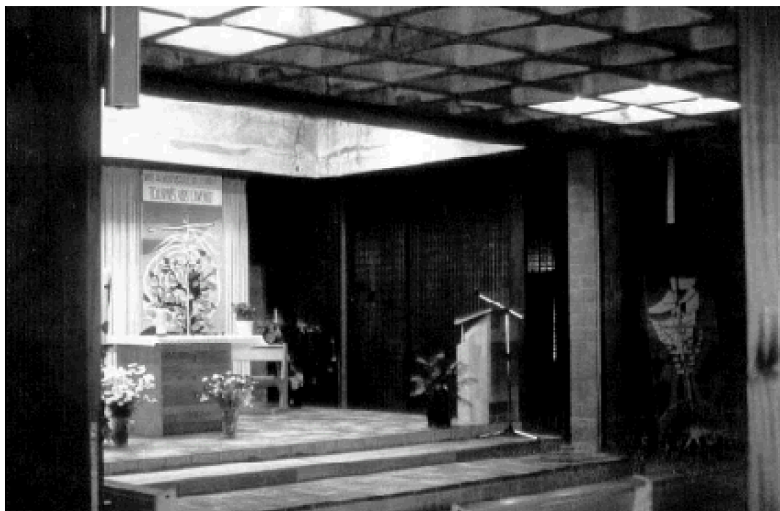
Fig. 158 : vue du chœur et du maître-autel de l'église Saint-Jean-Bosco. On distingue le système de caissons préfabriqués en béton qui constitue la couverture de l'édifice.
