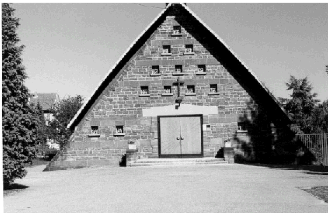
Fig. 115 : Vue du parvis de l'église du Christ-Roi à Forbach. E. Voltz et Ch. Sommermatter architectes, J. Prouvé constructeur.
