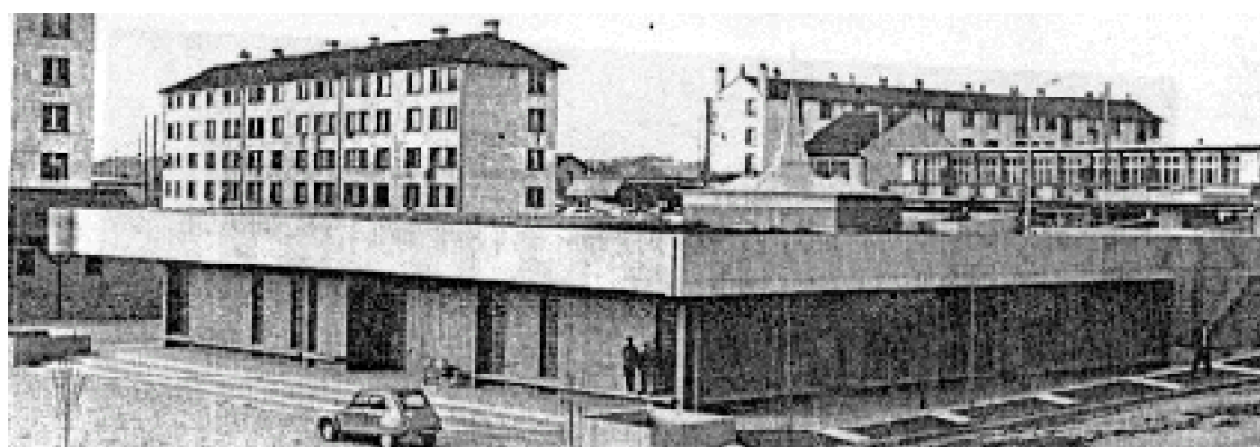
Fig. 159 : L'église Saint-Jean-Bosco en 1969. On notera le lanterneau d'origine, d'aspect élancé.
