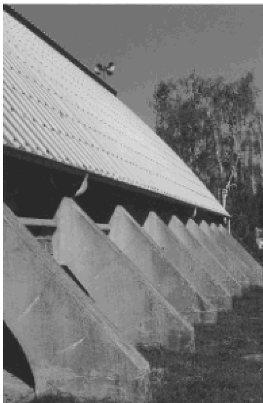
Fig. 113 : Détail des arcs-boutants en béton armé de l'église du Christ-Roi à Forbach. E. Voltz et Ch. Sommermatter architectes, J. Prouvé constructeur.
