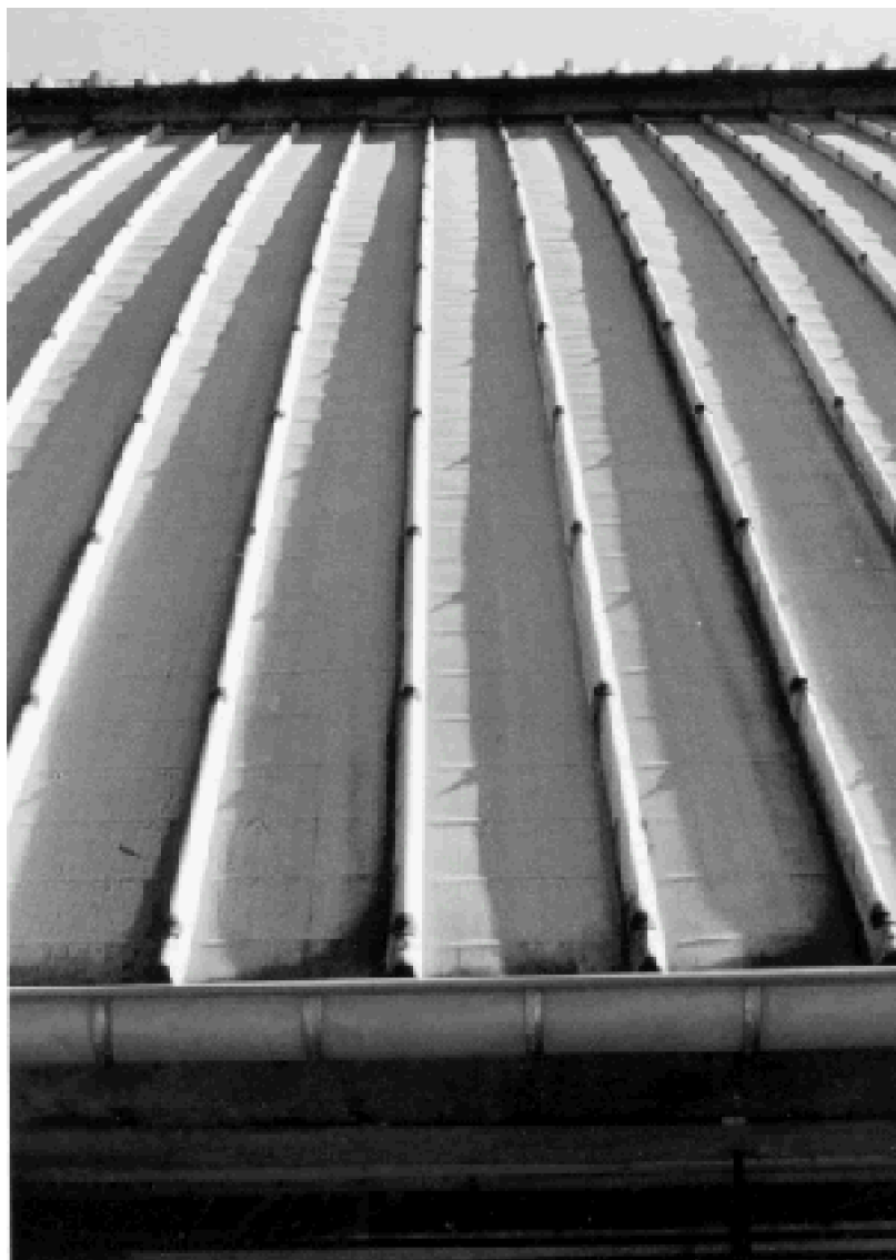
Fig. 105 : Bacs d'aluminium de la couverture de l'église de Behren-Lès-Forbach. E. Voltz et Ch. Sommermatter architectes, J. Prouvé constructeur.
