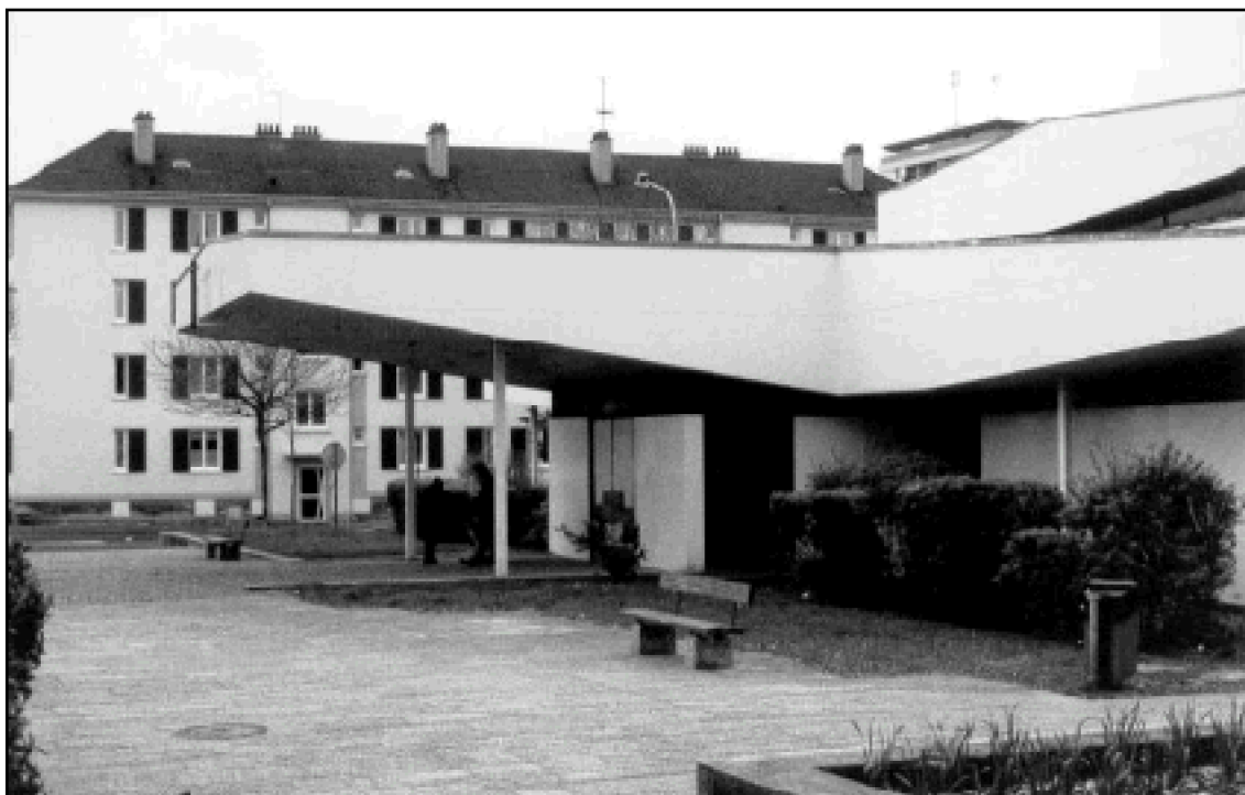
Fig. 185 : Vue du porche d'entrée du Centre Paroissial Saint-Joseph-Ouvrier à Creil. Etat actuel. Jacques Prioleau architecte, 1968.
