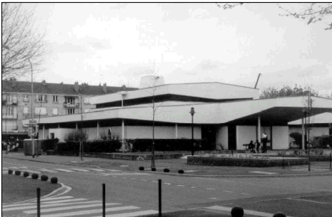
Fig. 186 : Le Centre Paroissial Saint-Joseph-Ouvrier à Creil. Etat actuel. Jacques Prioleau architecte, 1968.
