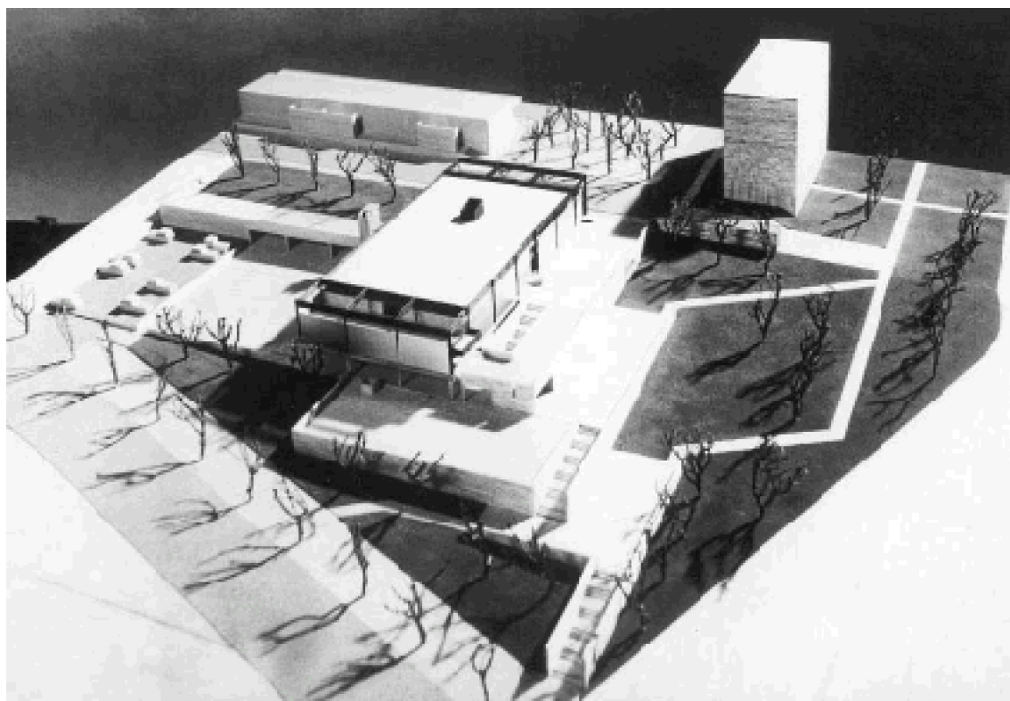
Fig. 131 : Vue cavalière de la maquette de l'église Saint-Luc. On distingue les panneaux revêtus d'aluminium enchâssés entre les poteaux de couleur sombre de l'ossature métallique.
