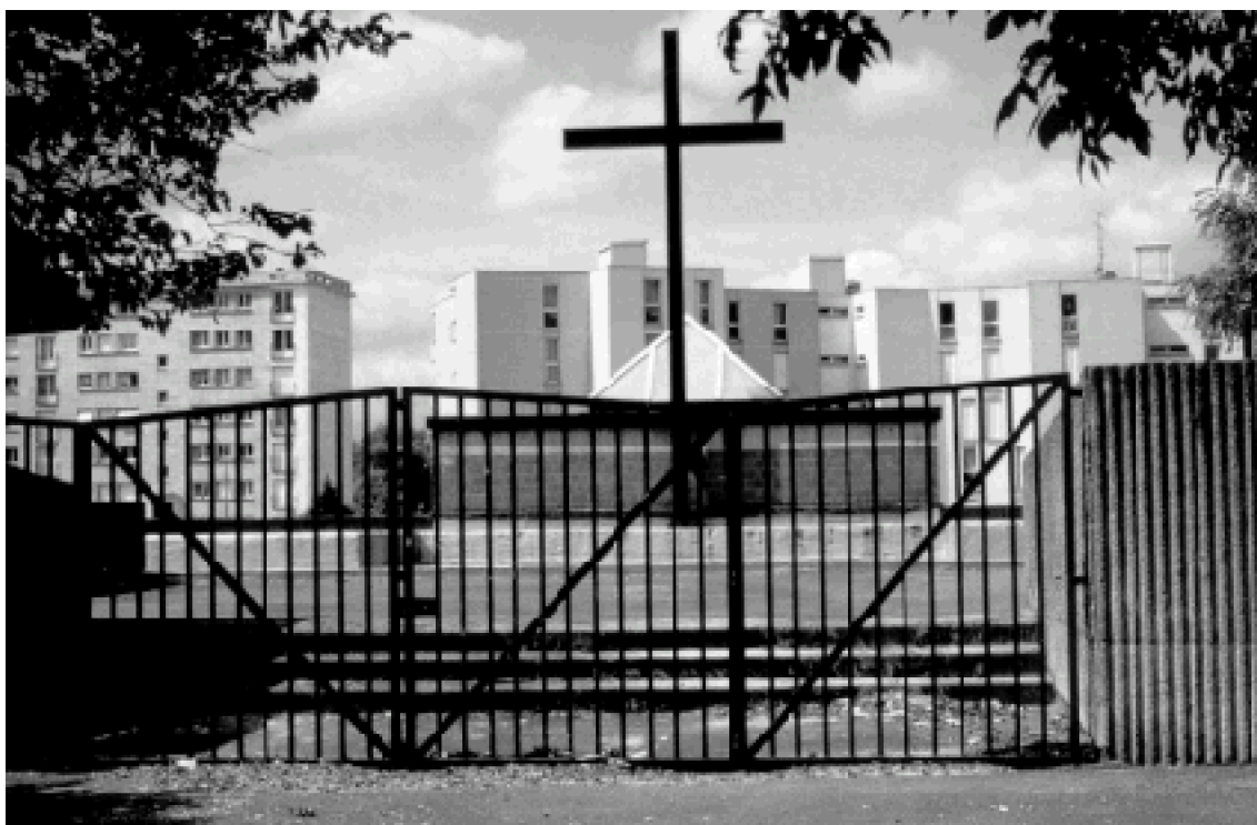
Fig. 163 : vue de l'accès au toit terrasse formant placette.
