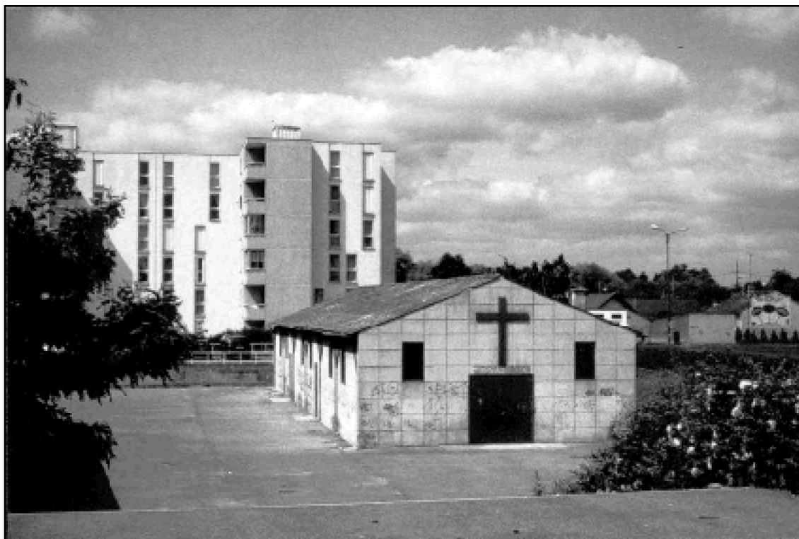
Fig. 150 : église provisoire de la ZUP Pierre de Collinet. (Photo de l'auteur)
