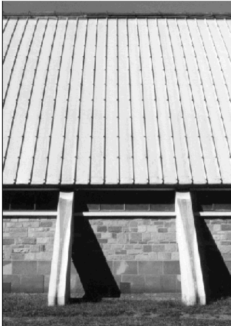
Fig. 104 : Couverture, arcs-boutants et muret de clôture de l'église Notre-Dame de Fatima à Creutzwald. E. Voltz et Ch. Sommermatter architectes, J. Prouvé constructeur.
