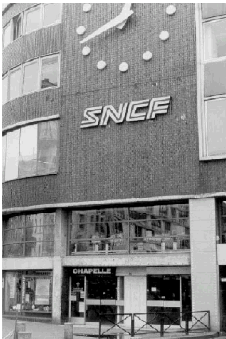
Fig. 79 : Chapelle Saint-Bernard, gare Montparnasse, Paris. Vue de l'accès extérieur.
