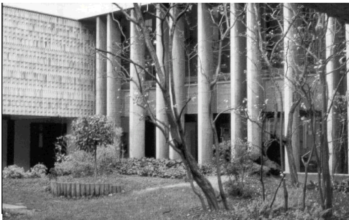
Fig. 56 : Vue du « cloître » prise vers l'arrière des bureaux situés rue Lapparent (derrière les piles de béton). Plans et conception de François Delage, avec la collaboration de R. Coulon, et P. Henry architectes.
