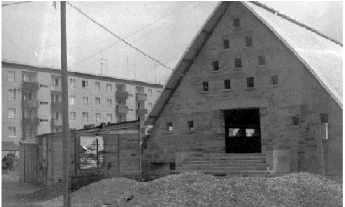
Fig.117 : Photo de l'église Notre-Dame à Behren-Lès-Forbach en chantier. E. Voltz et Ch. Sommermatter architectes, J. Prouvé constructeur.
