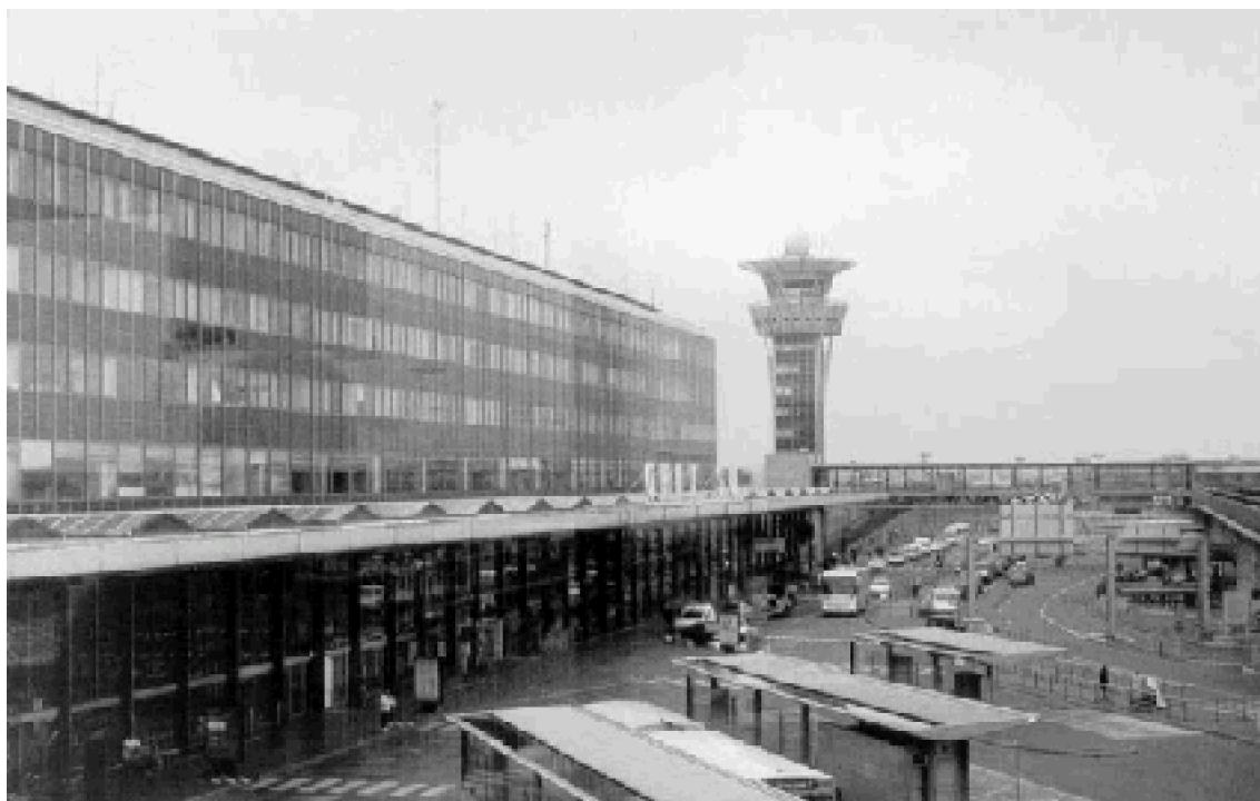
Fig. 84 : Aéroport d'Orly-Sud. Henri Vicariot, architecte (1957-1961).
