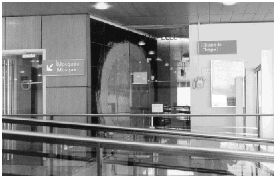
Fig. 85 : Aéroport d'Orly-Sud. Entrée de la chapelle oecuménique.
