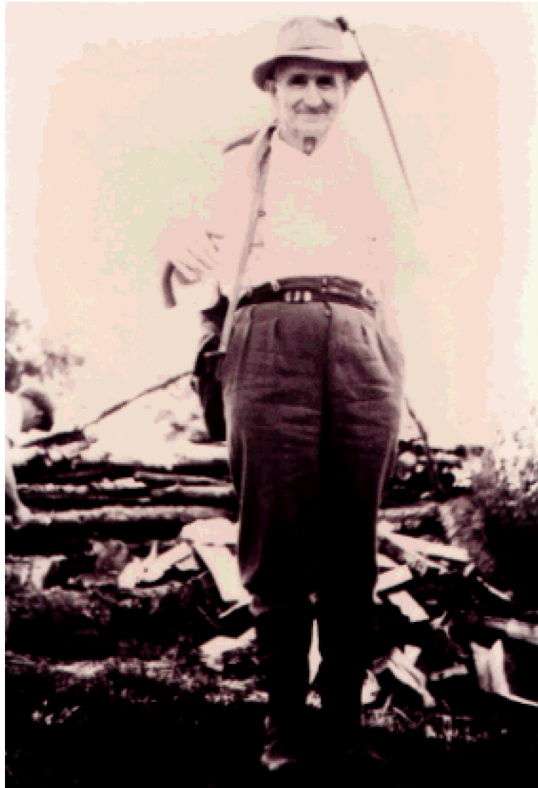
Retour de travaux de débroussaillage des plantations Août 1970
