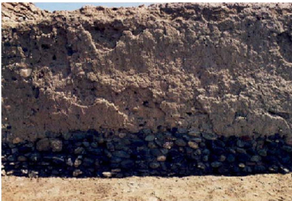
Fig. 156 : Murs en briques crues. A : Un mur en briques crues d'une maison traditionnelle de Ribā Shīkir. La superstructure en terre repose sur un solin constitué de galets liés à un mortier de terre.
