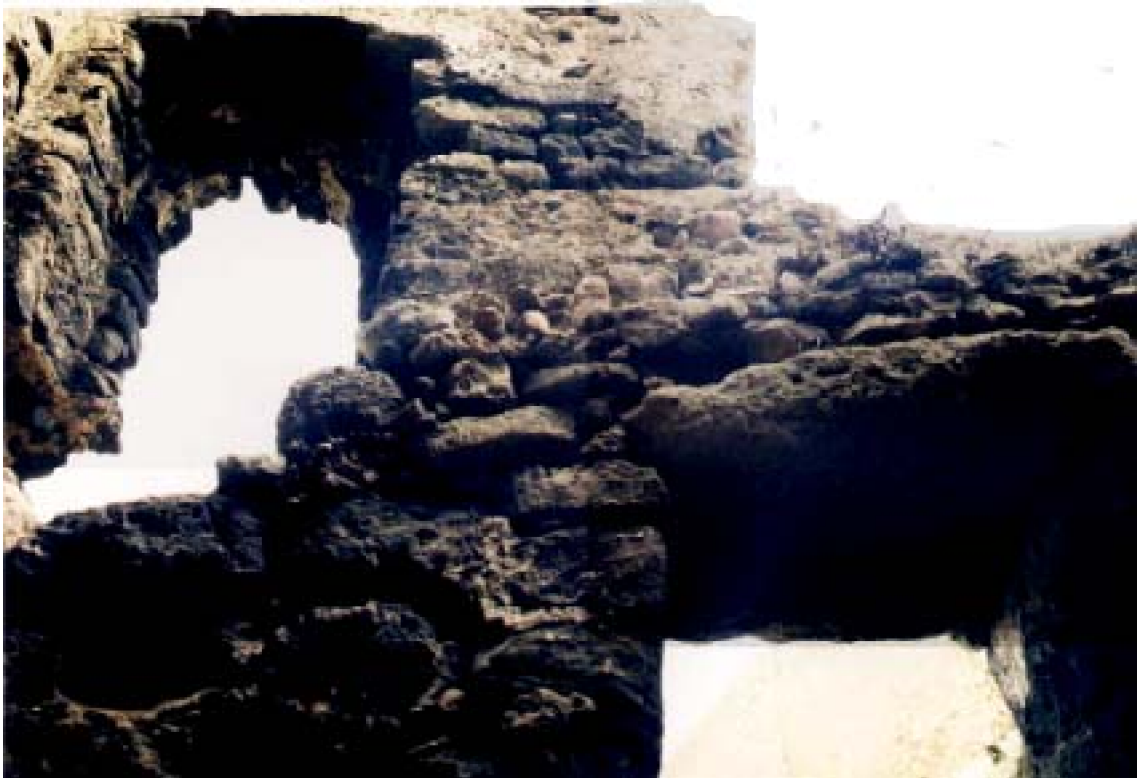
Fig. 90 : La Qa'ba d'Ayyur A : à droite, le linteau monolithique de la porte d'accès ; à gauche, en haut, une baie située au premier étage de la tour.
