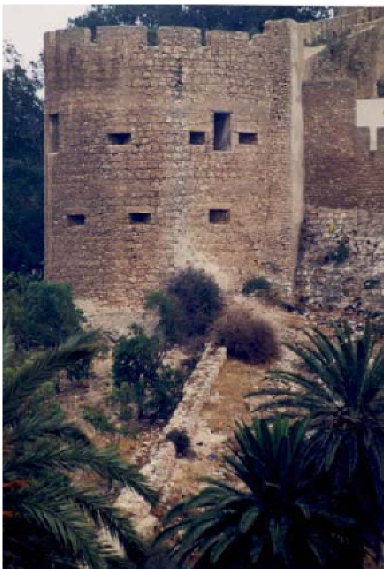
Fig. 73 : Tronçon de la muraille almohade de Safi. A : Vue du tronçon situé dans le prolongement du côté nord-est de la citadelle portugaise.
