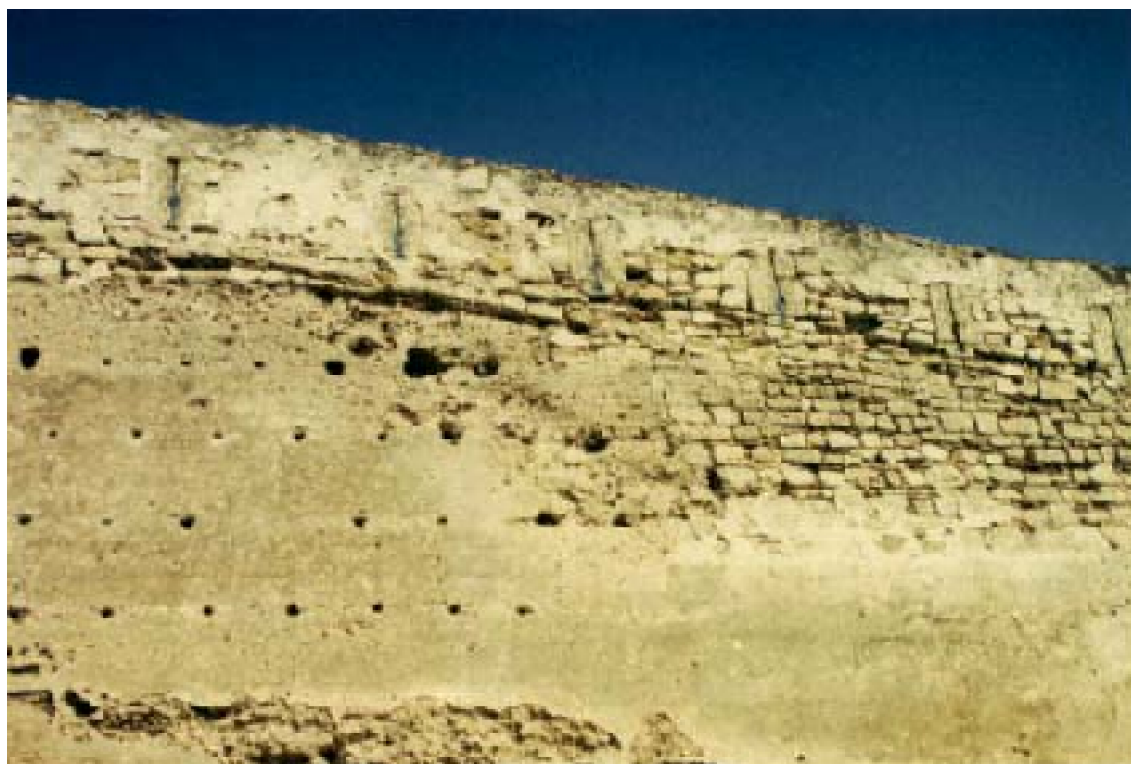
B : Au sommet du mur, les banchées de □□ biya servent de base à quelques reprises en pierre datant de l'époque portugaise. Des assises en moellons ou en pierre de taille se prolongent sur les deux parois du mur, pour former un parapet rythmé par une série d'ouvertures de tir équidistantes.
