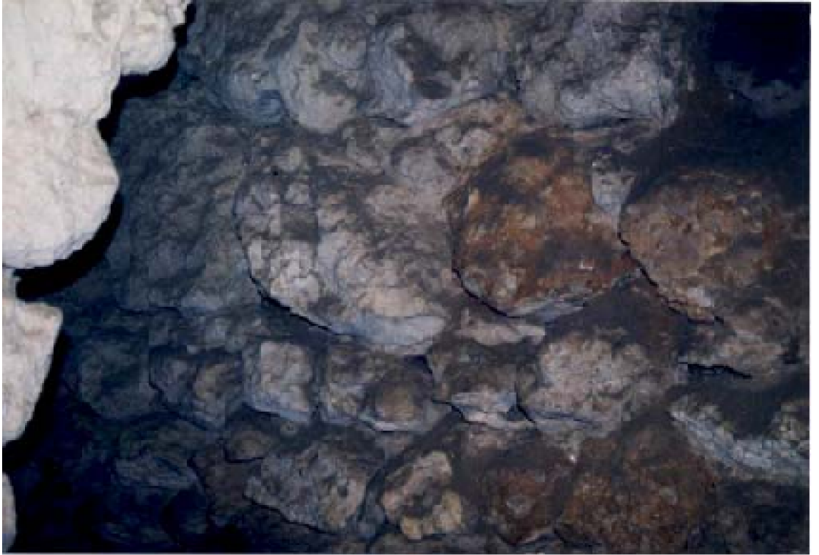
B : Le local du premier étage est délimité par un mur construit avec de très gros blocs.
