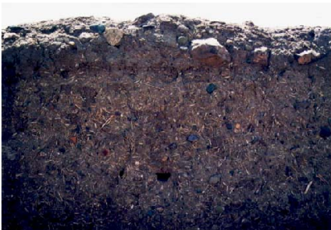
B : Le mur est couvert d'un enduit de terre et de paille hachée.
