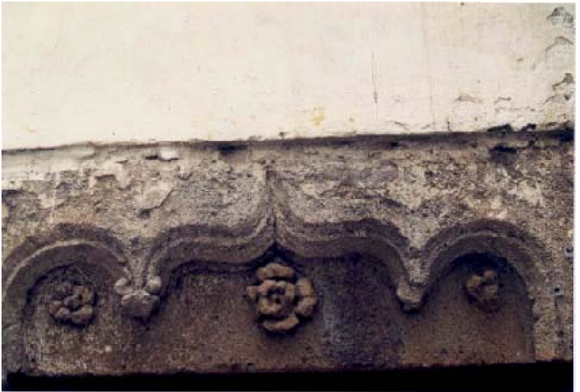
B : Détail de la décoration : un arc en accolade encadrant trois rosaces sculptées.
