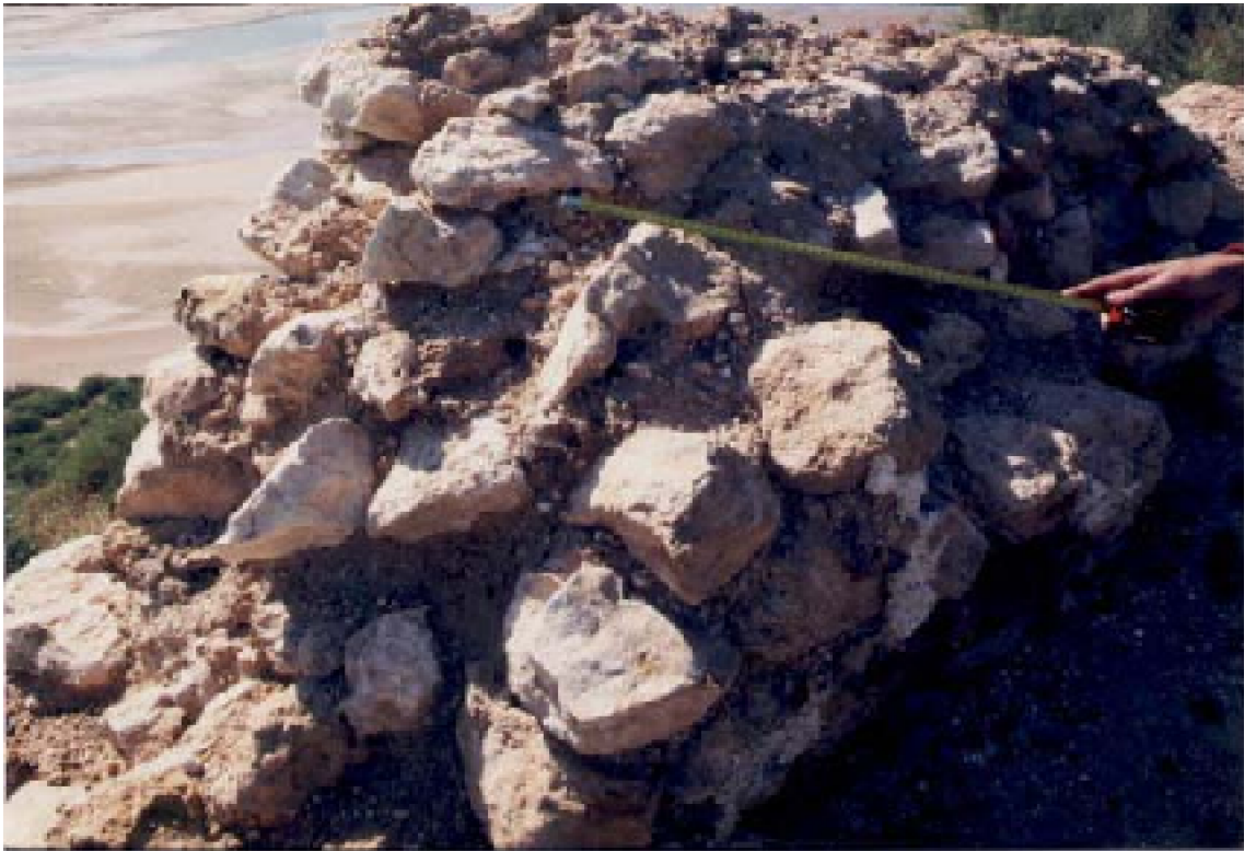
B : La masse du mur est formée d'un mélange de pierres brutes de taille moyenne, de terre, de pierraille et de chaux.
