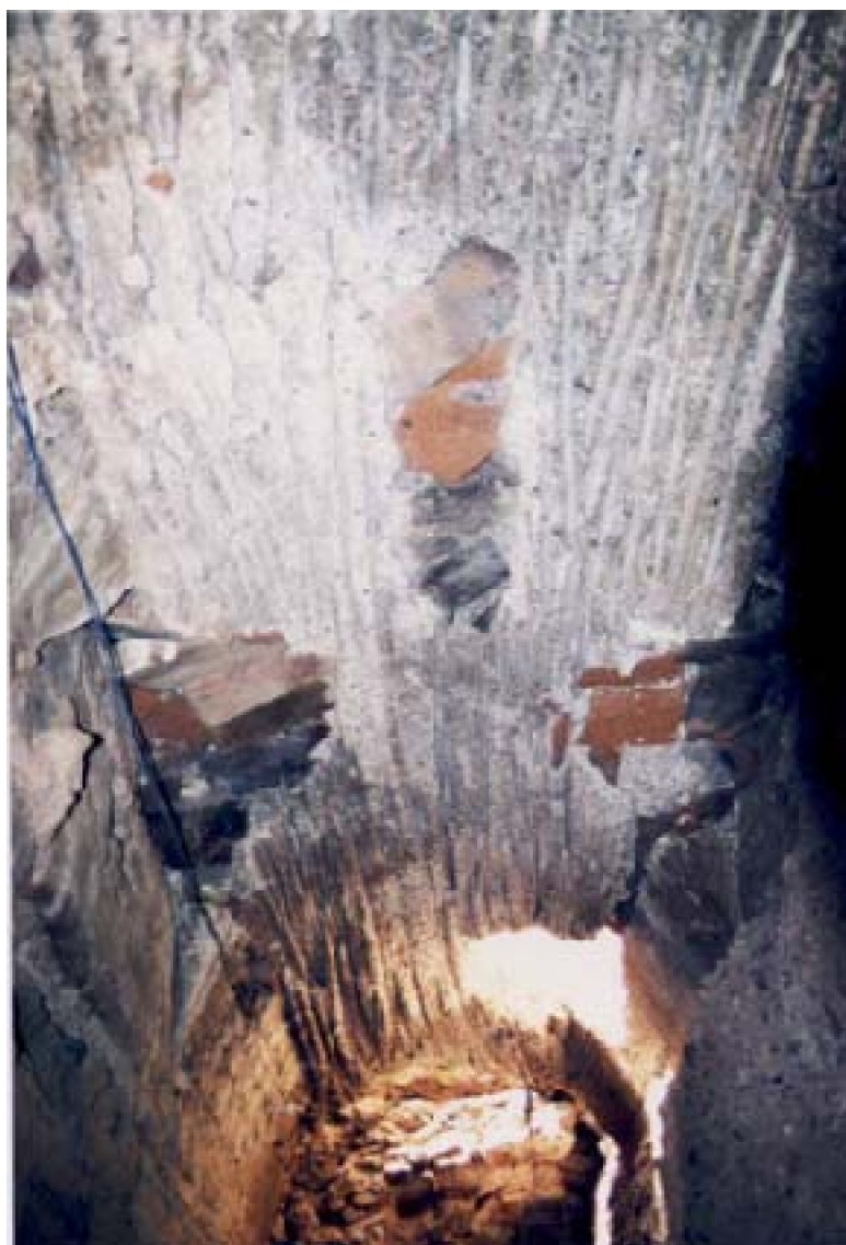
B : Traces du couchis d'un cintrage en matériaux végétaux. (Galerie souterraine du palais al-Bad o , Marrakech).
