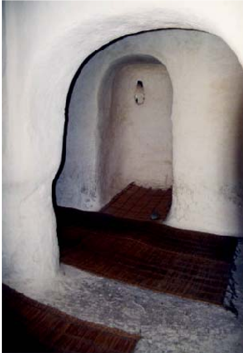
Fig. 162 : Voûtes en berceau. A : Mihrab d'une mosquée dont les supports massifs soutiennent une voûte en berceau (région de Cap Cantin).
