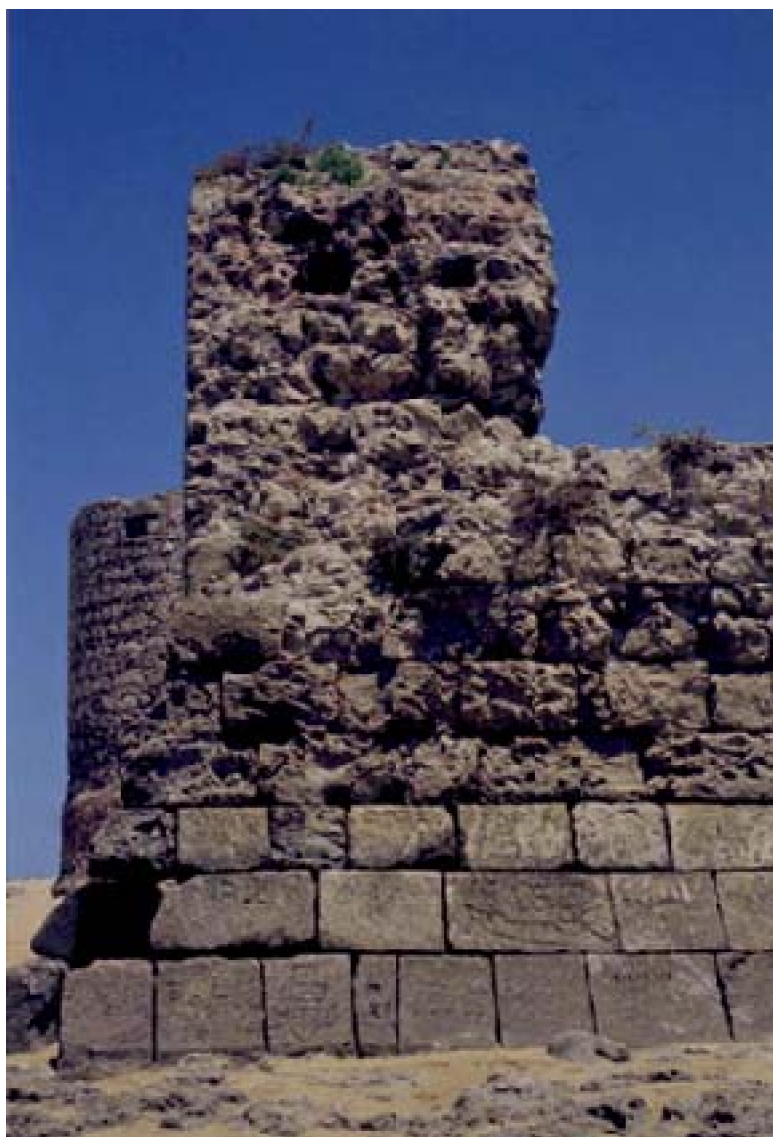
Fig. 152 : Le château portugais d'Aguz. A : Vue de l'angle sud-ouest. Les murs sont protégés sur deux côtés par un talus composé de gros blocs taillés.
