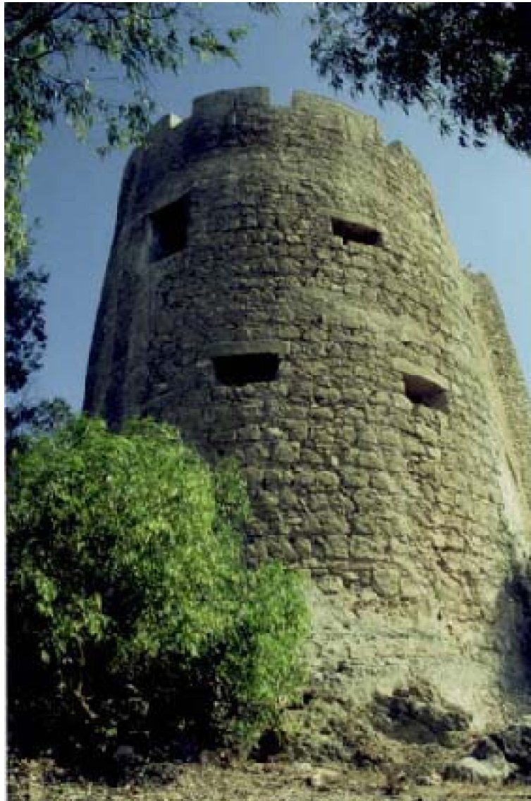
B : Vue d'une tour ronde située à l'angle nord-est de la muraille. Cette forme massive privilégie l'utilisation de pièces d'artillerie.
