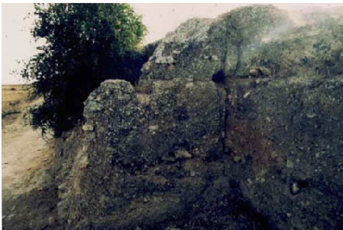
Fig. 105 : Al-Madīna A : Les tours saillantes sont adossées à la muraille de biya. (côté ouest de l'enceinte)
