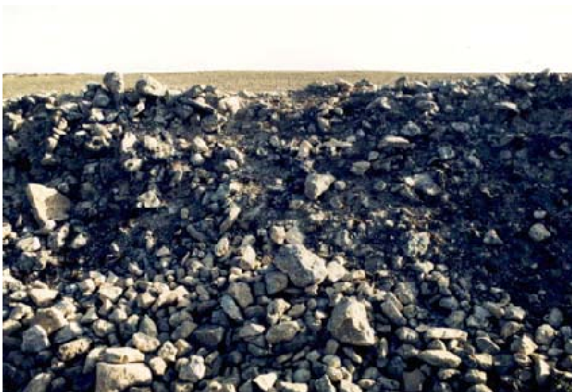
B : Les restes d'un épais mur bâtis selon la technique du blocage sont réutilisés dans des enclos modernes.
