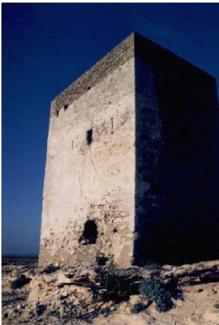
Fig. 95 : Burj al-Najjar. A : Le bâtiment de Burj al-Najjar offre un aspect robuste, conséquence des restaurations fâcheuses qui ont complètement altéré sa forme extérieure. La vue de la façade ouest de la tour atteste bien ces changements, avec l'ajout d'un parapet en briques industrielles. Initialement, le bâtiment devait s'élever sur deux niveaux, dont le second serait matérialisé par les meurtrières visibles sur la photo et qui sont accessibles dans la terrasse du bâtiment.
