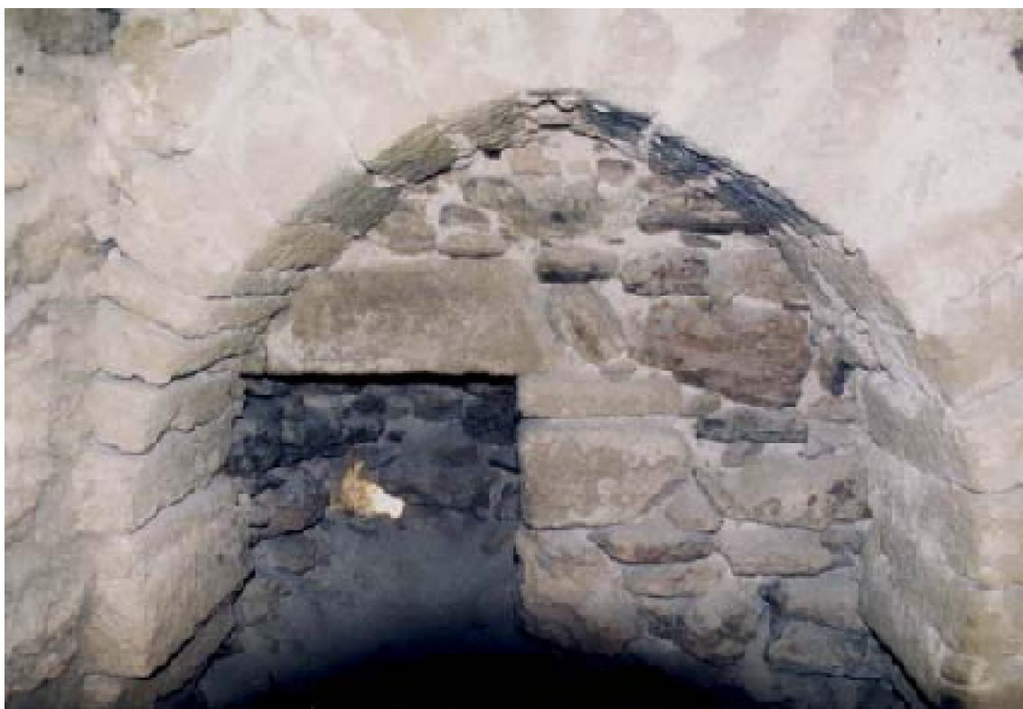
Fig. 97 : Burj al-Najjar. A : Vue de l'arcade gauche du côté ouest de la pièce. L'arc brisé outrepassé s'appuie contre le mur extérieur de la tour. Ce dernier était percé d'une baie de forme quadrangulaire, encadrée de piliers, dont un seul est encore perceptible, et d'un linteau monolithe en calcaire. La fonction de cette baie bouchée donnant sur l'océan, nous est inconnue. Étant dépourvue d'ébrasement, il semble peu probable qu'elle soit une archère ou une meurtrière. Il pourrait alors s'agir d'une bouche à canon.
