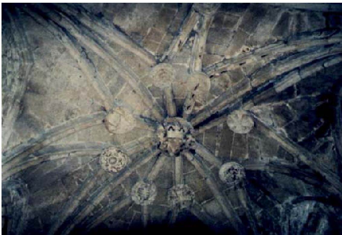
B : Détail de la voûte en ogives de la cathédrale. La clef de voûte est frappée des armes de la couronne portugaise.
