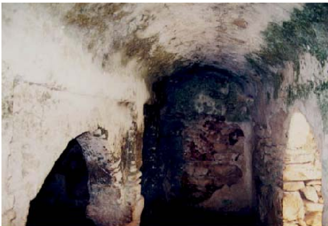
B : Travée couverte d'une voûte en berceau, dans une mosquée abandonnée dans la
