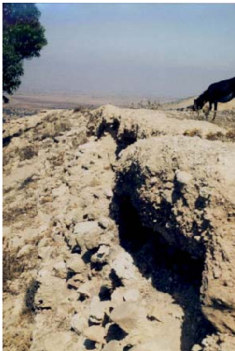
Fig. 115 : Sqr Ban Mguir A : Vue du côté ouest de l'enceinte. Le mur de biya s'appuie sur un soubassement de pierre.
