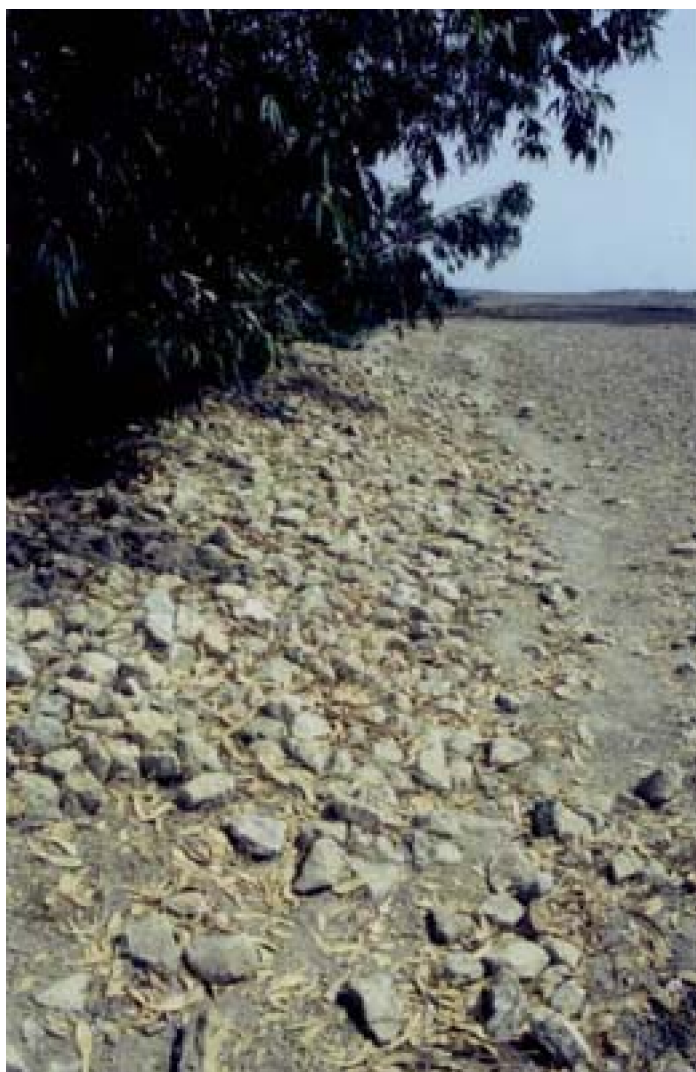
Fig. 109 : S□r M□s□ A : Les éboulis des soubassements de pierre, côté ouest de la muraille.
