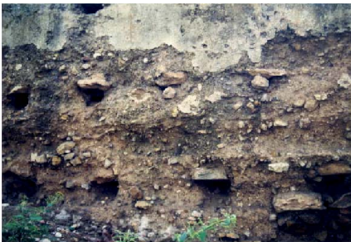
Fig. 74 : L'enceinte almohade de Safi. A : Détail de la composition de la □ □ biya du premier tronçon de l'enceinte almohade. Le mélange solide est riche en pierre et en chaux.
