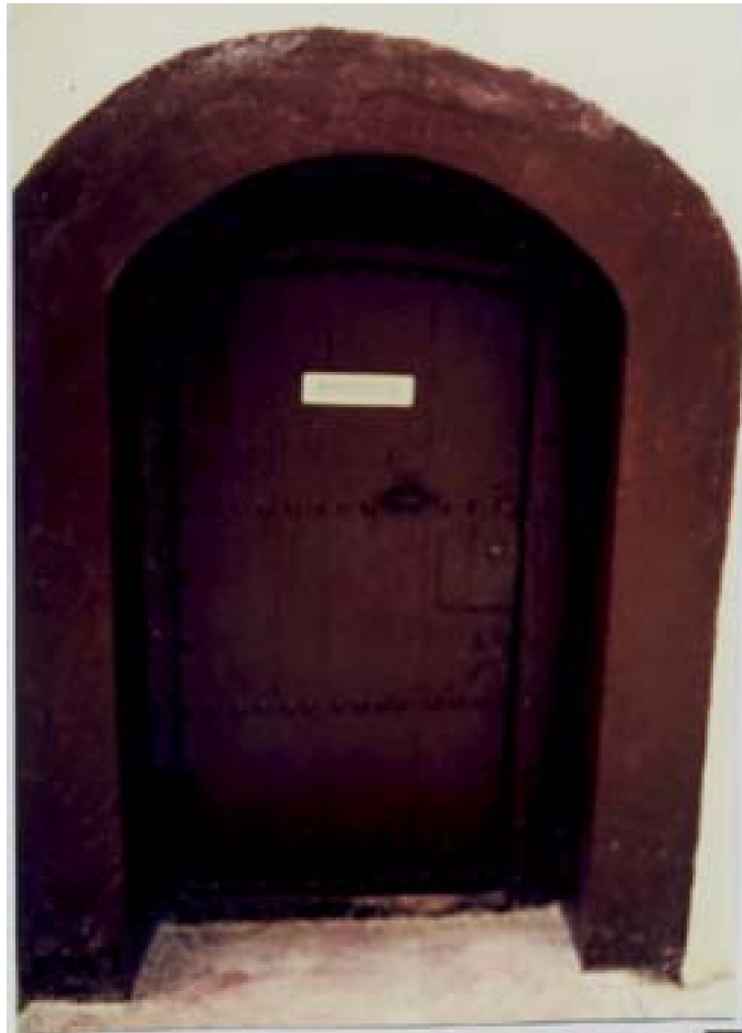
Fig. 167 : Arc en plein cintre non outrepassé dans l'architecture locale. A : Porte d'entrée de Dār Balkhiya (Safi).
