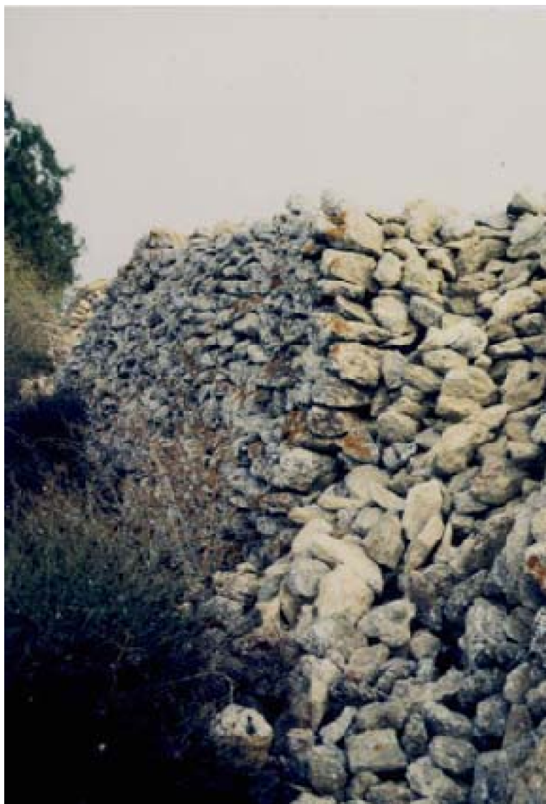
Fig. 155 : Murs en pierre. A : Mur en pierre sèche, légèrement incliné (sur le site d'al-Madīna).
