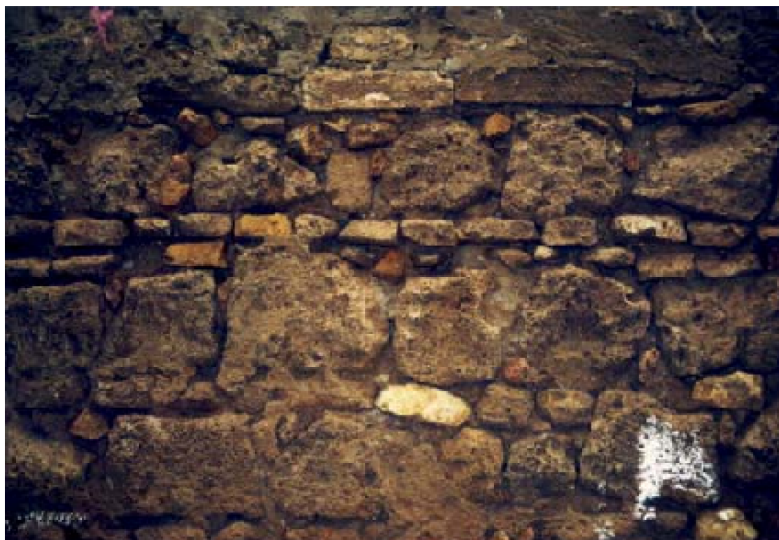
Fig. 137 : La muraille portugaise de Safi. A : Détail de l'appareil : des petites dalles composent des assises de régulation alternant avec des lits de moellons.
