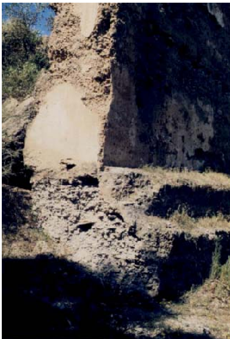
Fig. 158 : Murs en biya. A : La base d'un mur de la qa'ba 'alawite de m'dsh, au sud du Tansift. Un socle d'une biya fortement dosée en pierrailles donne une bonne assise à la structure.
