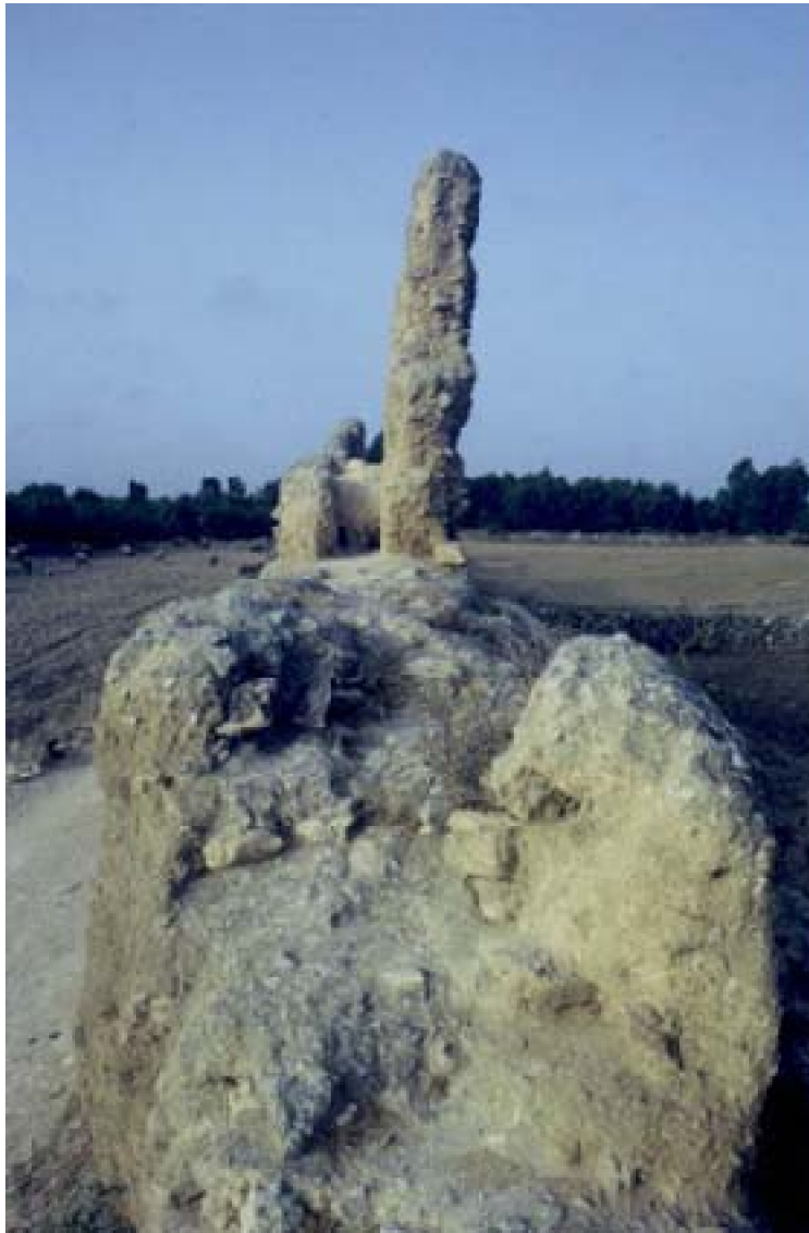
B : Côté ouest de la muraille d'al-Madīna. Les deux parois du mur sont montées séparément.
