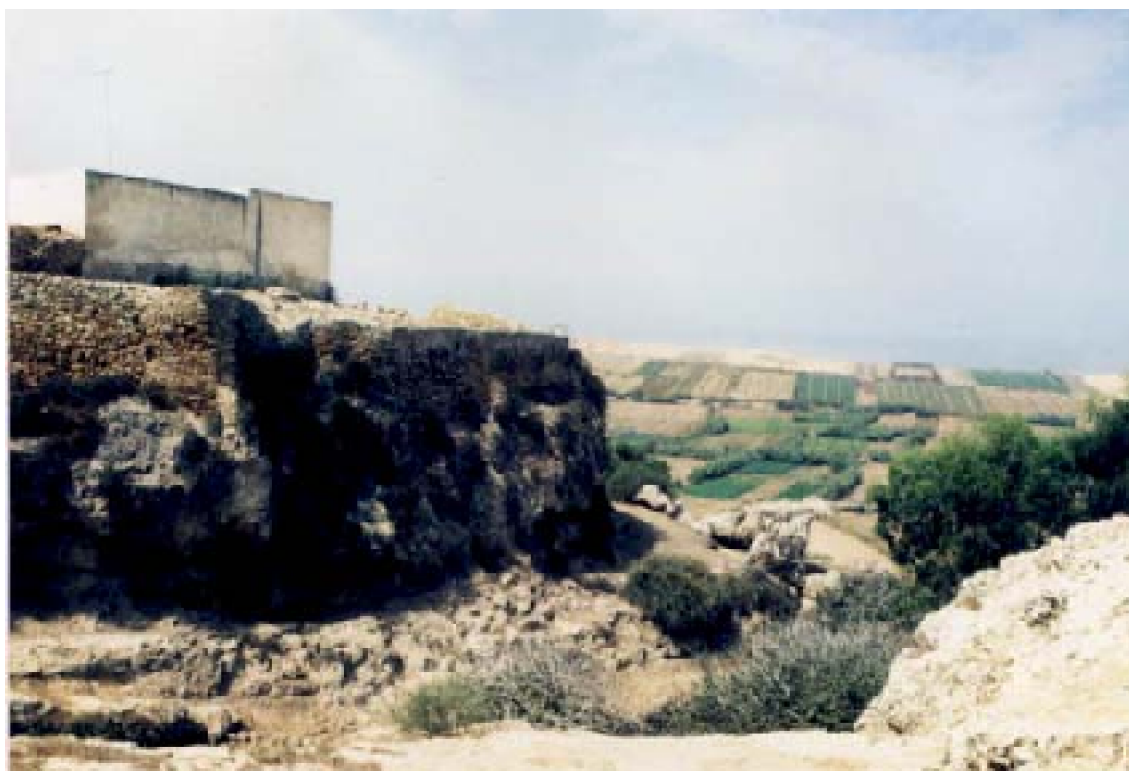
Fig. 92 : La Qa'ba d'Ayyur A : Vue de la partie nord de l'enceinte. La cortine s'élève au-dessus de la falaise.
