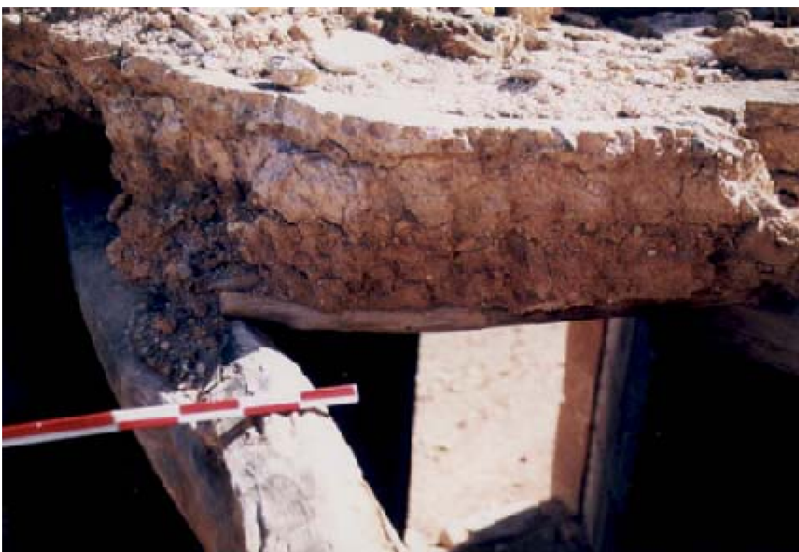
Fig. 160 : Coupe d'une toiture à Ski (sud de Tansift). D'épaisses couches de terre et de chaux sont disposées au-dessus des solives. Elles reçoivent le sol du niveau supérieur
