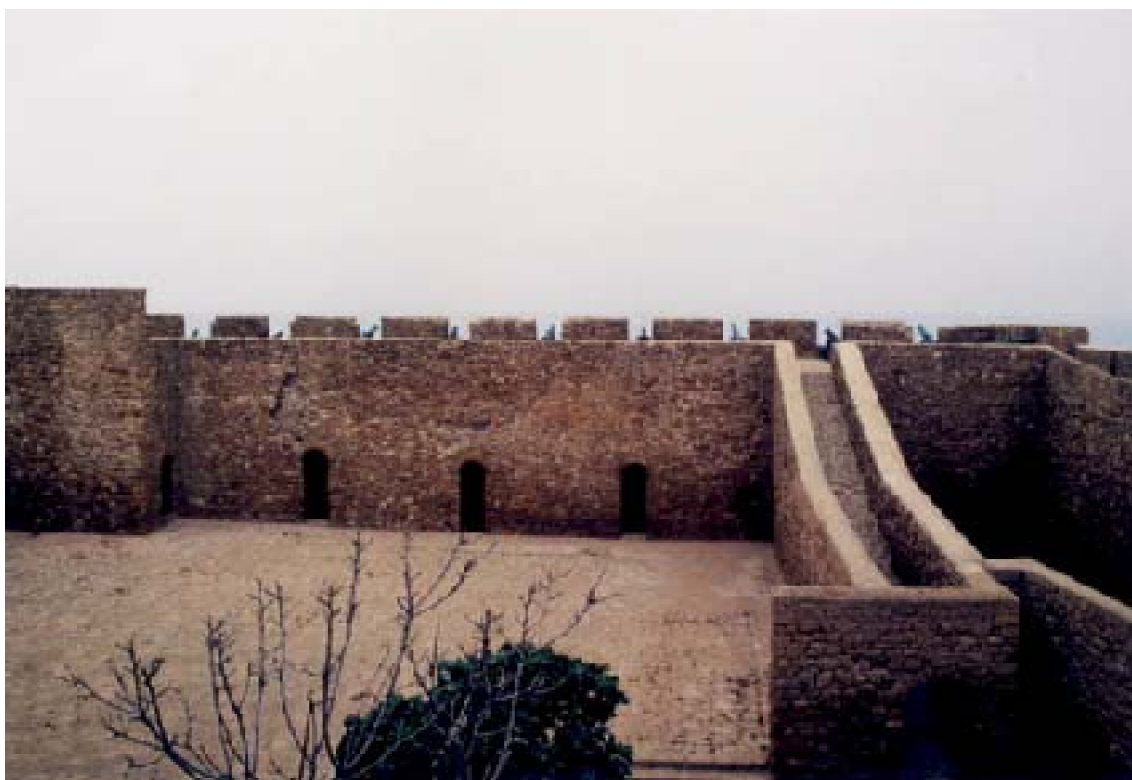
Fig. 142 : Le château de mer à Safi. A : Vue de l'esplanade : au fond, des casernements
