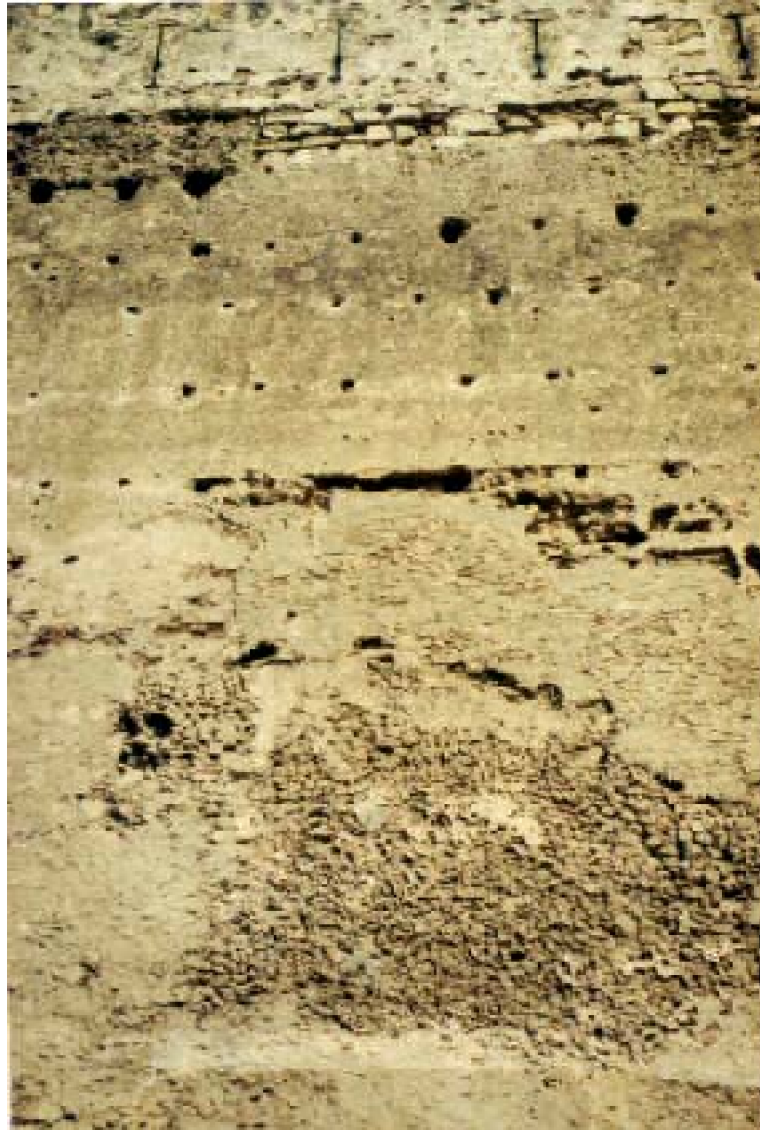
Fig. 75 : Tronçon du rempart almohade de Safi. A : Le mur était protégé par un enduit brunâtre, qui laisse apparaître parfois une □ □ biya de texture hétérogène, riche en éléments d'une grande granulométrie.
