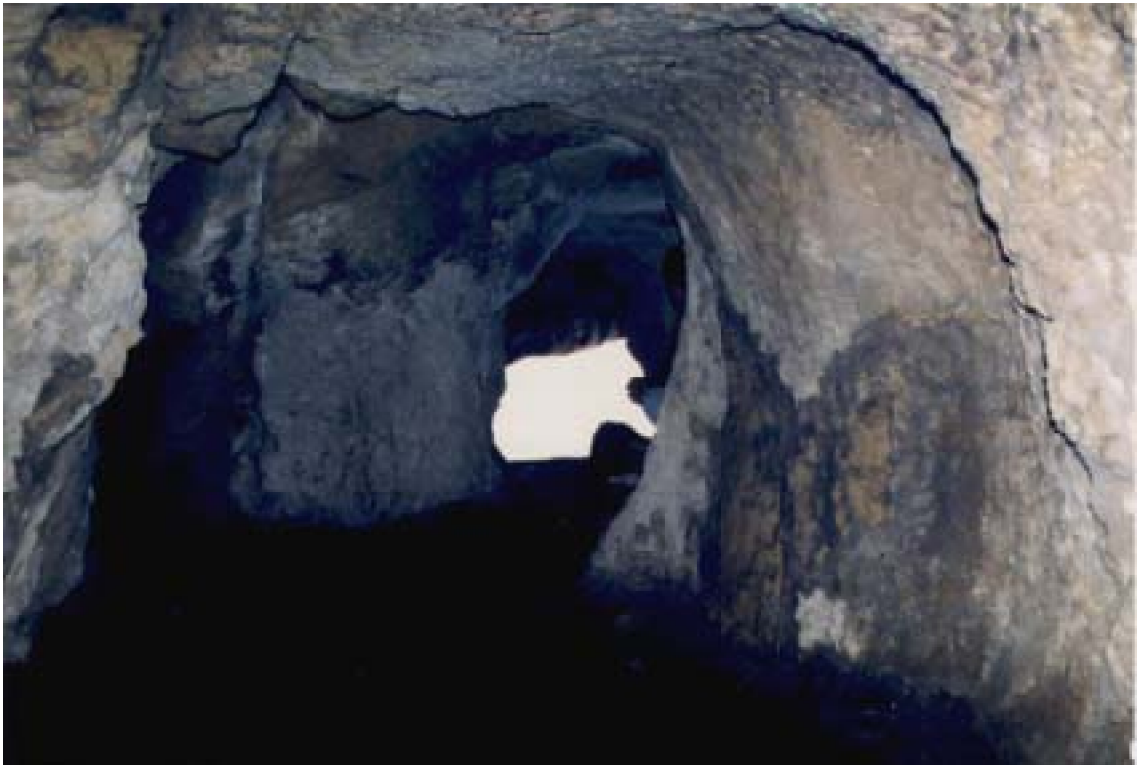
A : Vue depuis l'intérieur de l'entrée d'un habitat troglodytique
