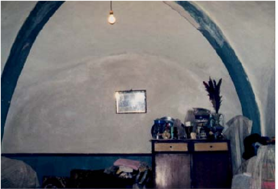
B : Vue d'une chambre couverte d'une voûte sur nervures, de style portugais.
