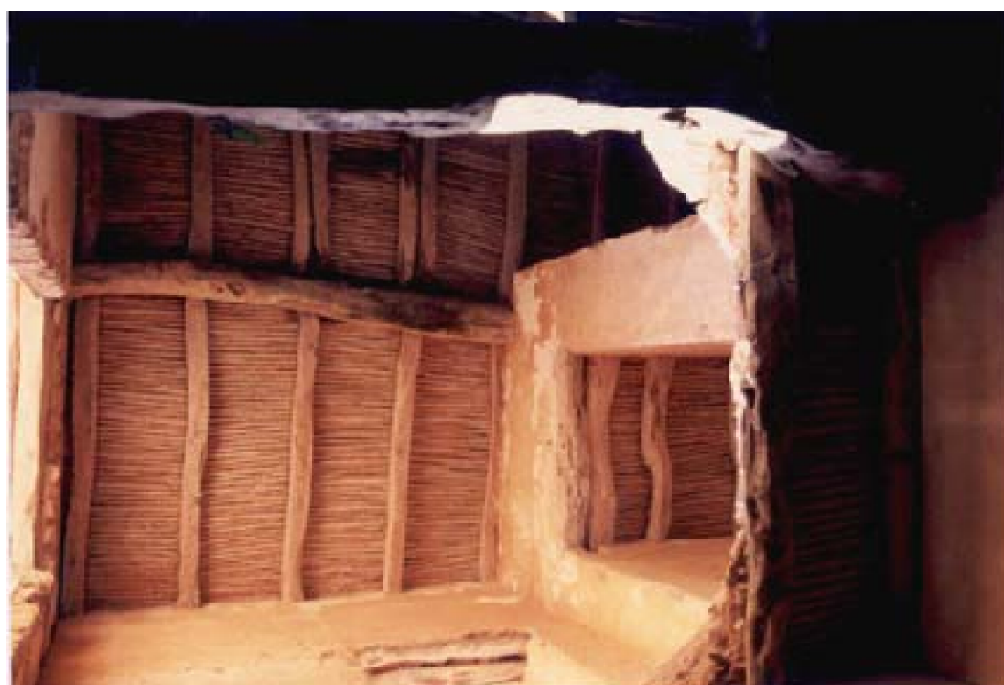
Fig. 159 : Toiture en tisw □ t. A : Vue de plafonds de tisw □ t, D□r al-□□□□□ (au sud du Tansift - 19 e siècle).
