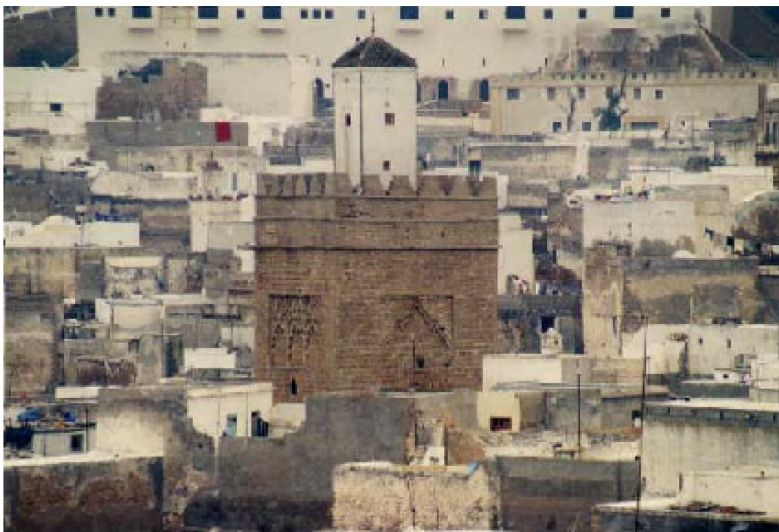
B : Vue du minaret almohade, façades nord et ouest.
