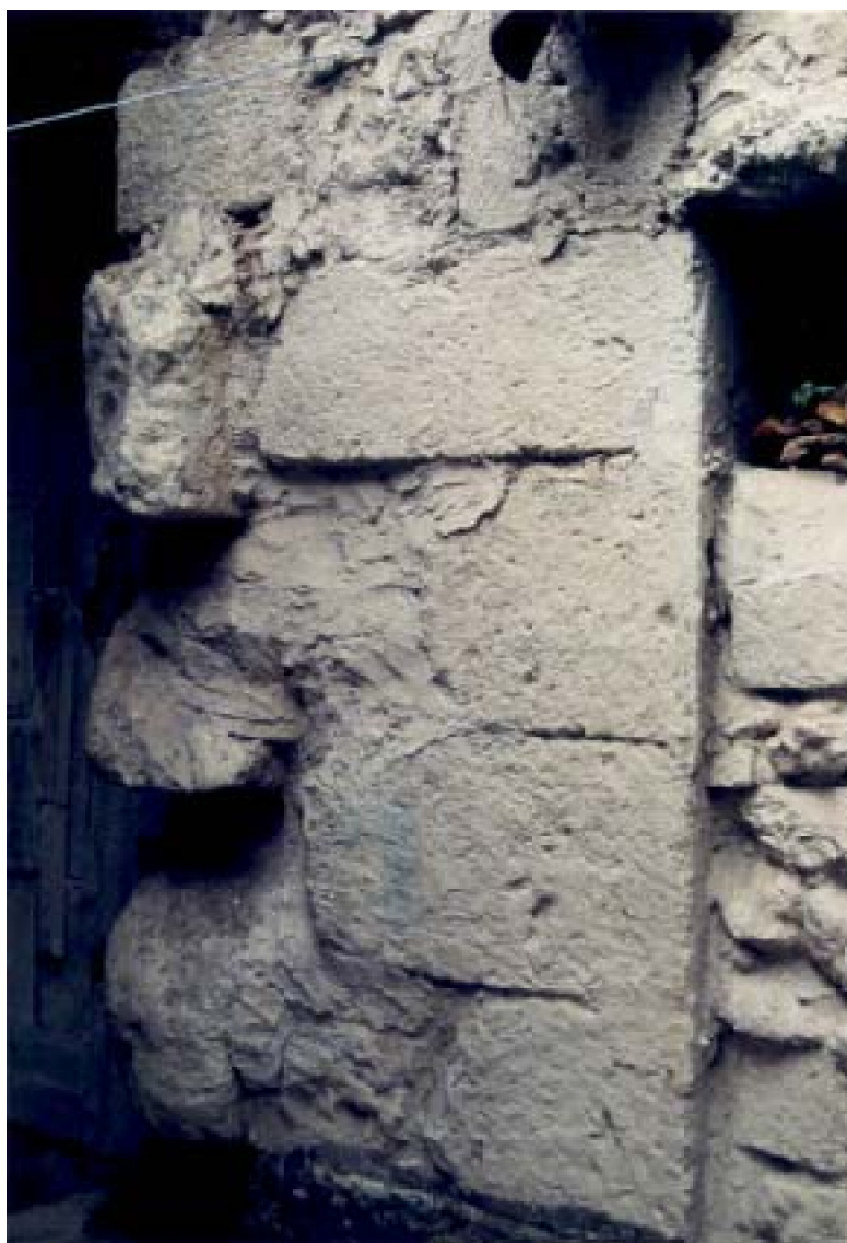
B : Gros blocs de pierre de taille utilisés dans un chaînage d'angle. Tronçon d'un mur situé à l'intérieur d'une maison de S□q al-Ghzal, à Safi.
