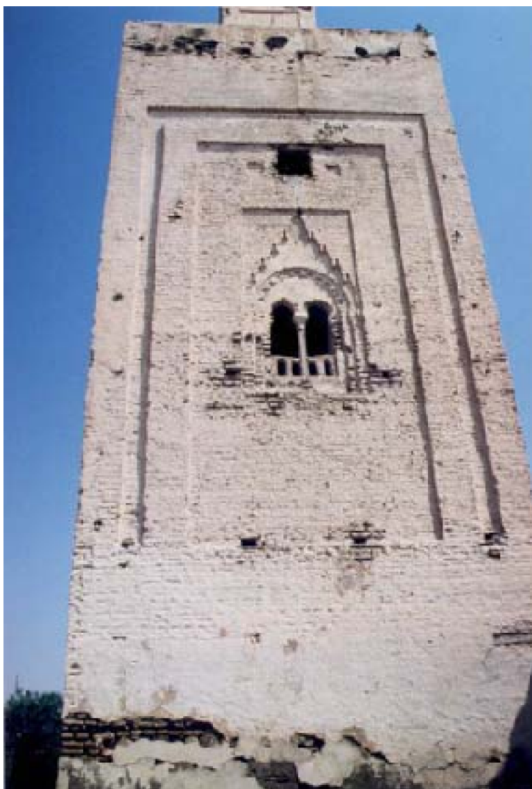
Fig. 63 : La mosquée de Ribat Shikir. La baie géminée est encadrée par un arc polylobé, surmonté d'un arc festonné. Son décor, de facture simple, rappelle le décor des minarets almohades. A : Vue générale du minaret.
