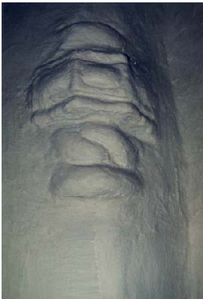
Fig. 149 : Dār Balkāhiya à Safi. A : Chapiteau portugais conservé à l'étage
