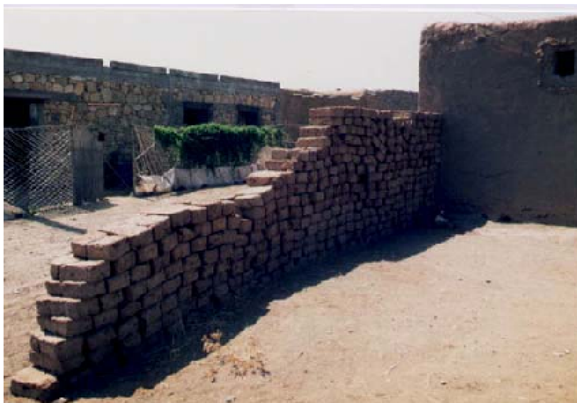
B : Rangées de briques crues séchées au soleil, prêtes à l'emploi dans les constructions domestiques de Ribā Shīkir.
