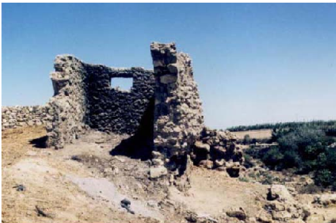
Fig. 91 : La Qaḥba d'Ayyūr A : Vue de la tour, située sur la courtine est de la fortification.
