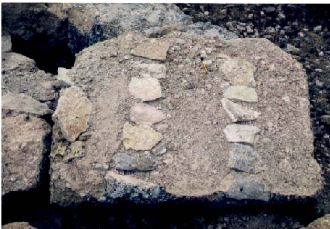
B : Vue d'une banchée de □ □ biya, dans les vestiges du mur est, récemment écroulé. Les deux rangées de pierre visibles indiqueraient l'emplacement d'éventuels trous de boulin.
