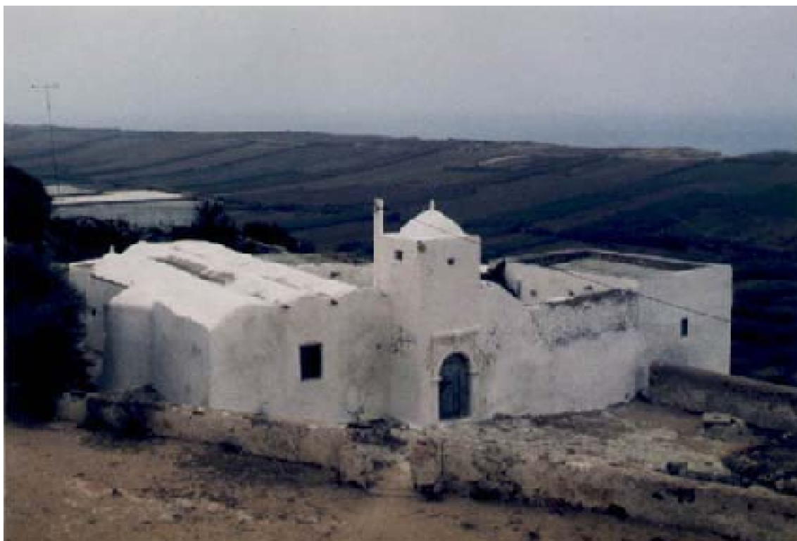
B : Vue de la mosquée, implantée à l'extérieur de l'enceinte. La salle de prière est couverte par une série de voûtes en berceau.
