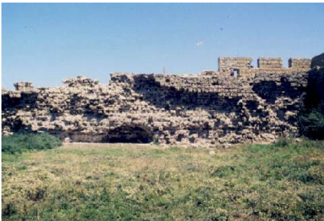
B : Vue de l'intérieur de la fortification. Le pillage continu des matériaux menace la stabilité de la structure.
