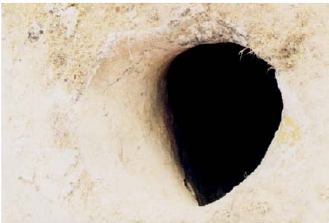
Fig. 118 : S □ r Ban □ M □ guir : exemples de silos. A : Bouche d'un silo couverte d'un enduit lissé relativement solide.
