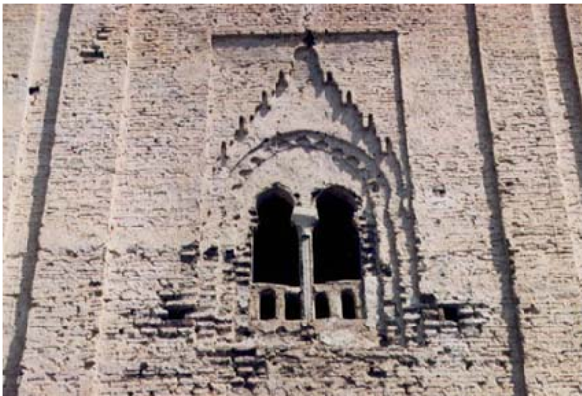
B : Détail de la façade ouest.
