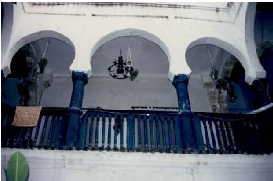
Fig. 166 : Arcs de l'architecture locale. A : Arcs brisés dans les galeries latérales bordant le patio de D r Benhima (Safi).
