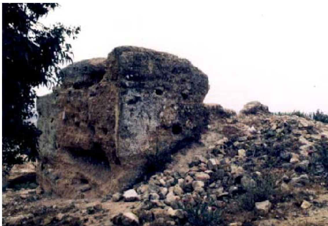
B : La tour de l'angle nord-est de l'enceinte.
