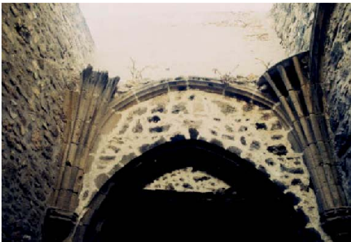
Fig. 146 : La cathédrale portugaise de Safi. A : Départ de la voûte de la chapelle latérale.
