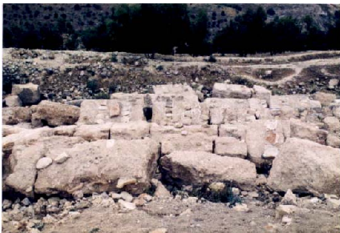
Fig. 116 : S□r Ban□ M□guir A : Une partie du mur ouest de l'enceinte, qui s'est écroulée au milieu des années 90. Constituée d'au moins six banchées, elle atteignait une hauteur
