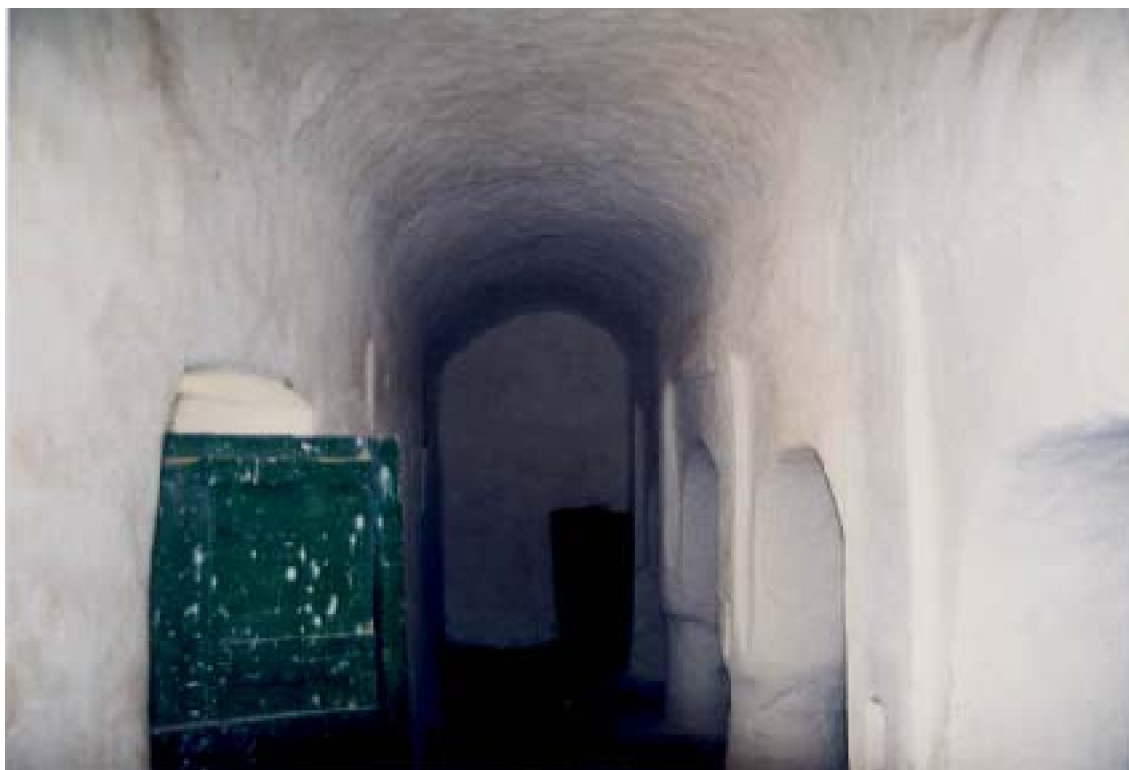
Fig. 161 : Salles de prières couvertes de voûtes en berceau A : Travée de la mosquée d'Ayy r.
