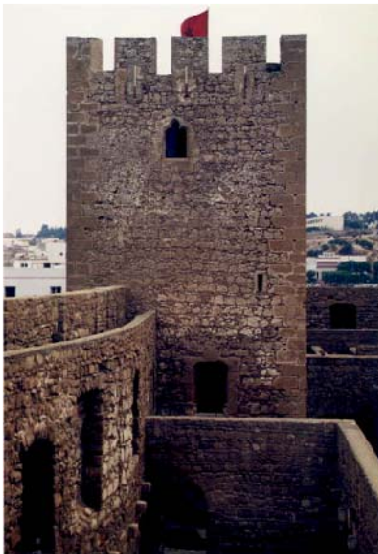
B : Vue de la tour carrée du château de mer. Longtemps appelée, improprement donjon, elle aurait servi de résidence à des responsables de l'occupation portugaise.
