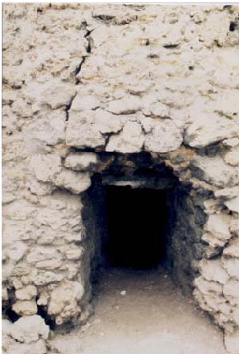
Fig. 87 : La Qaḫba d'Ayyḫr A : L'accès au local situé au premier étage de la tour
