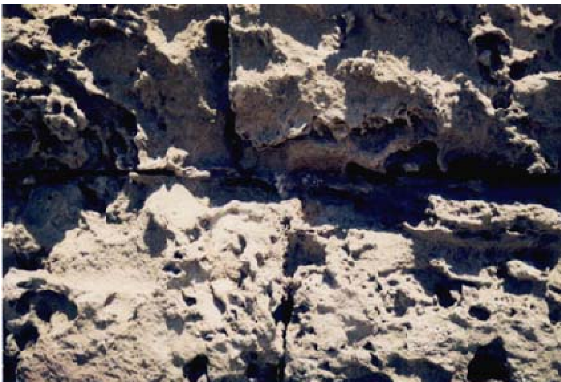
B : Détail de l'appareil du talus, côté sud-ouest. Des lamelles métalliques, probablement de plomb, renforcent le jointoiment des blocs de pierre de taille.
