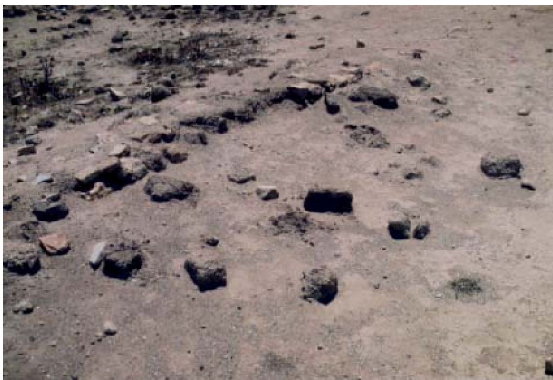
Fig. 153 : La construction en briques crues A : Vestiges de constructions traditionnelles en briques crues près de lac Z□ma. Seule la base de pierre annonce l'existence de murs dont
