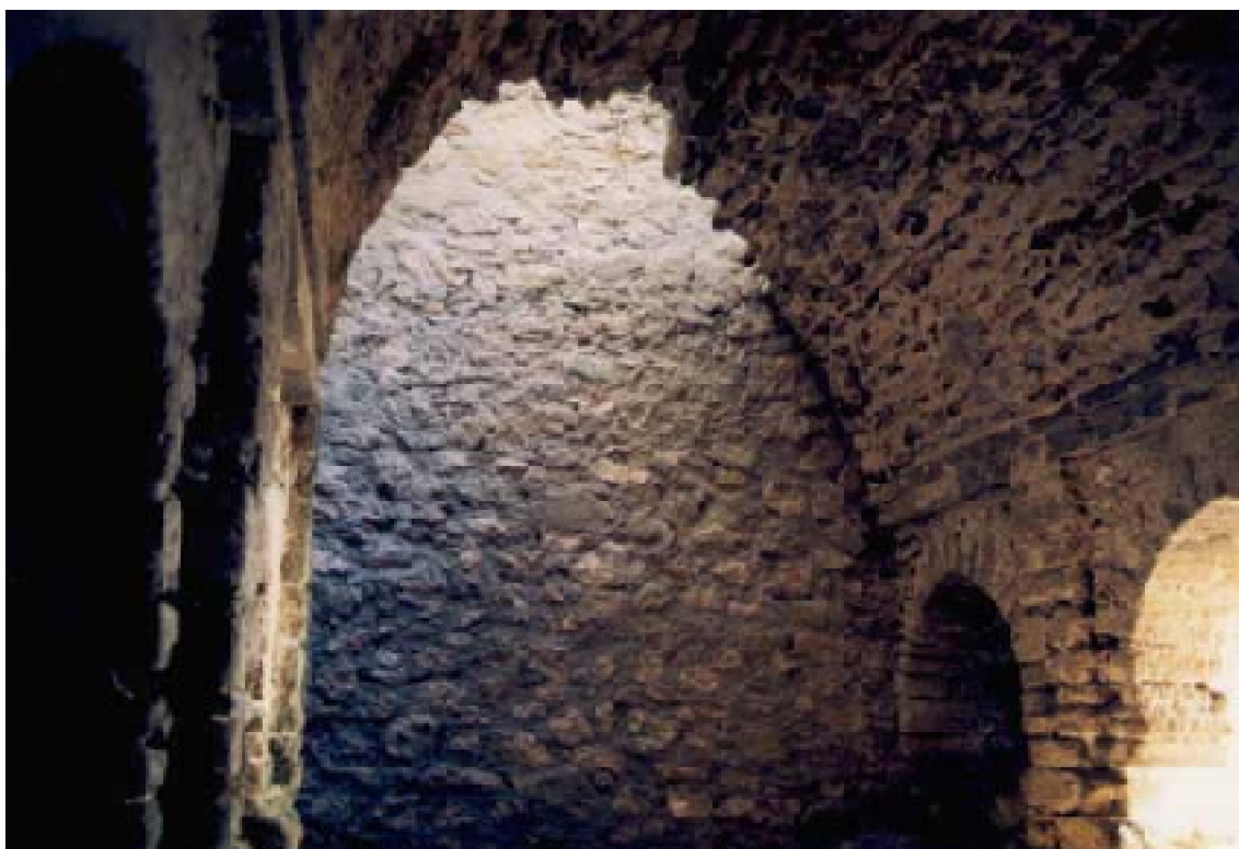
Fig. 98 : Burj al-Najjar Vue de la voûte en berceau qui constitue la toiture de la pièce du rez-de-chaussée de la tour. Elle repose conjointement sur les murs est et ouest, et semble située dans le prolongement de la maçonnerie des arcades et semble appartenir à la même phase de construction. Elle est composée d'assises relativement régulières de pierres grossièrement taillées et liées à l'aide d'un mortier de chaux. La disposition de l'intrados de la voûte atteste l'emploi très probable d'un cintrage en bois pour son montage.
