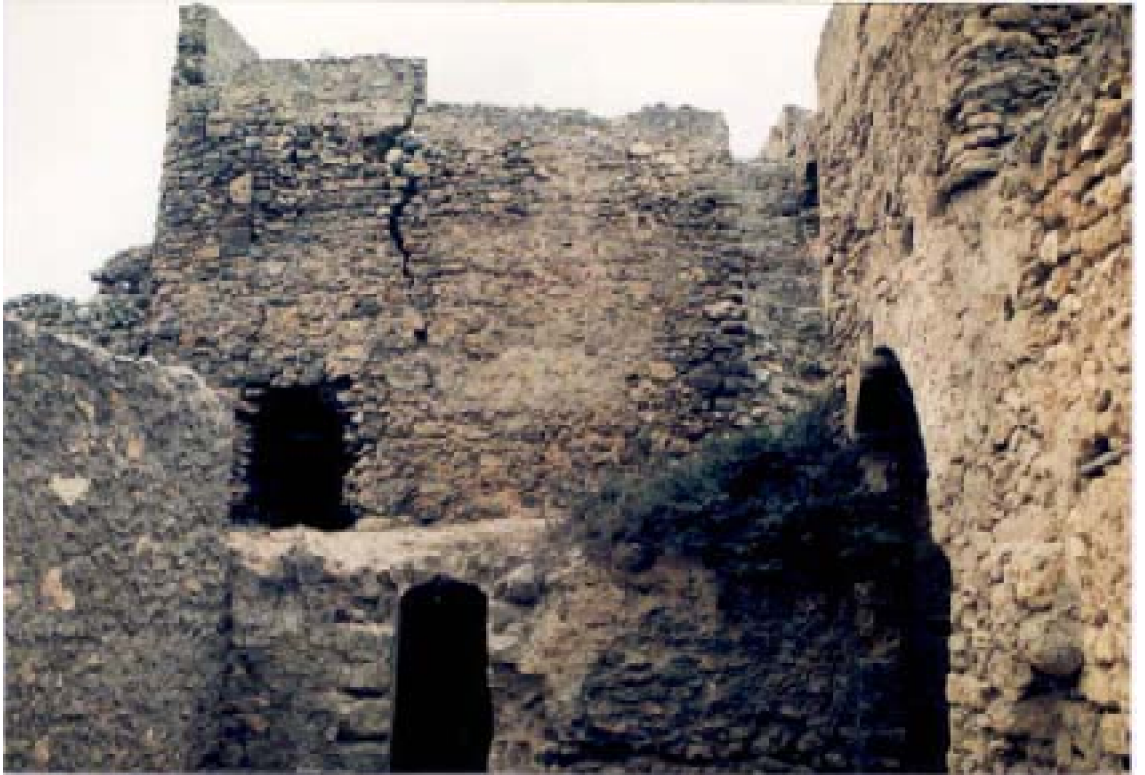
B : Vue de la tour qui défend l'entrée sud.
