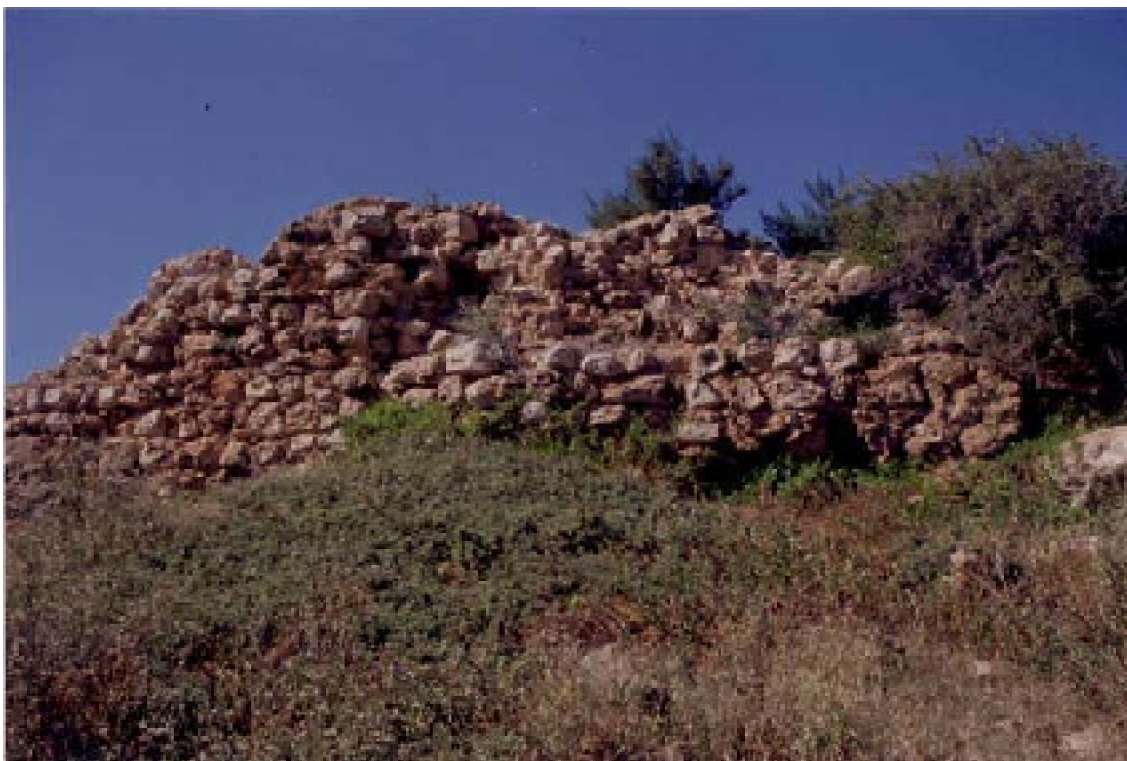
Fig. 66 : Le site d'Agz A : Le mur d'enceinte d'Agz, construit en pierre, n'est que très partiellement conservé, au côté méridional du site. Les parements sont constitués de moellons de dimensions moyennes disposés en assises régulières.
