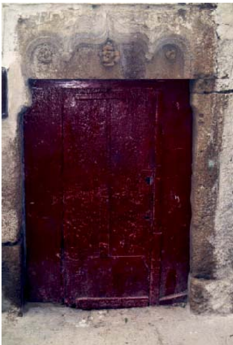
Fig. 164 : Porte portugaise à Safi. A : Porte à jambage de pierre de taille, surmontée d'un linteau monolithe décoré. (Darb al- \square am'a).
