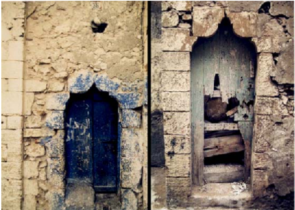
Fig. 169 : Arc en accolade dans l'architecture de Safi. A et B : Portes d'entrées de maisons traditionnelles de Safi. L'arc en accolade est l'une des rares survivances de la tradition architecturale portugaise dans les bâtiments domestiques de la région.
