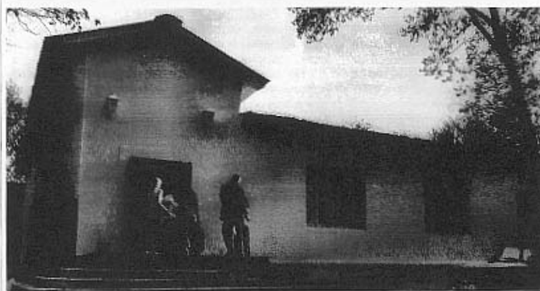
Entrée de la salle de spectacle du Théâtre allemand d'Almaty. Source : InfoDienst, n° 26, février 1997.
