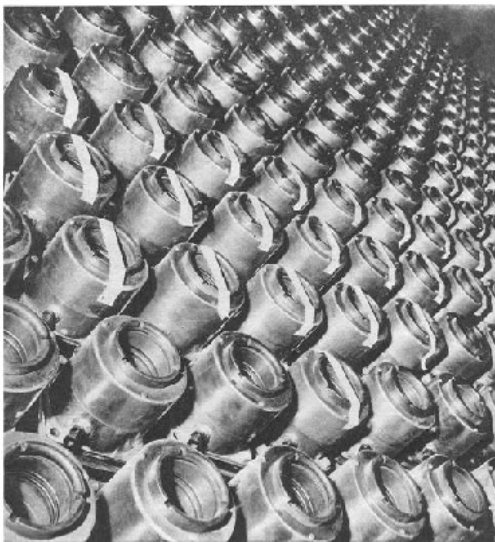
Empilement des barreaux d'uranium dans le cœur de G1. (Cliché Sciences et Avenir, 1958)
