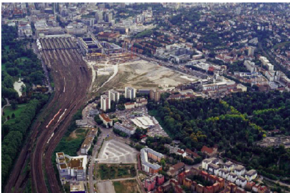
Figure 77– Stuttgart 21 : des terrains libres et des emprises ferroviaires à reconvertir en centre-ville
