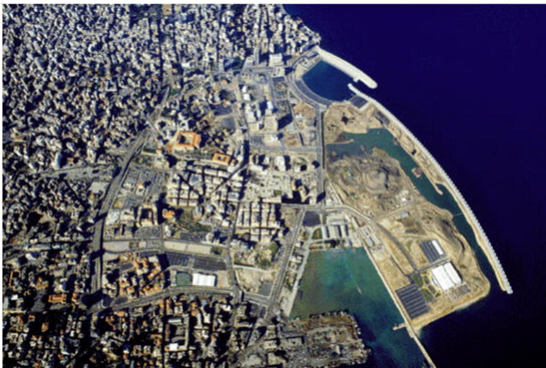
Figure 110. Photo aérienne : place de l'Etoile : centre ville de Beyrouth. Source : www.solidere-online.com
