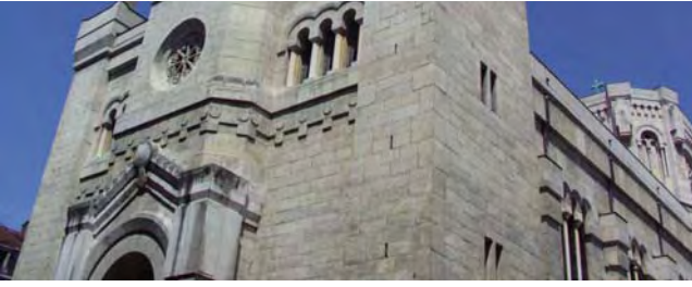
ill. 170 - Haut de la façade de l'église de l'Immaculée- Conception, blocs de pierre non-sculptés.
