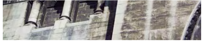
ill. 235 - Ornementation sculptée extérieure de l'église du Bon Pasteur, baies, colonnettes.
