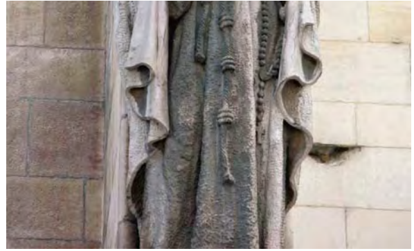
ill. 528 - Détail de la statue de Saint Antoine de Padoue , façade de l'église Saint-Bonaventure.
