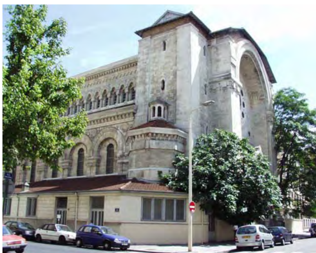
ill. 764 - Façade de l'église Saint-Joseph, vue des ornements architecturaux inachevés.
