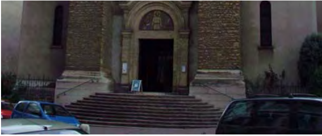
ill. 455 - Façade de l'église Saint-Augustin, vue générale des ornements architecturaux.
