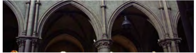
ill. 476 - Intérieur de l'église Saint-Bernard, vue des ornements architecturaux des travées.
