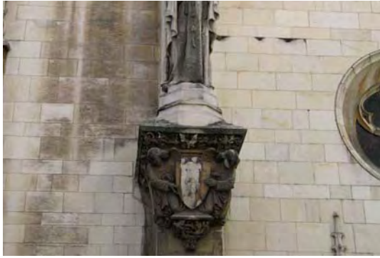
ill. 527 - Emplacement de la statue de Saint Antoine de Padoue sur la façade de l'église Saint-Bonaventure.
