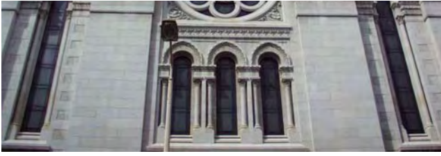
ill. 244 - Ornementation sculptée, façade latérale (transept) de l'église du Sacré-Cœur.
