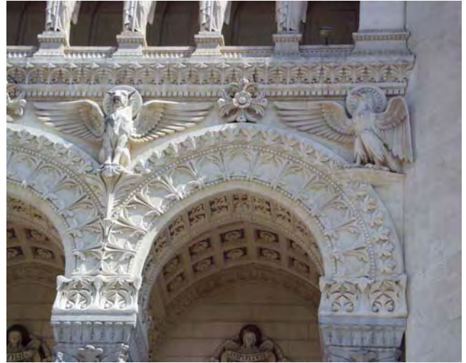
ill. 26 - Tétramorphe sur le porche de la basilique de Fourvière : le taureau ailé de saint Luc et l'aigle de saint Jean.
