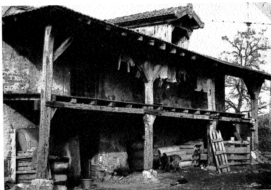
La maison de demi-montagne (Perreux) Maison-bloc en hauteur à galeries. Cette ferme de 1760 sert maintenant de débarras à la maison neuve, construite à proximité par le propriétaire qui travaille à Roanne.
