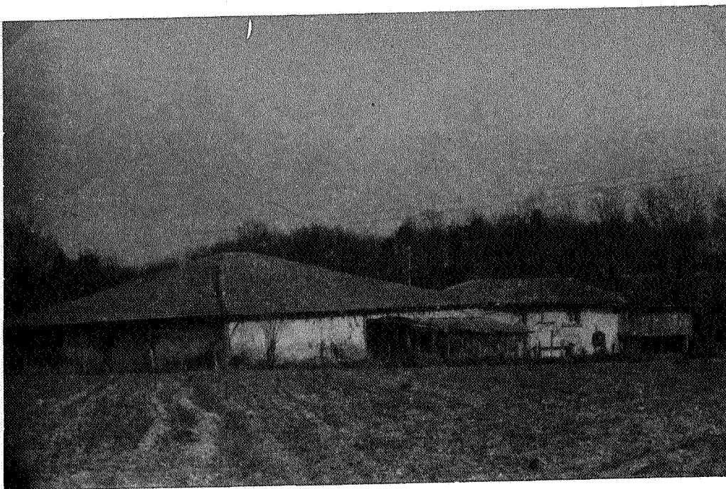
La maison de la plaine (Vougy) Le "grand couvert", appelé ainsi à cause du toit à 4 pans qui repose sur une solide charpente, fut d'abord l'unique bâtiment. Murs en pisé. Encadrement des portes et des fenêtres en pierre jaune.
