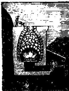
FIG. 13. — Four à chaux : On y calcine de la pierre à chaux ; il se dégage de l'acide carbonique, il reste de la chaux.
