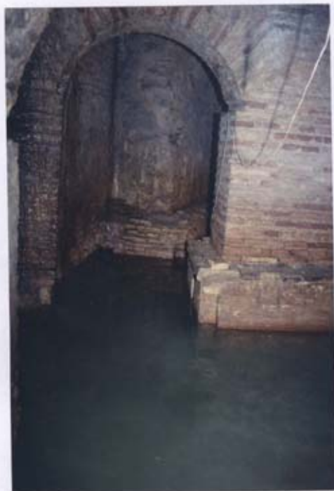
PL.7. Bassin souterrain recueillant l'eau de la source al-Ḳarawīyyīn
