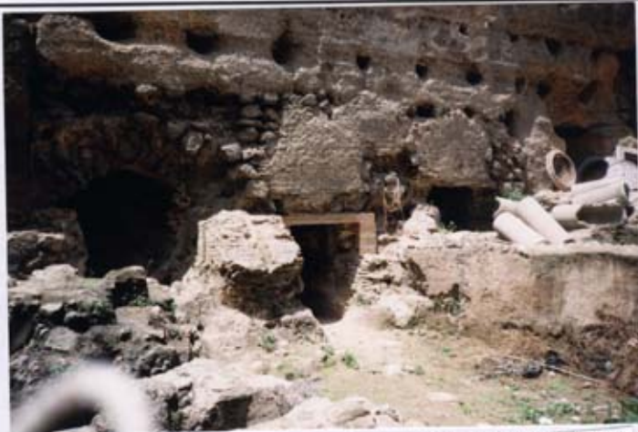
Pl.13. Passage à travers l'enceinte almohade des canaux alimentant le répartiteur de Būdjūd
