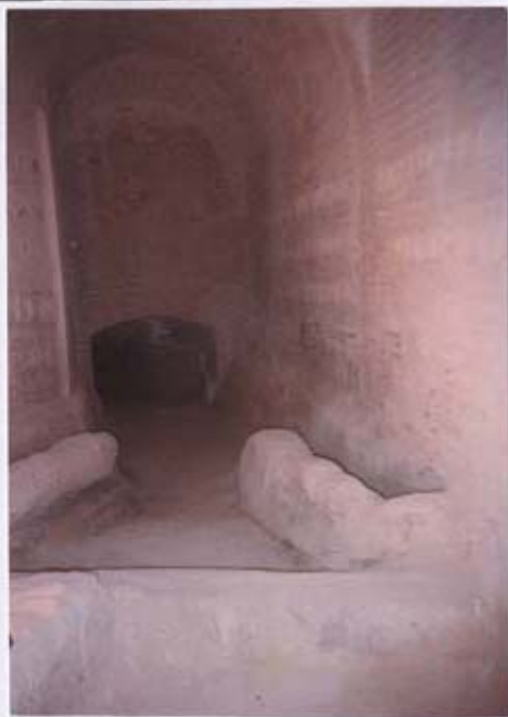
Pl.17. Partie centrale du répartiteur de Lakhnizra
