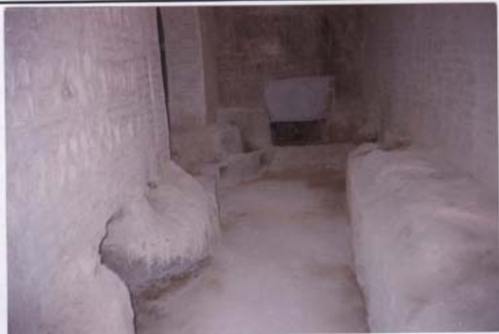
PL.18. Partie inférieure du répartiteur de Lakhnizra
