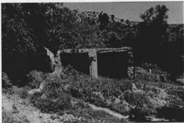
PL.46. Vestiges de l'un des moulins hydrauliques
