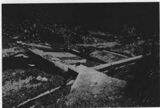
Pl.45. Barrage de Sidi Lahcen (vue de l'amont)
