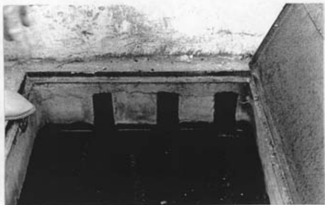
Pl.22. Mashrab/s (prises) d'une ma 'da située à l'intérieur de la grande mosquée al-Karawiyiïn
