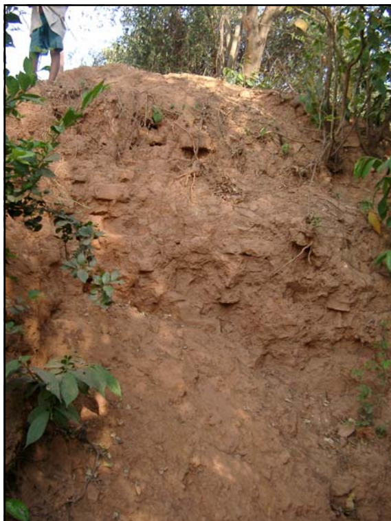
Photo 135. Pegu Une brèche dans le rempart sud. On distingue les briques liées entre elle par de la terre.
