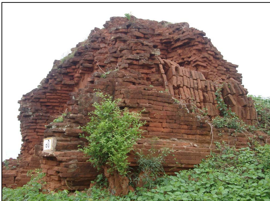
Photo 459. Myingun Le temple n° 16. Vue oblique de l'extérieur du bâtiment. On distingue clairement les techniques de construction de la structure, notamment le montage particulier des briques qui forment la voûte.
