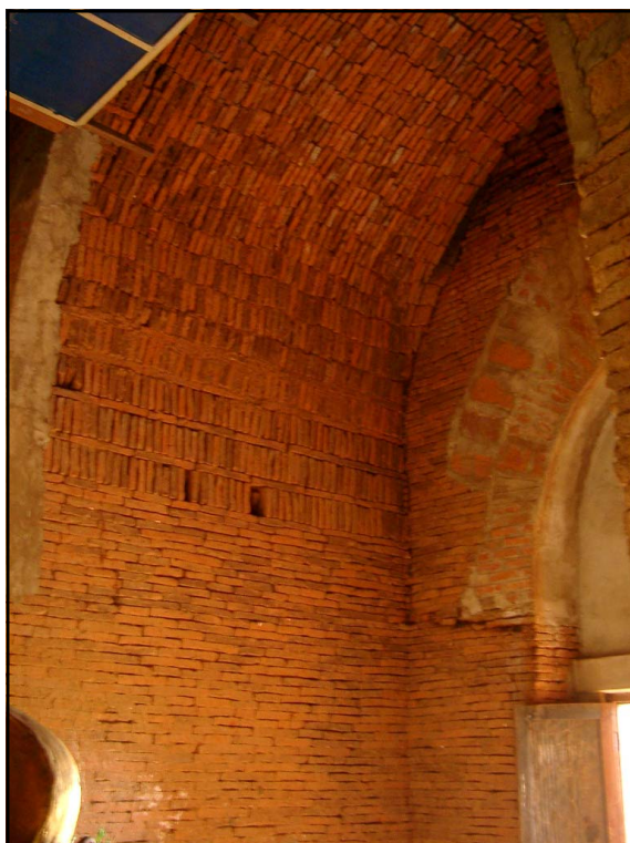
Photo 462. Myingun Le temple n° 4. Détail de la structure de la voûte d'entrée, à l'intérieur du bâtiment. Ce montage alternant la pose des briques, originaire d'Asie Centrale, est typique de la période de Pagan.
