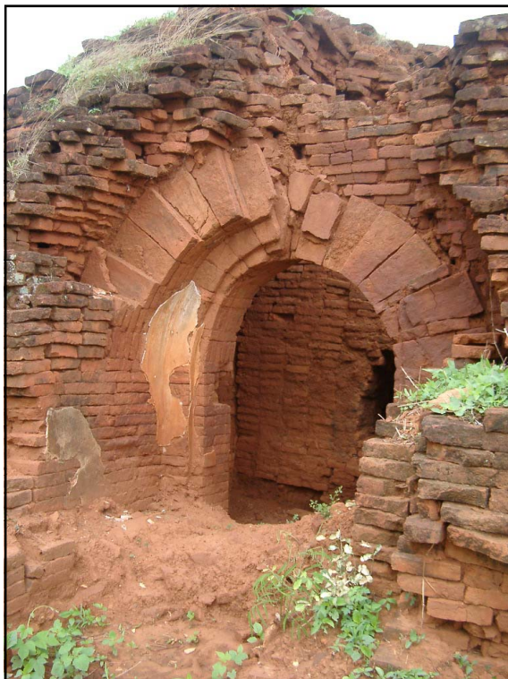
Photo 457. Myingun Le temple n° 16. Détail de l'arche d'entrée et de l'assemblage des briques qui la compose. On voit également des restes de peintures murales.
