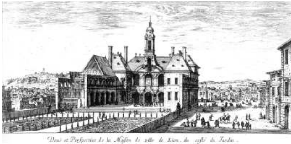
FIG. 8.2 – L’Hôtel de Ville de Lyon en construction (Vue en direction de l’ouest). L’horloge de Gom se trouvait dans la grande salle [77]. Gravure d’Israël Silvestre (1652), Archives municipales.
