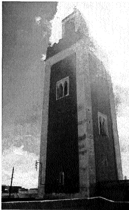
Figure 88 : Façades nord et est du minaret de la grande mosquée de Meknès.
