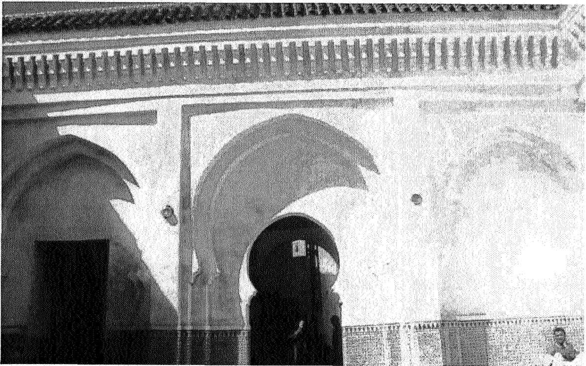
Figure 59 : Façade nord du ṣaḥn de la mosquée d'al-Naḡḡārīn à Meknès.
