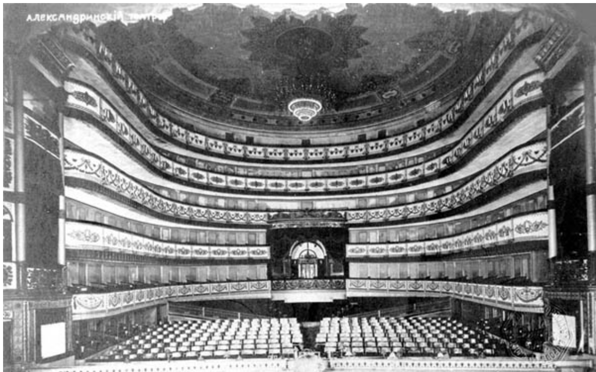
III. 64. Théâtre Alexandrinski, vue intérieure, photographie ancienne
