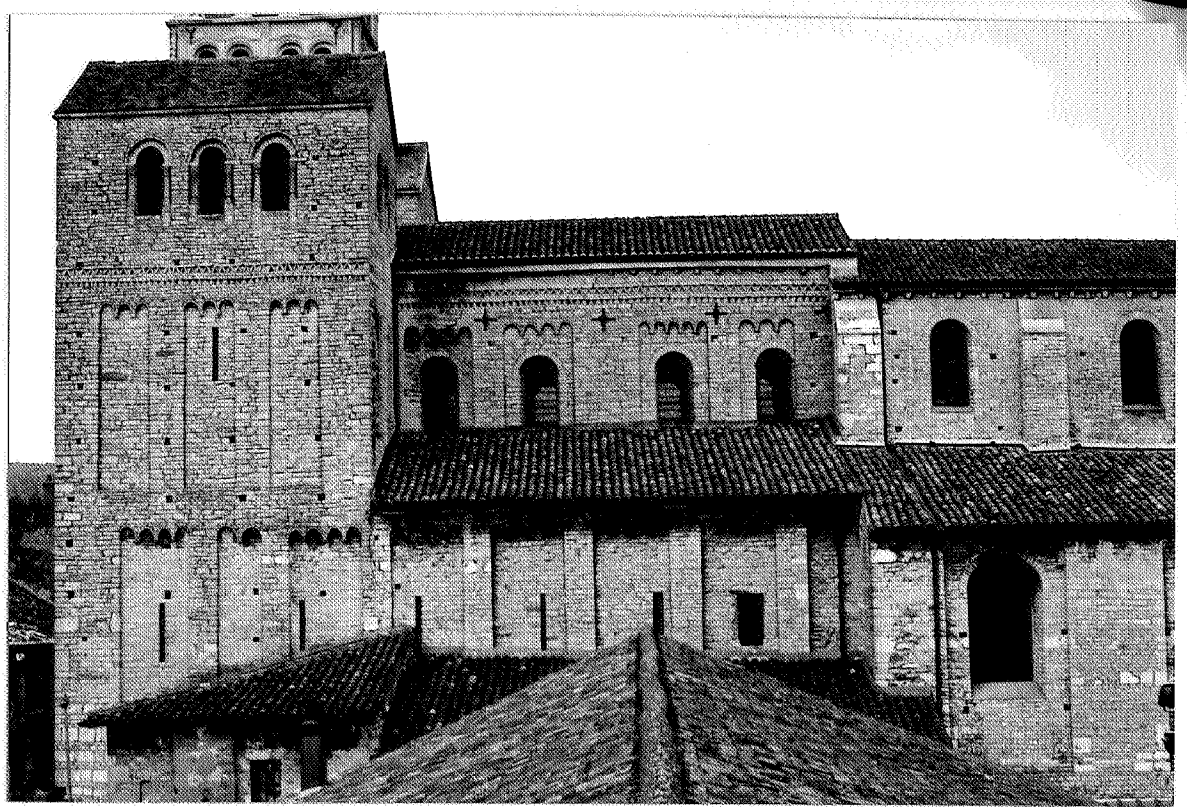
101. Tournus, église abbatiale Saint-Philibert : vue d'ensemble du côté sud de l'avant-nef (depuis le toit du cellier)
