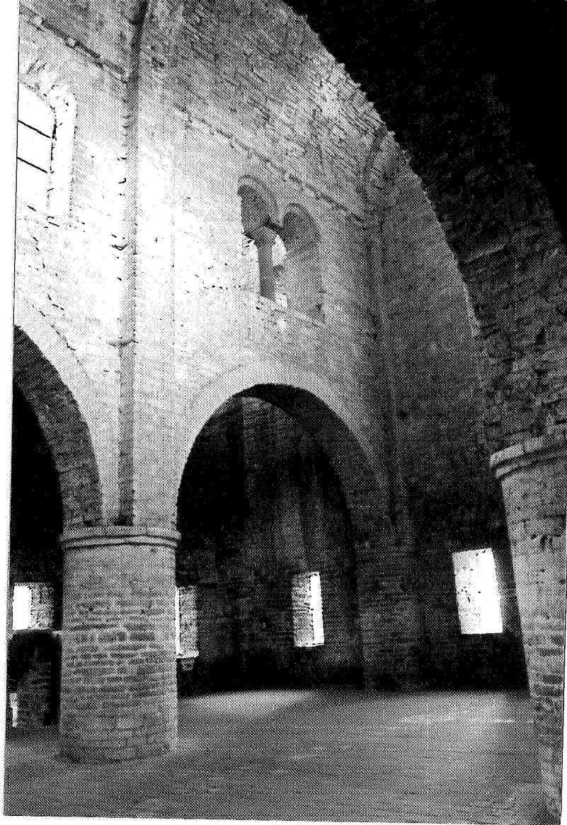
106. Vue de la partie sud-ouest de la chapelle Saint-Michel. Noter l'arcature géminée, à hauteur des fenêtres hautes, qui sépare le vaisseau central de la souche de la tour de façade
