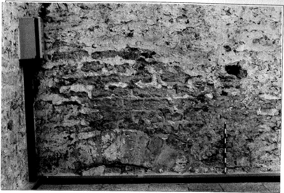
135. Cintre d'une ancienne porte murée, à l'extrémité méridionale de la façade ouest du cellier (vue depuis l'intérieur de la salle supérieure actuelle)
