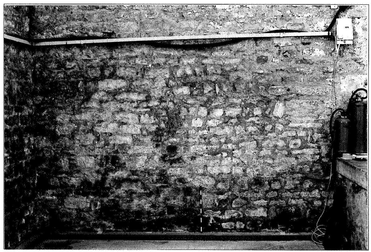
138. Revers du même mur, vu de l'intérieur du bâtiment actuel du réfectoire, au sud du portail actuel, du XVIIIe s. (le sol intérieur a été surcreusé au XVIIIe s.). Noter la reprise de l'angle sud-ouest (à gauche) et des parties hautes du mur, due aux travaux du XIIe s. La maçonnerie du XIe s. s'observe de la même façon au nord de l'entrée, en partie basse
