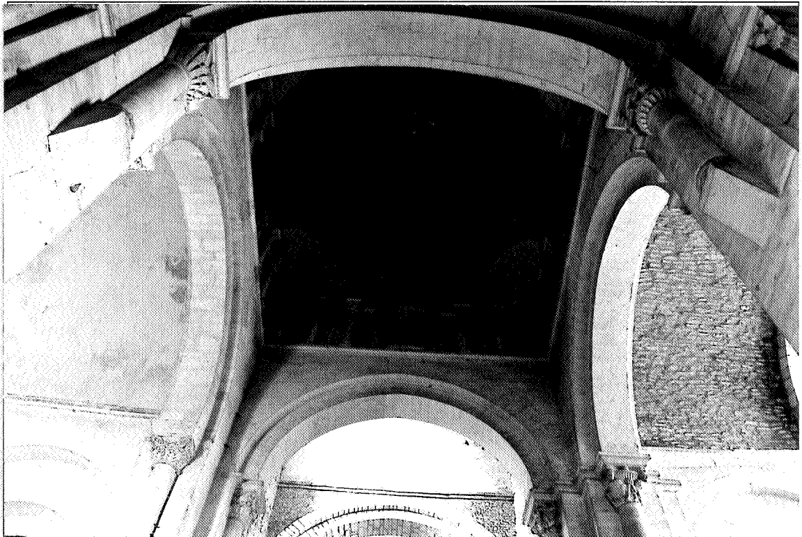
176. Vue intérieure de la coupole de croisée, en direction de la nef (vers l'ouest). Noter que le dernier arc doubleau de la nef obstrue en partie la baie haute occidentale
