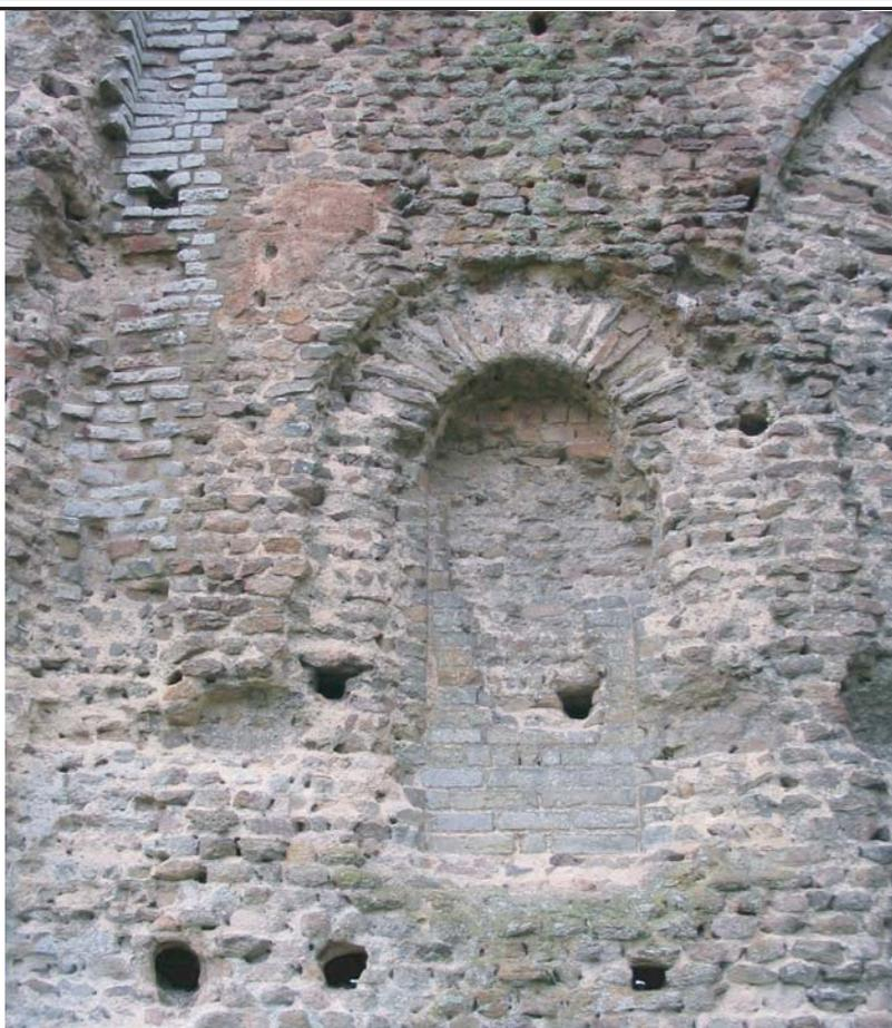
**Figure 151 :** La Genetoye - Négatifs de blocs de grand appareil, niche intérieure
