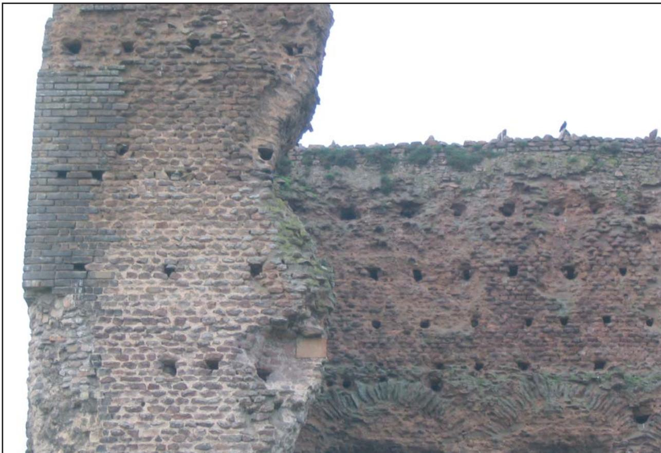
**Figure 150 :** La Genetoye - Départ du mur Est, amorce de l'arc de décharge au-dessus de la baie du second niveau
