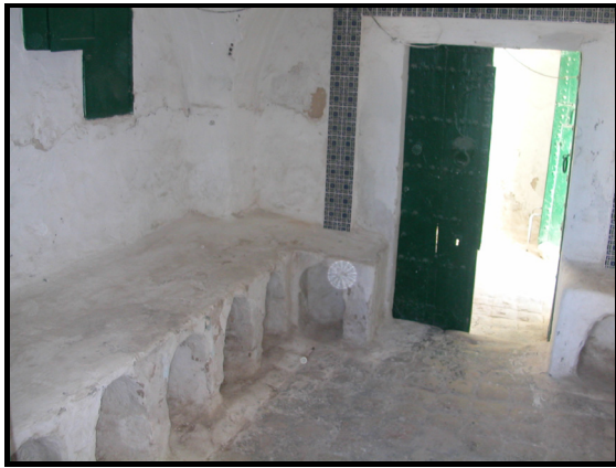
Fig. 289 : Lallā al-°Ağūla – le vestibule
