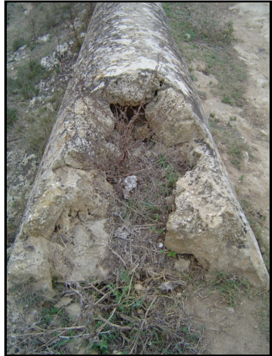
Fig. 230 : Le canal –détail 1
