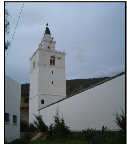
Fig. 200 : Le minaret de la grande mosquée occupant l'angle nord-ouest de l'édifice
