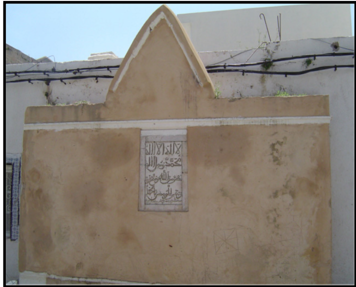
Fig. 65 : La façade du sbīl – Etat actuel
