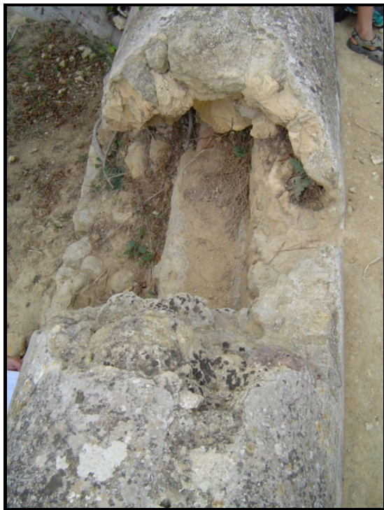
Fig. 231 : Le canal –détail 2
