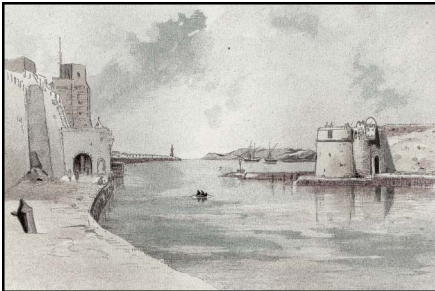
Fig. 15 : C'est entre le tour circulaire de la Qṣība (à droite) et Bāb al-rrṣāṣ (à gauche) qu'on tendait la chaîne qui a donné au monument le nom de Burğ al-salsla
