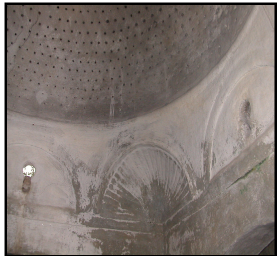
Fig. 286 : Trompe et départ de la coupole
