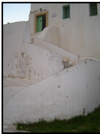
Fig. 129 : Mosquée Būṣaʿnūn – la porte de l'angle sud-ouest
