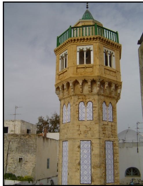
Fig. 56 : Le minaret – état actuel
