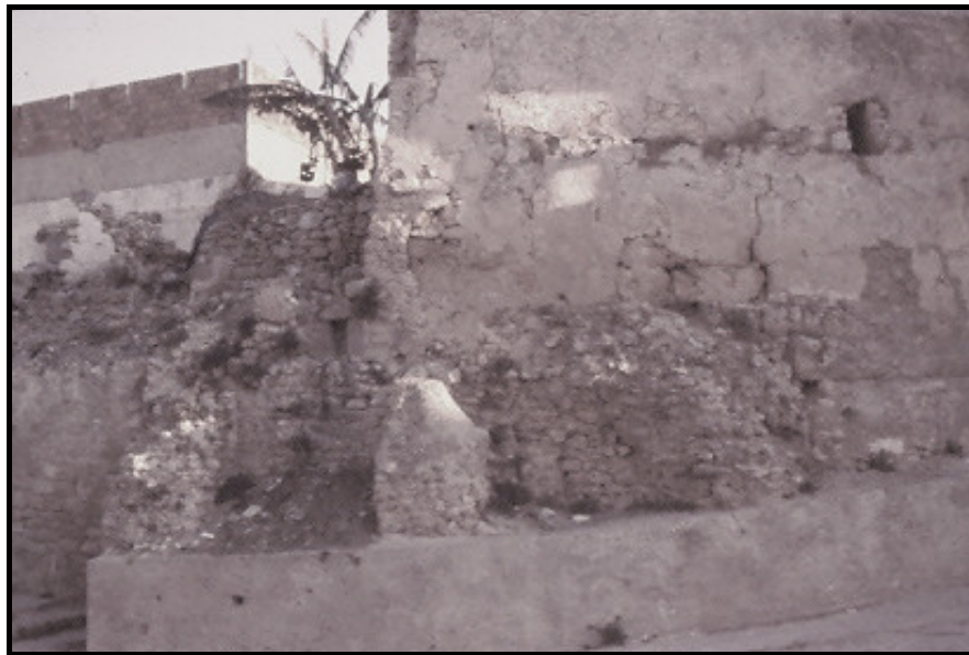
Fig. 244 : Le rempart de Rafrāf – le départ d'un petit contrefort en moellons
