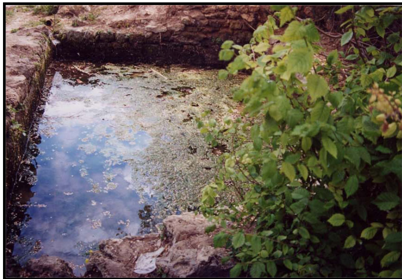
Fig. 246 : °Ayn al-Balad – le petit bassin
