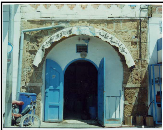
Fig. 214 : La façade de la fontaine Etat actuel
