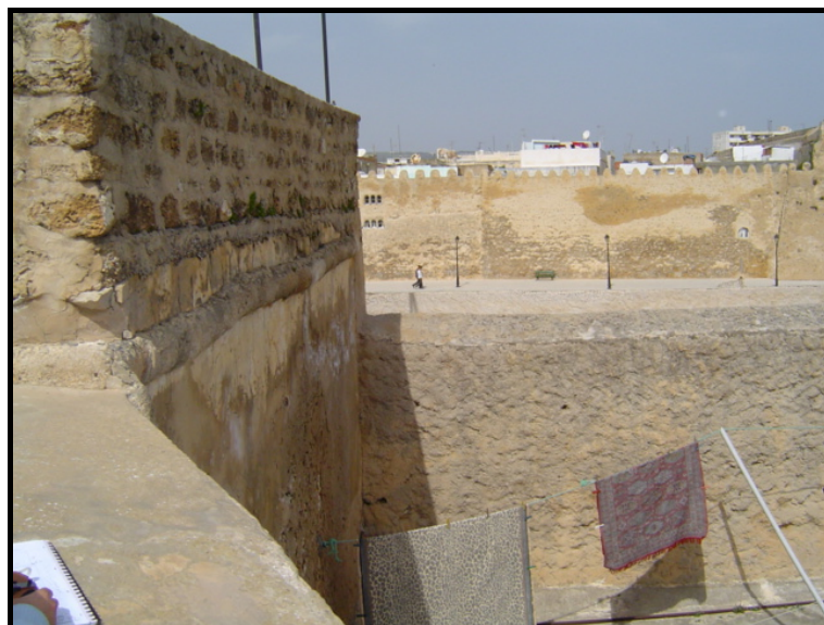
Fig. 16 : La zone d'intersection entre le mur de la demi-lune et l'unité rectangulaire
