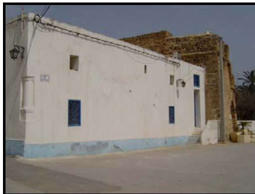
Fig. 22 : La façade extérieure sud
