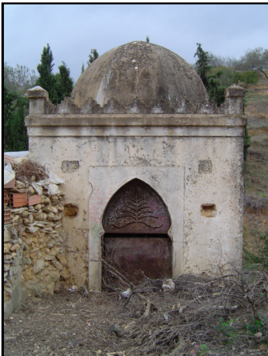
Fig. 227 : Un château d'eau - façade
