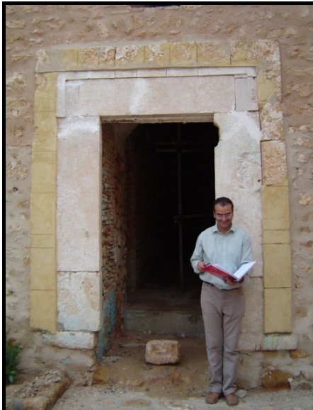
Fig. 162 : L'entrée de la salle de prière ouvrant sur la cour
