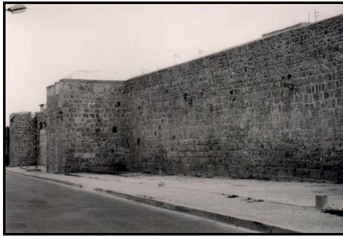
Fig. 38 : La courtine nord de la casbah – vue d’ensemble
