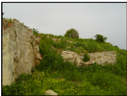
Fig. 116 : Le mur saillant sur l'angle sud-est du fortin
