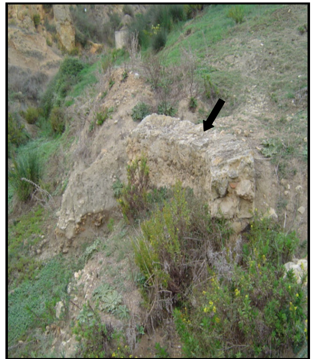
Fig. 228 : Les vestiges d'un bassin circulaire
