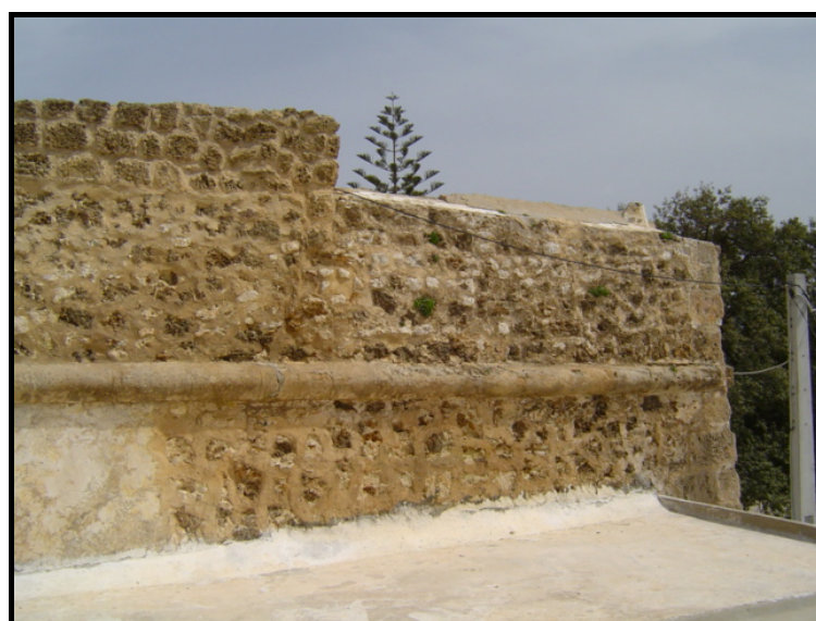
Fig. 17 : L'appareil du mur de l'enceinte - détail
