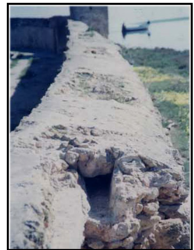
Fig. 183 : la conduite de l'enceinte -détail
