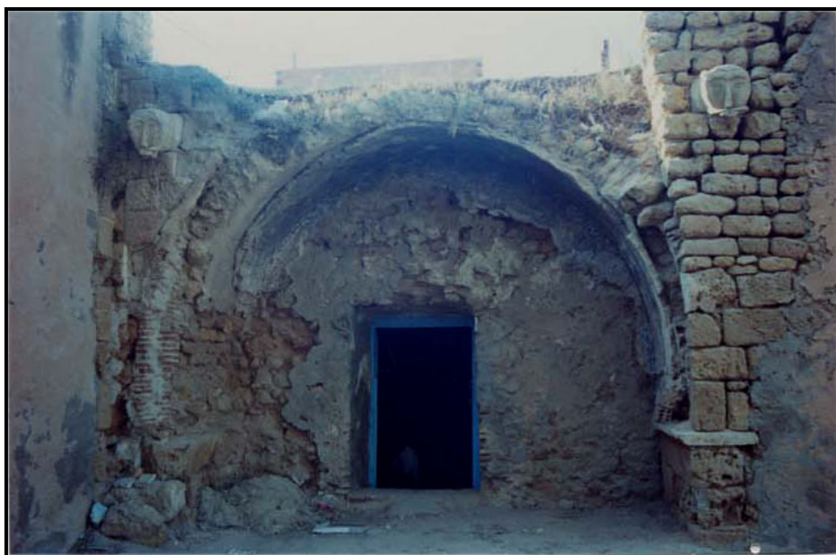
Fig. 184 : La façade de la fontaine – Vue d'ensemble
