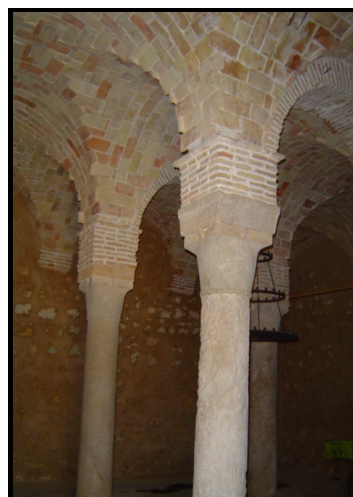
Fig. 148 : L'oratoire – détail des colonnes et de la toiture
