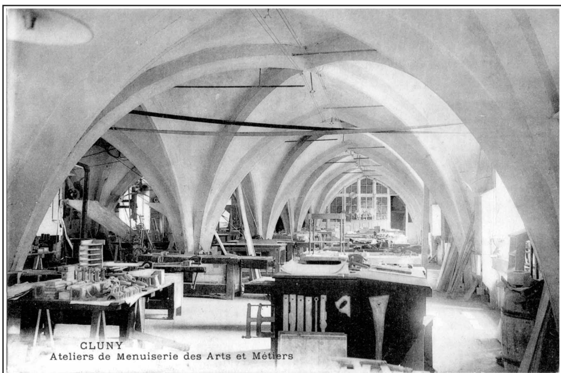
Fig. 214 : Cluny, abbaye, tour du Moulin, Farinier, cartes postales anciennes. En haut, vue de l'ensemble des bâtiments depuis l'aile sud du monastère du XVIII e siècle. En bas, atelier de menuiserie utilisant la force de la turbine hydraulique installée dans le moulin. L'atelier est établi sur un plancher construit à la hauteur des tailloirs du premier niveau du bâtiment. Cet étage pourrait correspondre au niveau intermédiaire mentionné en 1623 par Joseph du Chastrelet et appelé farinier par le frère.
