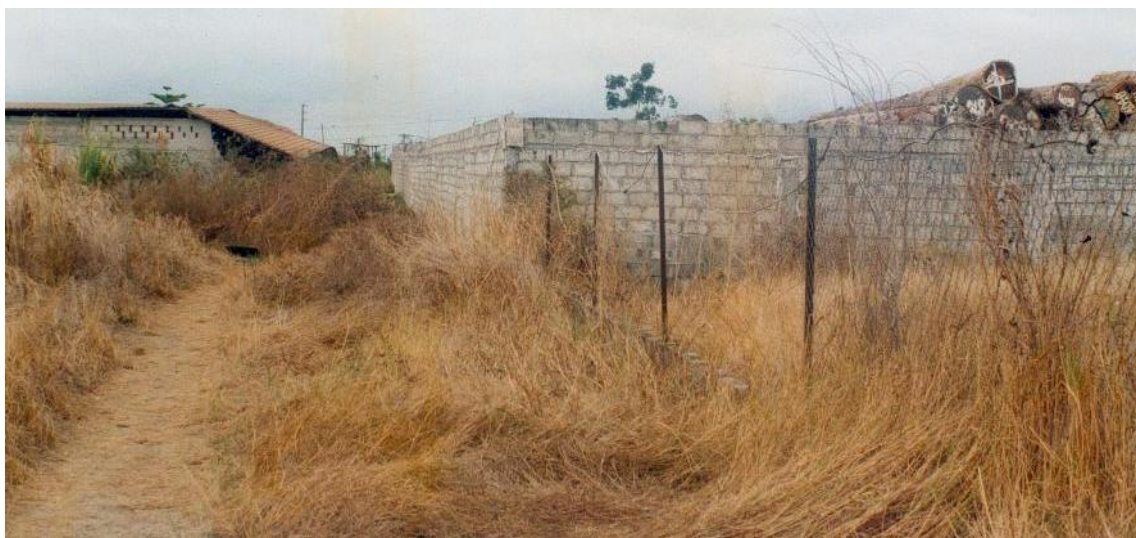
Photo 10 : Une maison partiellement détruite à Viriè Cliché Massala Mandongault, 13 avril 2002- 15h
