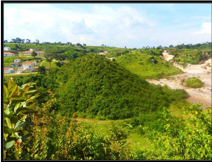
Photo 29 : La station d’assainissement d’eau (à gauche) et les chutes d’eau de Nabuyole (à droite).
