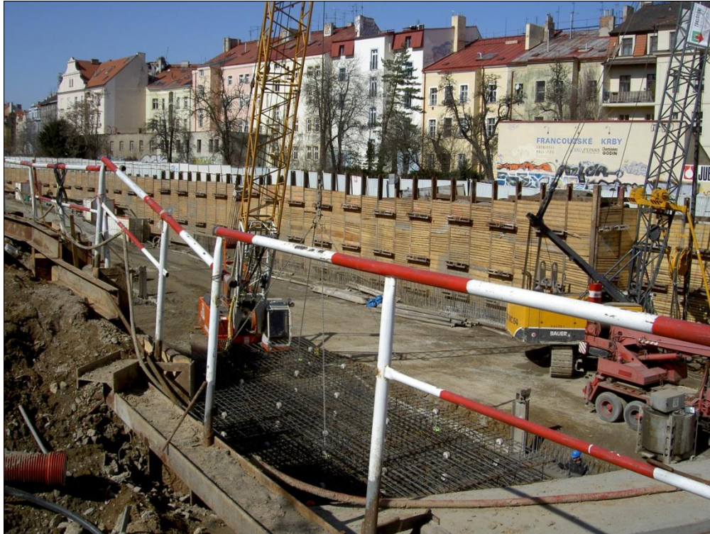
Figure 110 : Les travaux du tunnel Blanka à Letná
