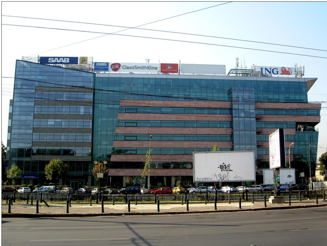
Figure 15 : L'Opera Business Center livré en 2001 : un immeuble de bureaux de classe A à Bucarest, Splaiul Independentei
