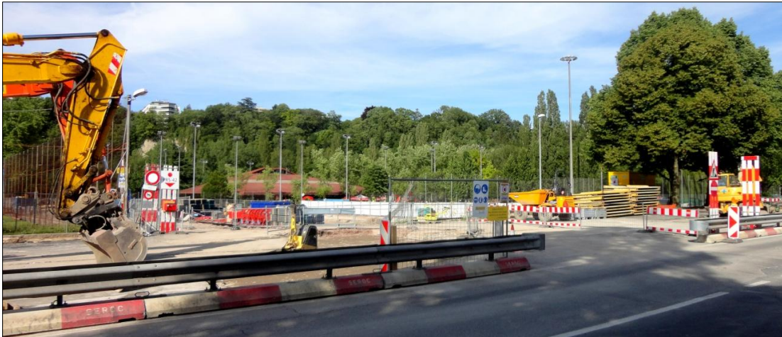
Figure 140 : Les travaux du CEVA à Carouge, route de Veyrier
