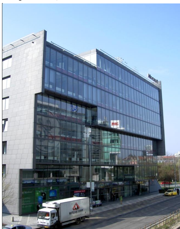
Figure 65 : Le siège de Microsoft en République tchèque, à Prague Pankrác, BB Centrum
