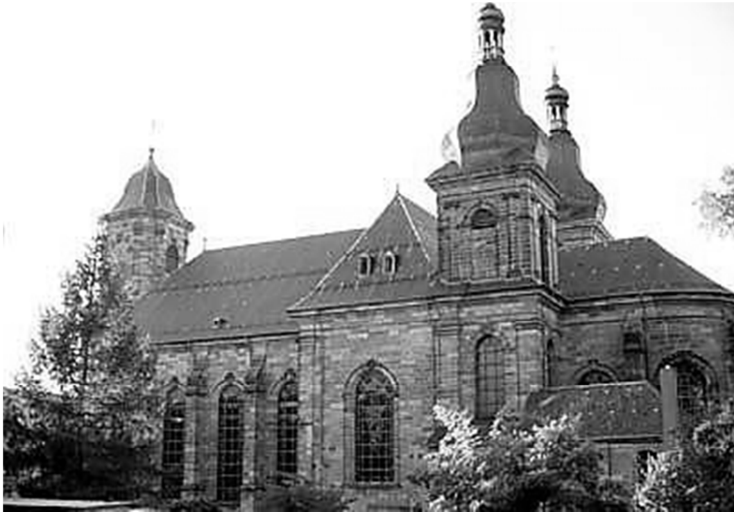
Élévation latérale nord de l'église abbatiale
