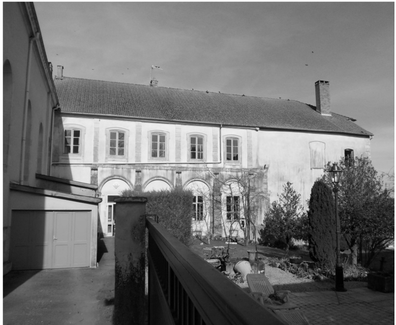
L'aile subsistante du cloître (état en 2012)
