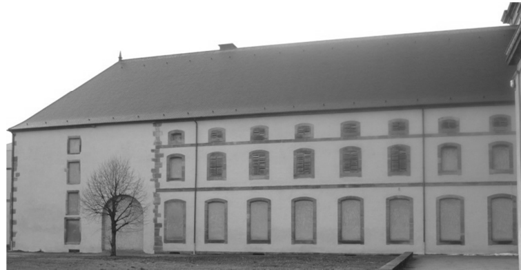
L'aile ouest du cloître après restauration (état en 2010)
