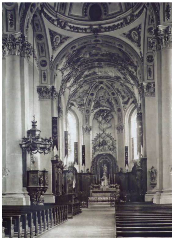
L'église abbatiale après les travaux de l'abbé Dicop (Arch. mun. Saint-Avold)
