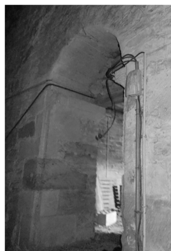
Ouverture sous comble Clocher du XII e siècle
