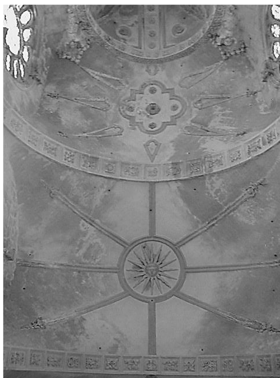
La voûte ornée du chœur
