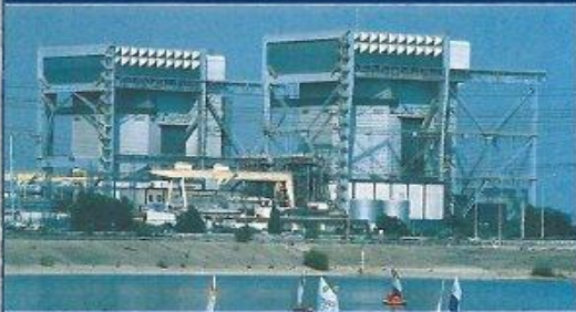
Centrale de St. Laurent près de Blois. Tranches 1 et 2, arrêtées en 1990 et 1992.
