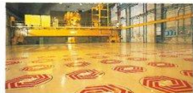
Hall de stockage de l'atelier de vitrification (déchets C) (Centre Cogema de la Hague)
