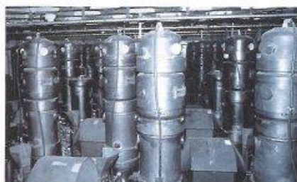
Chinon A2 : mécanismes de commande des barres de contrôle avant leur dépose
