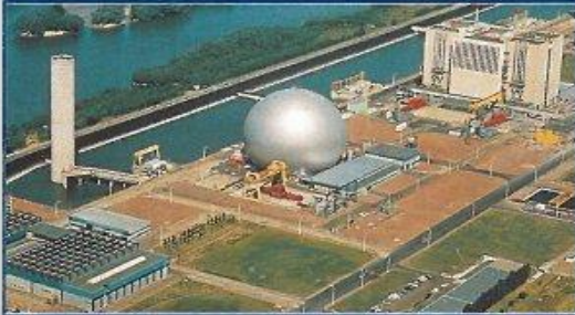
Centrale de Chinon sur la Loire. Tranches 1,2,3, arrêtées en 1973, 1985 et 1990.
