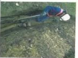
53 % des nouvelles fermes de moyenne tension créées au cours de l'année 2009 ont été éco-citoyennes
