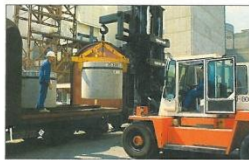
Chargement de fûts sur un site nucléaire
