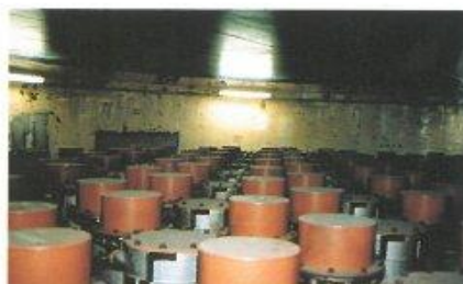
Chinon A2 : vue de la partie supérieure du réacteur après dépose des mécanismes de barres de contrôle
