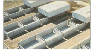
Alvéoles de stockage de déchets A au centre de Soulaïnes, dans l'Aube.
