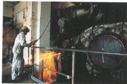
Centrale de Chinon A2 : découpe d'une tuyauterie du circuit primaire
