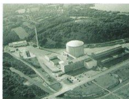
La Centrale de Brennilis dans les Monts d'Arrée en Bretagne, arrêtée en 1985, en cours de démantèlement
