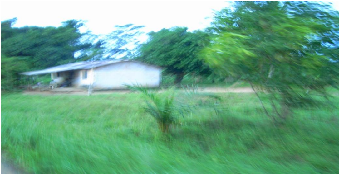
Photo 3 : Ecole catholique de Nzoghe-bang, logement du directeur, octobre 2007
