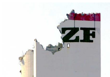
Photo 8 Grignotage de la tour AZF
