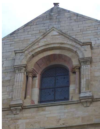
Fig. 176 : Église de Châteauneuf. Baie de la façade ouest
