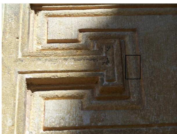
Fig. 147 : Linteau du portail ouest de La Bénisson-Dieu (détail).
