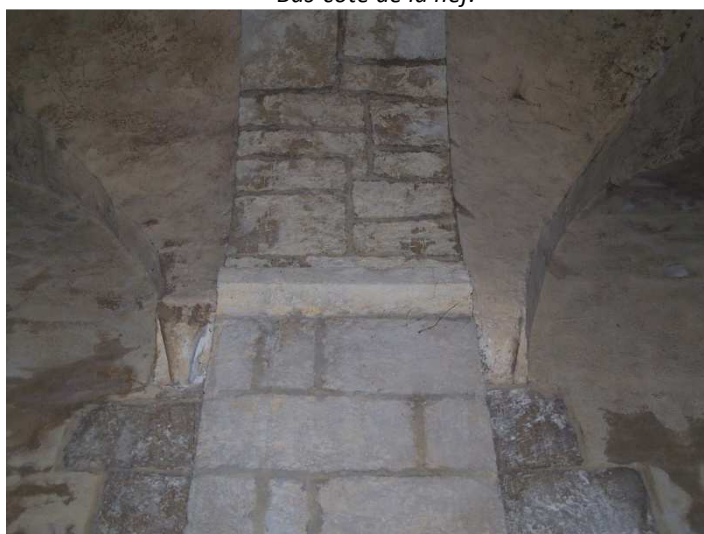
Fig. 122 : Anzy-le-Duc. Bas-côté nord de la nef. Retombée des arêtes contre le mur gouttereau
