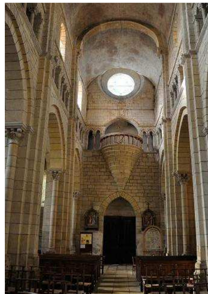
Fig. 234 : Église Saint-Hilaire de Semur-en-Brionnais – Revers de la façade (la voûte en berceau brisé a été remplacée au XIX e s. par un berceau plein-cintre)
