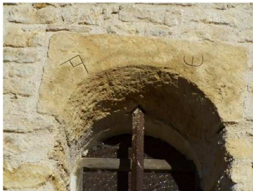
Fig. 134 : Versaugues – Marques lapidaires de la baie orientale du gouttereau sud
