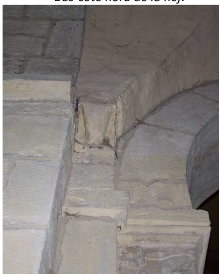
Fig. 121 : Anzy-le-Duc. Bas-côté nord de la nef. Retombée de l'arête sur une pile libre
