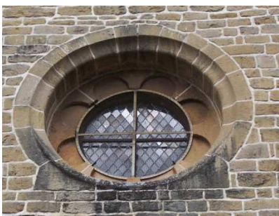
Fig. 200 : Oculus polylobé du transept de Châteauneuf. En Brionnais, l'église d'Aigueperse possède elle-aussi un oculus de ce type, dont l'usage est également fréquent dans les abbayes cisterciennes.
