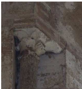
Châteauneuf. Baie du revers de la façade
