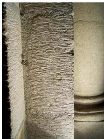
Fig. 114 : Semur-en-Brionnais. Pile de la croisée du transept.
