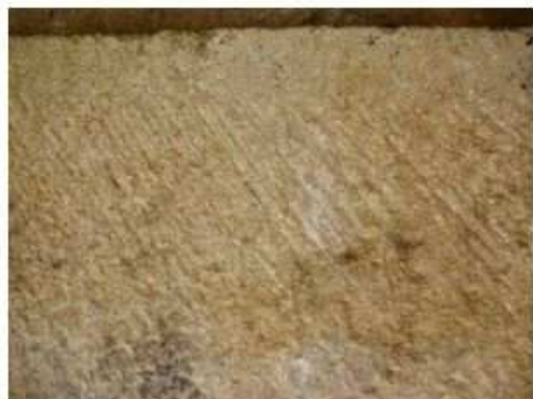
Fig. 113 : Exécution d'une pierre de taille
