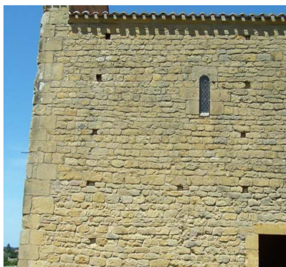
Baugy – Parement extérieur du mur gouttereau sud.
