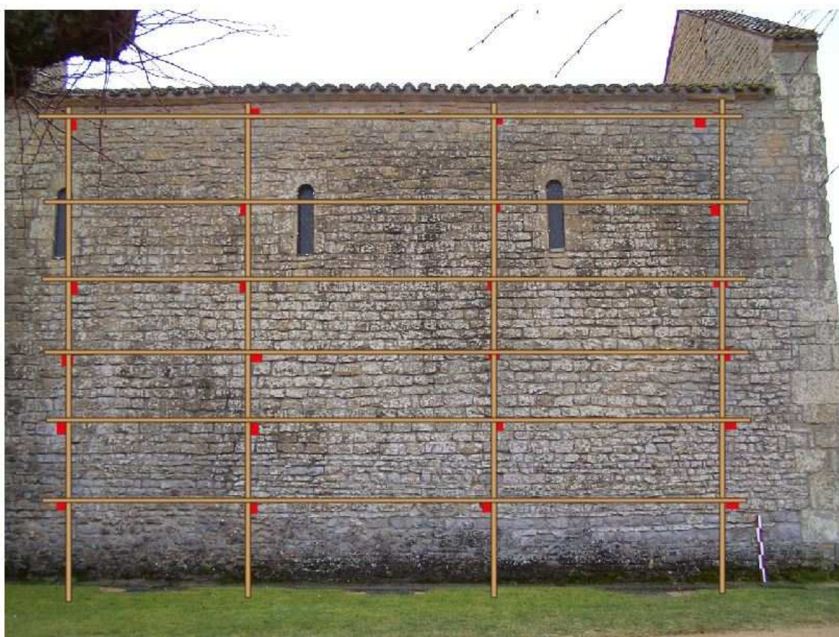
Baugy – Mur gouttereau nord. Tracé de l'alignement des perches et des plateaux d'après la position des trous de boulin.
