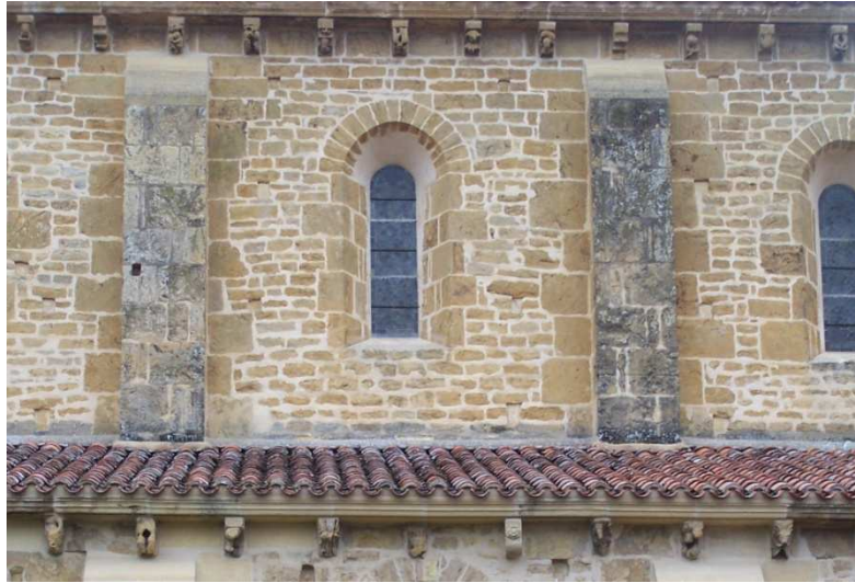
Un exemple de contrefort lié : la nef de la priorale d'Anzy-le-Duc
