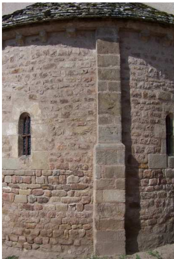
Un exemple de contrefort isolé : l'abside de Trivy
