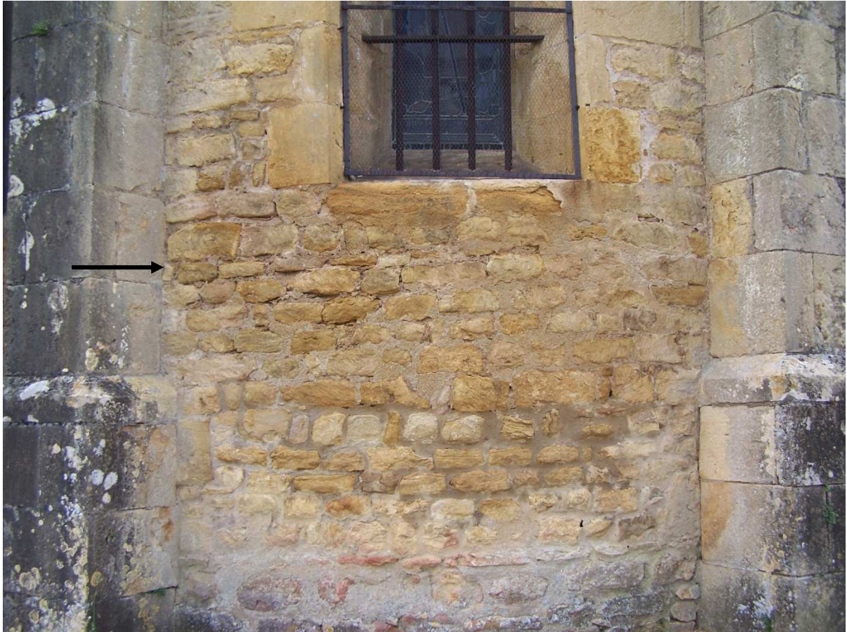
Iguerande, abside – Certaines assises du parement sont légèrement penchées pour rattraper les différences de hauteurs entre les blocs des deux contreforts. La flèche pointe une assise de calage qui disparaît sous la baie et ne se poursuit donc pas jusqu'au contrefort nord.
