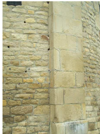
Un exemple d'assises réglées de hauteur : l'abside de Vareilles
