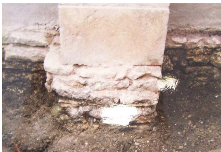
Montceaux-l'Étoile – Contrefort du mur gouttereau nord.
