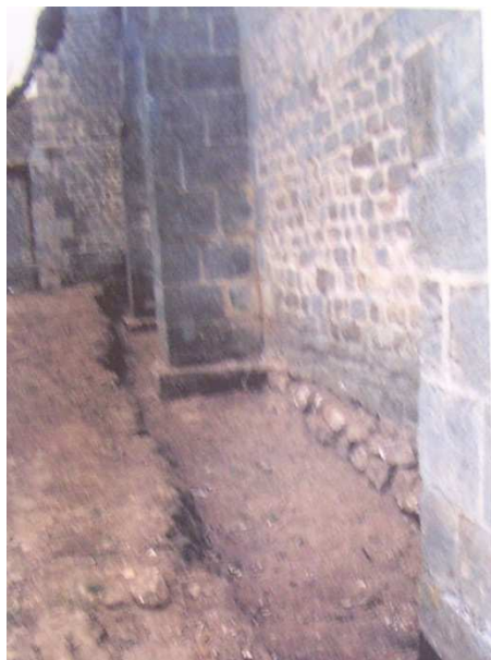
Varenne-l'Arconce – Semelle de fondation du mur gouttereau nord.
