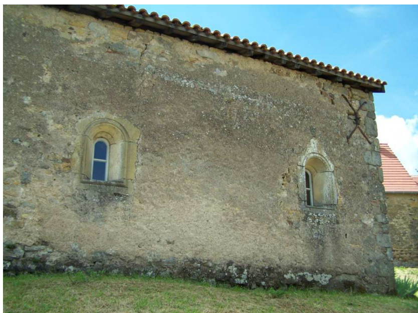
Fig. 9 : Nef. Mur nord
