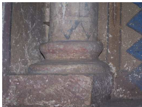
Fig. 14 et 15 : Arcature de l'abside, arc nord, colonnette de gauche
