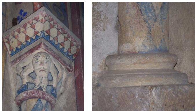
Fig. 24 et 25 : Arcature de l'abside, arc sud, colonnette de droite
