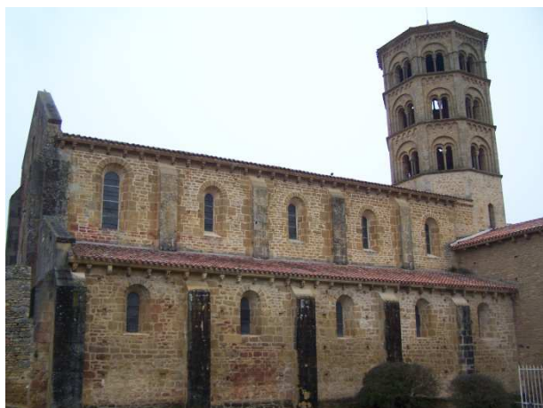
Fig. 5 : Mur gouttereau sud
