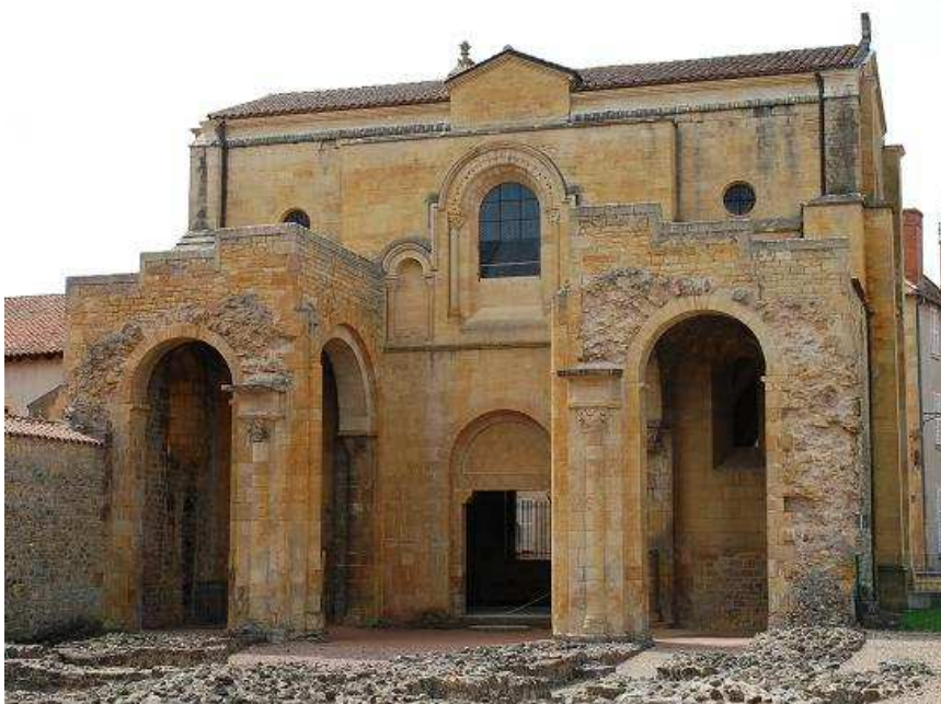
Fig. 2 : Seule la première travée de la nef et l'avant-nef sont conservées en élévation
