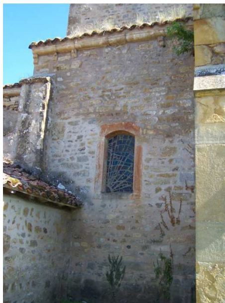
Fig. 5 : Mur sud du transept
