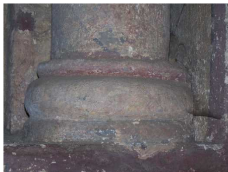
Fig. 12 et 13 : Colonnelle soutenant l'arc entre la travée de chœur et l'abside, côté nord
