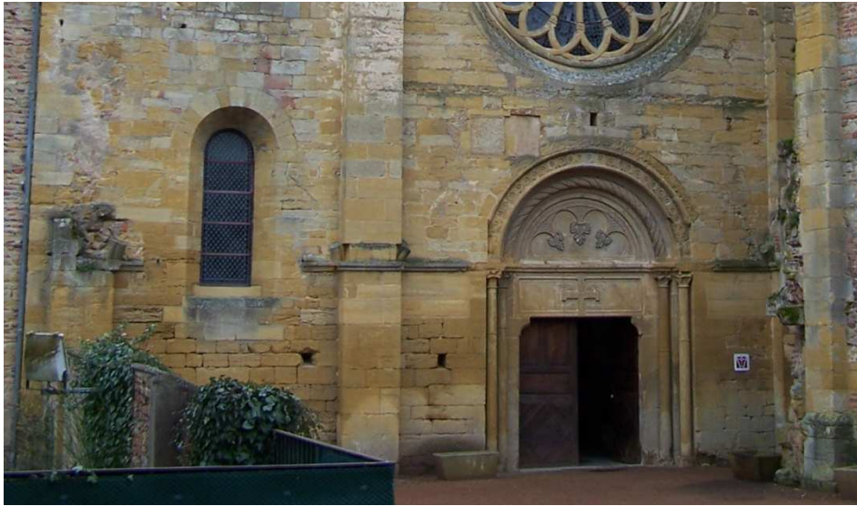
Fig. 43 : La façade porte les traces du bâtiment édifié à l'avant de la nef au XV e s., telles que 4 départs d'ogives.
