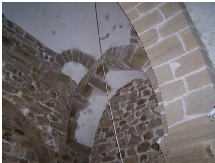
Fig. 3 : Transept, côté nord
