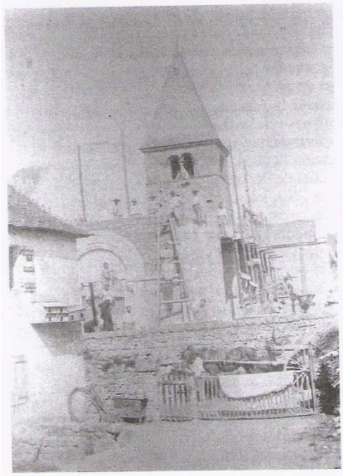
Fig. 2 : Photographie de la nef actuelle en construction. Vue depuis l'ouest.
