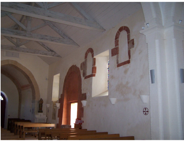
Fig. 12 : Mur gouttereau sud
