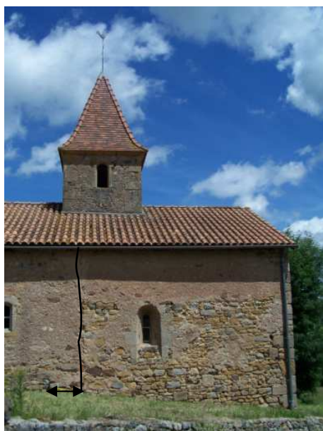
Fig. 15 : Mur sud, césure et arrachage du contrefort
