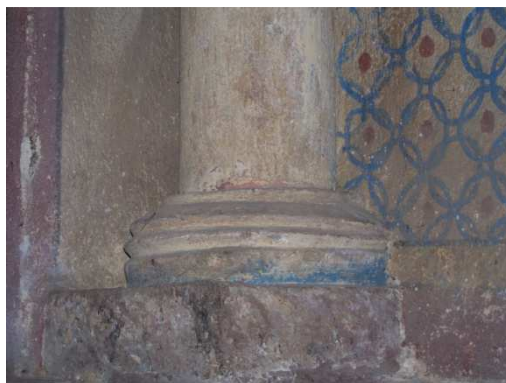
Fig. 22 et 23 : Arcature de l'abside, arc sud, colonnette de gauche
