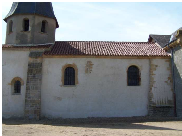
Fig. 9 : Mur gouttereau nord
