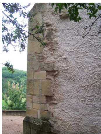
Fig. 8 : Angle nord-est du sanctuaire (arrachage du contrefort)
