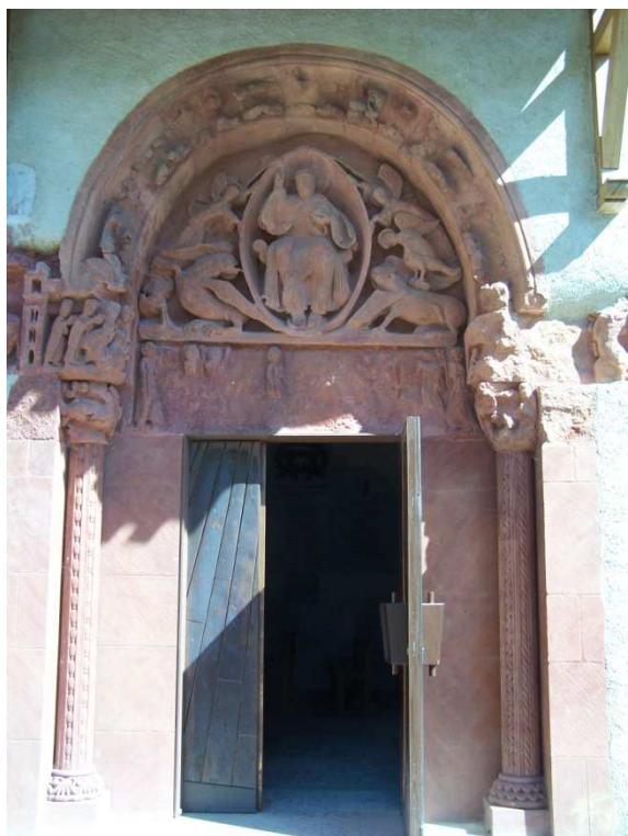
Fig. 13 : Portail du mur gouttereau sud
