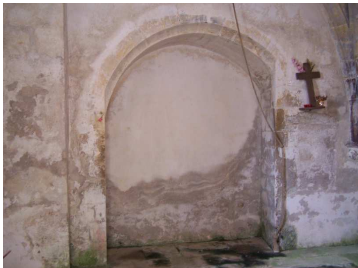
Fig. 14 : Chapelle, mur nord
