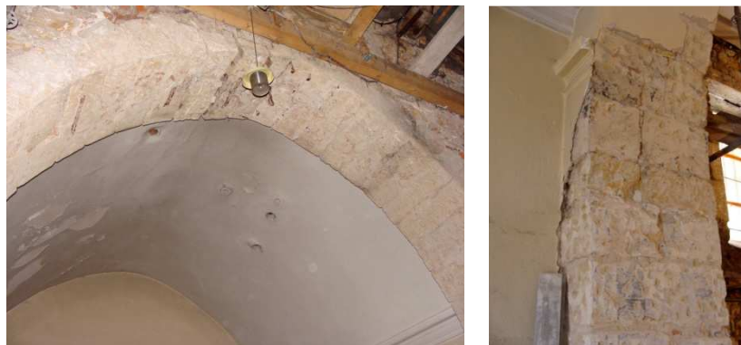
Fig. 19 et 20 : Arc triomphal, arc et piédroit sud. Photo prise pendant les travaux de 2008-2010 (S. Couture).
