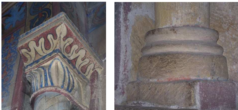
Fig. 26 et 27 : Colonnnette soutenant l'arc entre la travée de chœur et l'abside, côté sud
