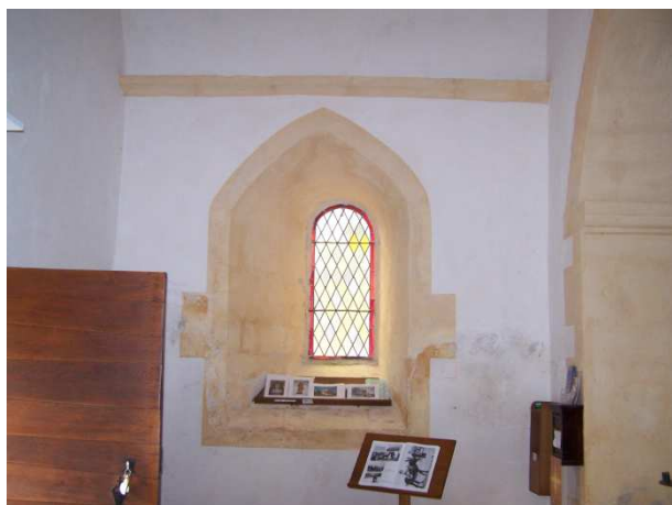
Fig. 4 : Travée de chœur, baie nord
