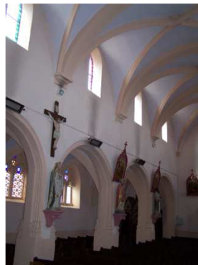
Fig. 5 : Travée de chœur et abside
