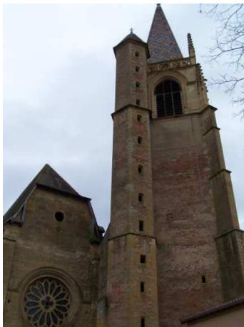
Fig. 42 : Le clocher édifié par l'abbé Pierre de La Fin. Le même abbé fait surélever la charpente de l'église, ce qui rehausse le mur pignon, comme cela est visible sur la façade de l'église, entre la rose et l'oculus, à la surface plus claire du parement.
