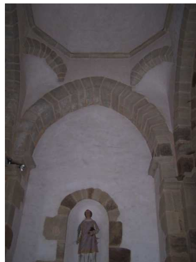
Fig. 4 : Transept, mur nord
