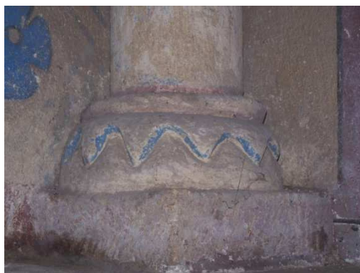
Fig. 20 et 21 : Arcature de l'abside, arc central, colonnette de droite
