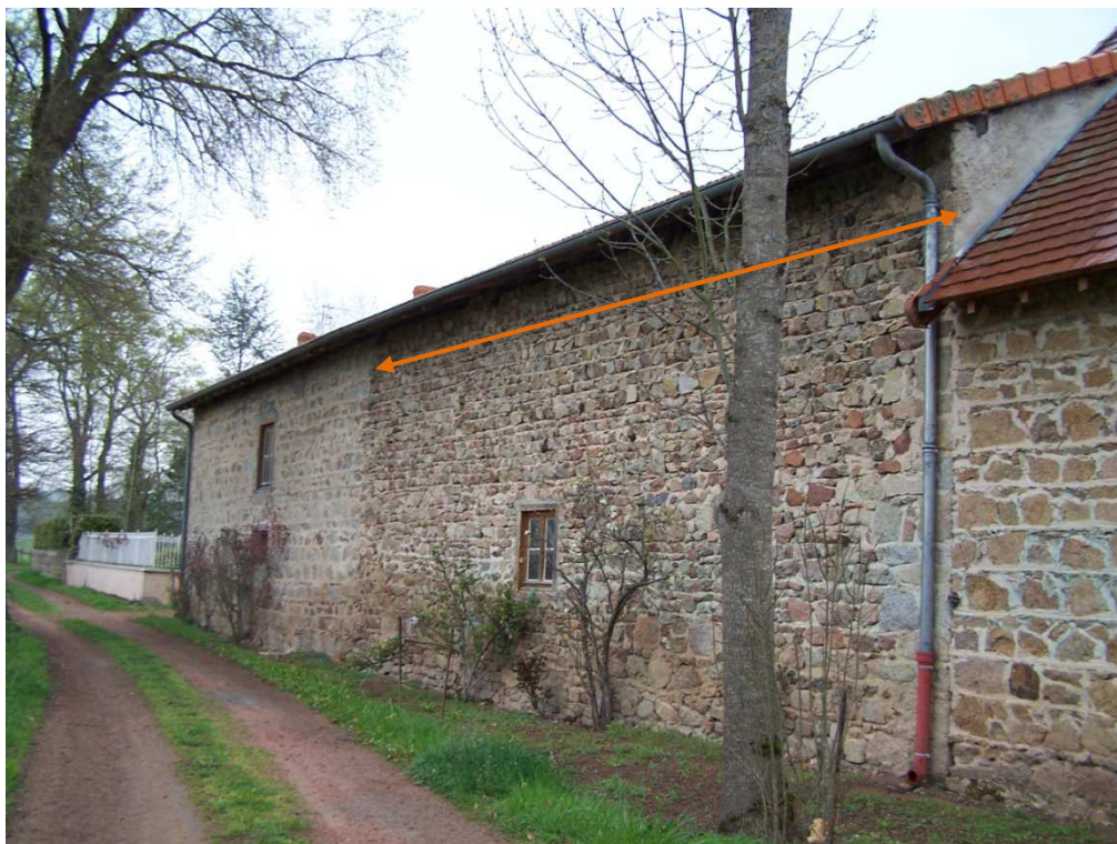
Fig. 2 : Entrepôt, mur nord
