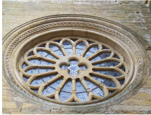
Fig. 33 : Oculus du gouttereau sud de la nef
