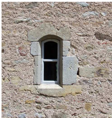
Fig. 7 : Nef. Mur sud. Baie ouest
