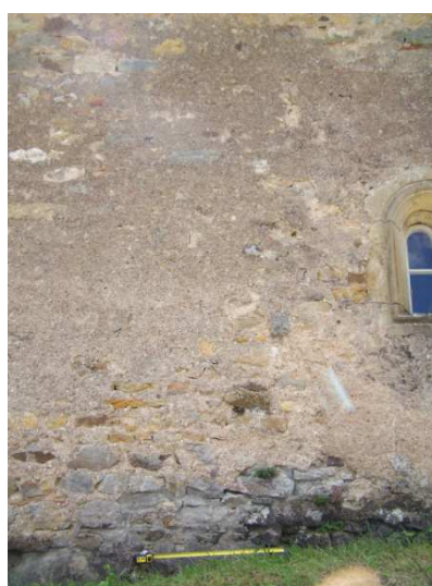
Fig. 14 : Mur nord, arrachage du contrefort
