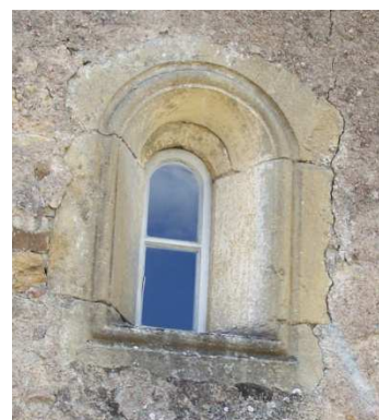
Fig. 10 : Nef. Mur nord
