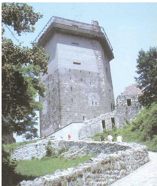
Fig. III.59. En haut à gauche, Hongrie, forteresse de Visegrád, tour Salomon : réintégration d'une grande lacune en béton armé, méthode II.C avec double différenciation. Source : Carbonara, 1997, p. 286.
