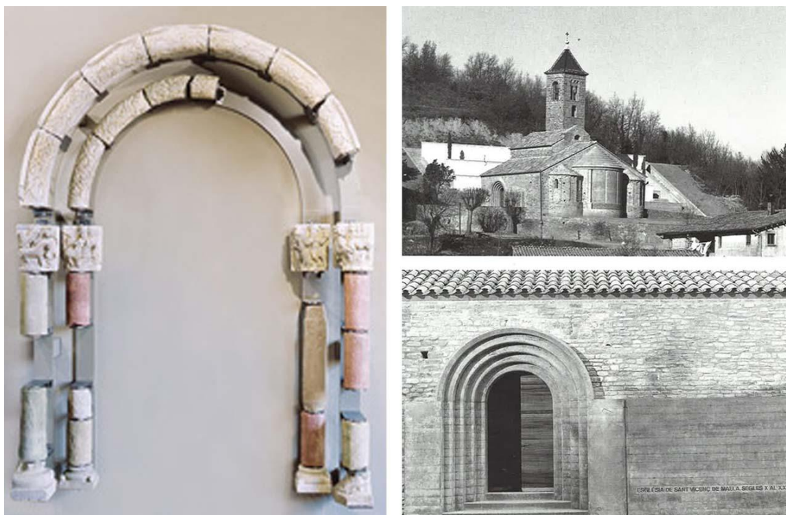
Fig. III.65. Ci-dessus, S.-Vicenç de Malla après les travaux. Côté Est, l'abside centrale est reconstruite en béton armé. La porte d'accès à l'église est rétablie à son emplacement d'origine, sur la façade Sud. La forme de cette nouvelle porte, avec arc et ses jambages, évoque la vibration formelle de la porte romane. Source : Antoni Gonzàles Moreno-Navarro, 1993-98, La restauració objetiva , volume II, p. 48. Source : fig. à droite, fragments de la porte romane, site internet musée diocésain de Vic, image n° 58019.
