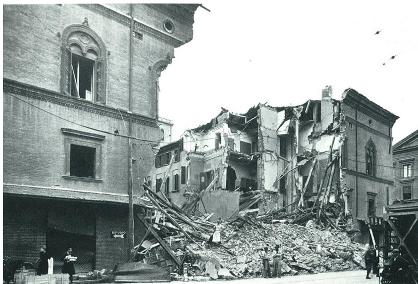
Fig. III.6. Ci-contre, Bologne (It.), palazzo Ghisilieri, état en 1944 après les bombardements alliés. La zone centrale de ce palais urbain est totalement détruite (grande lacune), des espaces intérieurs (chambres, salons...) se trouvent brusquement projetés à l'extérieur ; la façade est entière par endroit, inexistante à d'autres.
