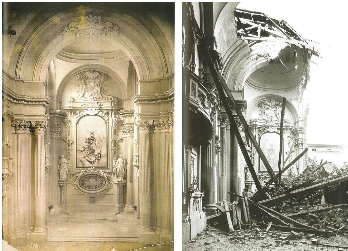
Fig. II.44 Bologne (It), Chapelle de S.-Filippo e Neri via Galliera. A gauche, la nef au début du XX e siècle. A droite juste après les bombardements aériens du 29 janvier 1944. N'ayant plus d'appui sur le mur droit, la ferme de charpente pèse dangereusement sur le reste de l'arc doubleau. Cet arc en brique doit s'écrouler ; sauf pour la zone d'appui dite du "tas de charge" (rayon théorique de 30°). Sur cette photo, la zone au-dessus du tas de charge teint, momentanément, elle tombera quelques temps plus tard Source : MiBACT, SBAP. Bo., fond Alfredo Barbacci.
