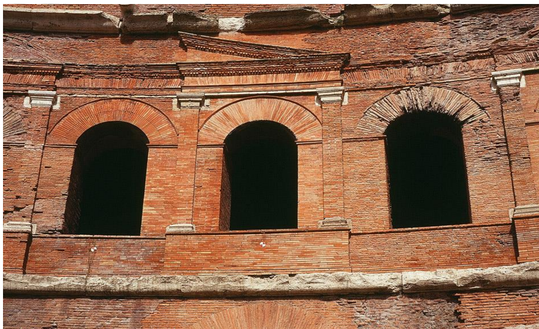
Fig. III.33. Rome (It.), marché de Trajan, étage supérieur de l'exèdre. Exemples de réintégration de parties dégradées et lacunaires avec la méthode II.A, in squadra . Ici pas de changement de matériau mais certaines zones sont réintégrées avec des briques nouvelles ayant reçu un traitement de surface différent (faces irrégulières, ou très lisses, profils triangulaires, etc). Source : photo N, Detry, 1992
