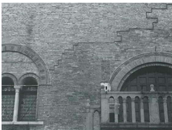
Fig. III.50. Ci-contre, Trévise (It.), palazzo dei Trecento , réintégration d'une grande lacune en façade avec la méthode II.B, même mur en brique, mais le joint creux, le scuretto , aide à la distinction ; en plus, la date de l'intervention de restauration (1948) est gravée dans plusieurs briques en façade, d'autres dates sont apposées à l'intérieur du monument également sur les peintures murales.
