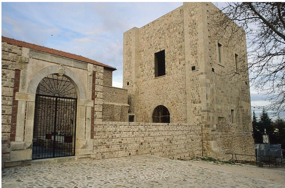
Fig. III.40. Castello Longobardo , à gauche le portail et un mur d'enceinte sont restaurés avec la méthode II.A (mur en moëllon avec lits de briques); à droite, les façades de la tour carrée sont réintégrées avec la méthode I.A (mur en moëllon de pierre calcaire en sottosquadro ). Source : photo N. Detry, 1999.
