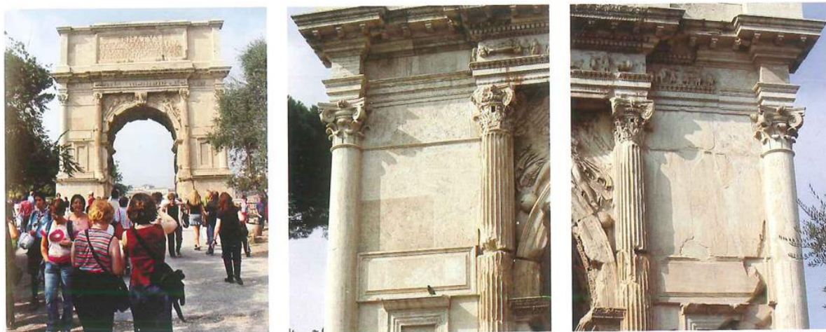
Fig. III.32. Rome (It.), l'arc de Titus au début de la Via Sacra, sur le forum antique, restauration par anastylose des parties latérales et de l'étage d'attique, méthode II.A. Ici deux dispositifs assurent la différenciation : l'intégration est en travertin alors que la partie ancienne est en marbre, simplification des profils et des modénatures et absence de personnage sculpté dans la frise pour le nouveau. Source : Marconi, 2005 p. 65.
