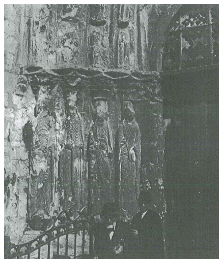
Fig. III. 86. A droite ci-dessus, Provins (Fr.), église Saint-Ayoul, ancien Prieuré, état en 1945. Le porche est orné de remarquables statues-colonnes du XII e siècle ; en plus de la dégradation par la pollution (croûtes noires), ces statues en pierre sont criblées d'impacts de balles, elles sont lacunaires.
