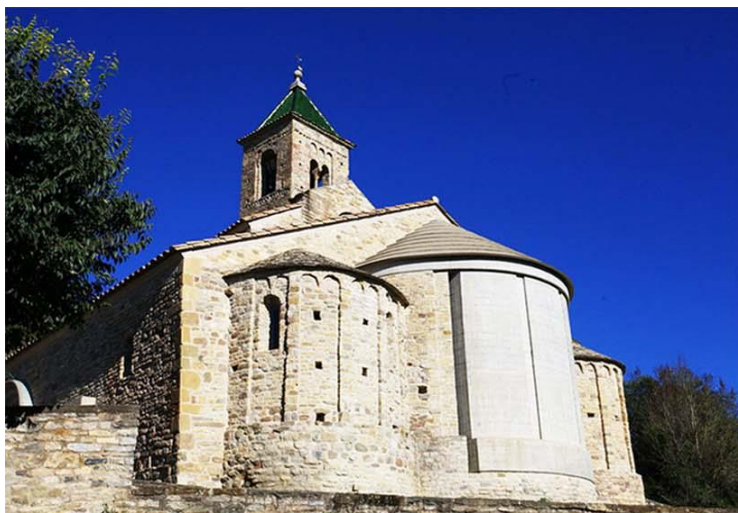
Fig. III.66. Ci-dessus, S.-Vicenç de Malla, entre les deux absidioles restaurées, l'abside centrale rétablie en béton armé avec un traitement de surface lisse mais dessinée. Les lésènes et les bandes lombardes ne sont pas reprises dans la partie neuve mais juste évoquées par un jeu dans le béton. A gauche, l'abside centrale en béton vue depuis l'intérieur du sanctuaire, avec l'autel. A droite, une fente laisse passer la lumière entre le voile de béton et la maçonnerie de pierre.
