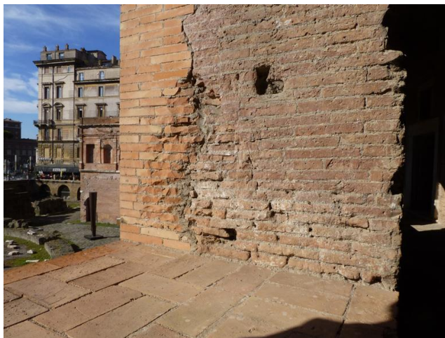
Fig. III.34. Rome (It.), marché de Trajan, détail de la réintégration des briques avec la méthode II.A, in squadra . Ci-contre, le raccord du jambage de la baie avec l'épaisseur du mur. Restauration réalisée dans les années 1930 par Antonio Colini et Antonio Muñoz.
