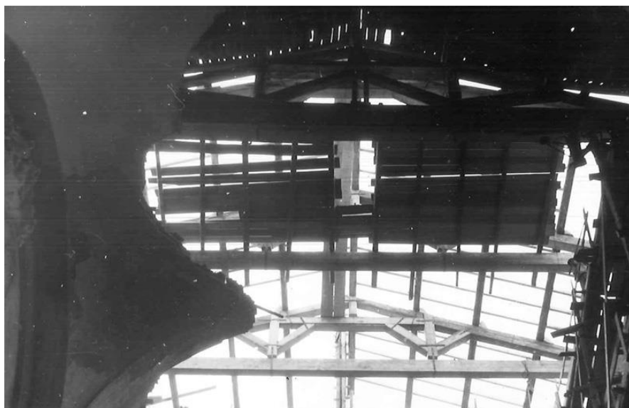
Fig. II.48 Bologne, chapelle de S. Filippo-Neri. Ci-contre, en haut, la mise en œuvre de la nouvelle charpente en bois, vers 1949 / 1950.
