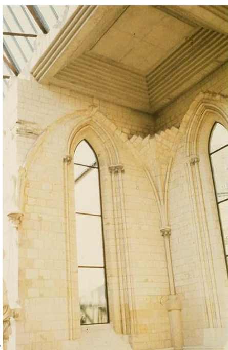
Fig. III.66. Ci-dessus, S.-Vicenç de Malla, entre les deux absidioles restaurées, l'abside centrale rétablie en béton armé avec un traitement de surface lisse mais dessinée. Les lésènes et les bandes lombardes ne sont pas reprises dans la partie neuve mais juste évoquées par un jeu dans le béton. A gauche, l'abside centrale en béton vue depuis l'intérieur du sanctuaire, avec l'autel. A droite, une fente laisse passer la lumière entre le voile de béton et la maçonnerie de pierre.
